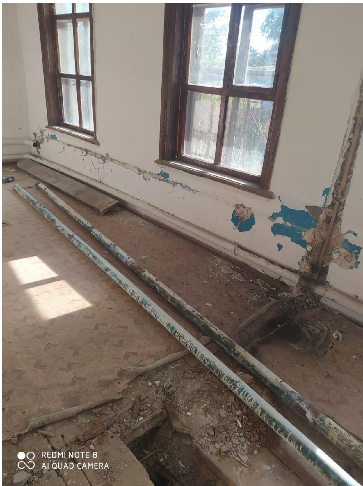
Ремонт штукатурки стен
