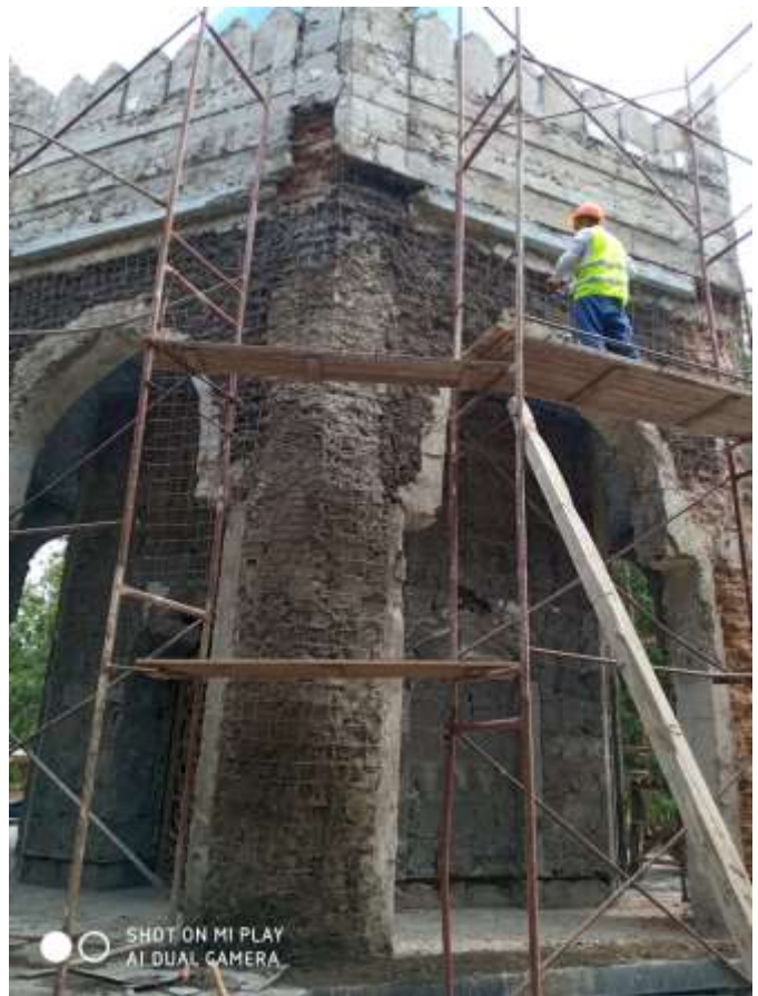
Стены. Оштукатуривание по сетке без устройства каркаса улучшенное
