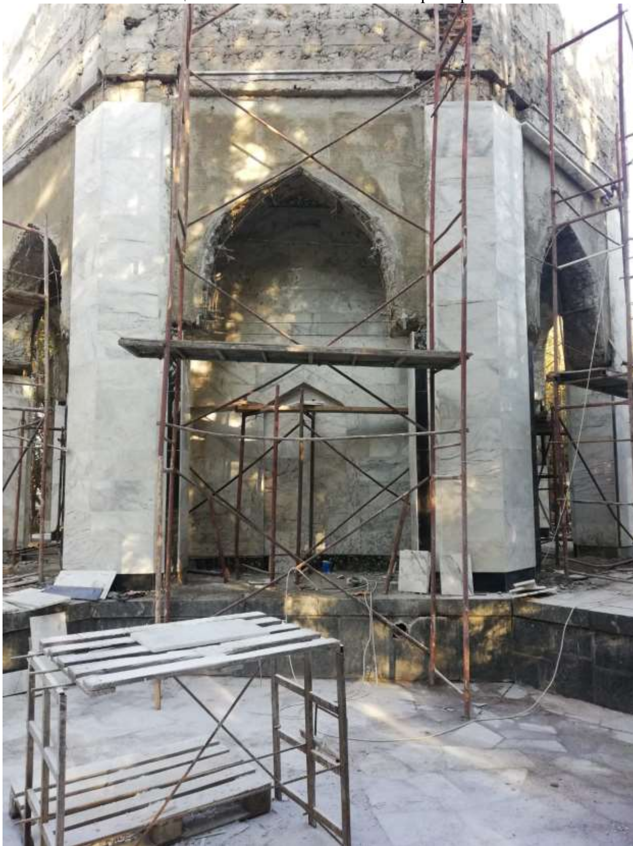
Облицовка стен мавзолея из плит мраморных
