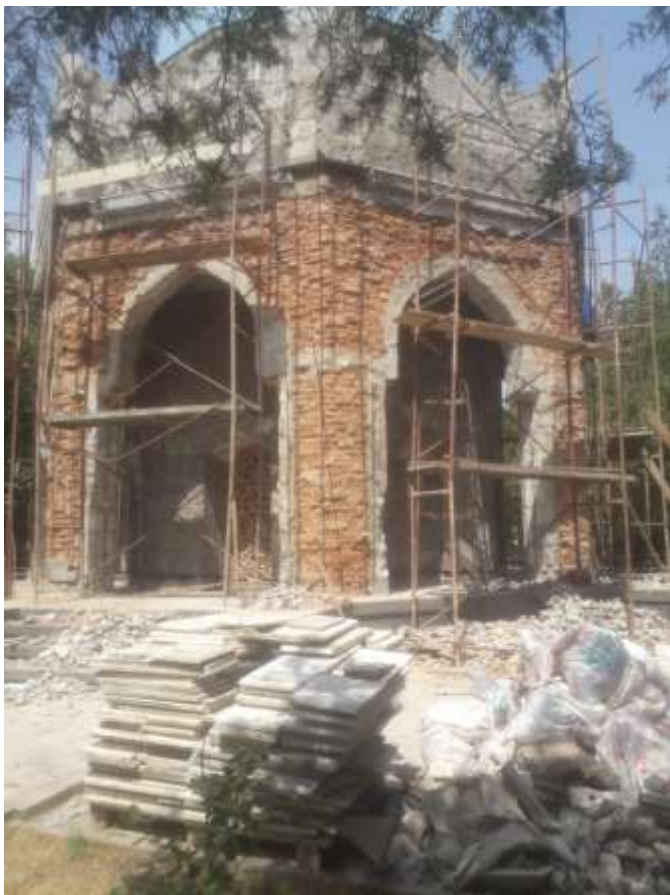
Стены. Оштукатуривание по сетке без устройства каркаса улучшенное
