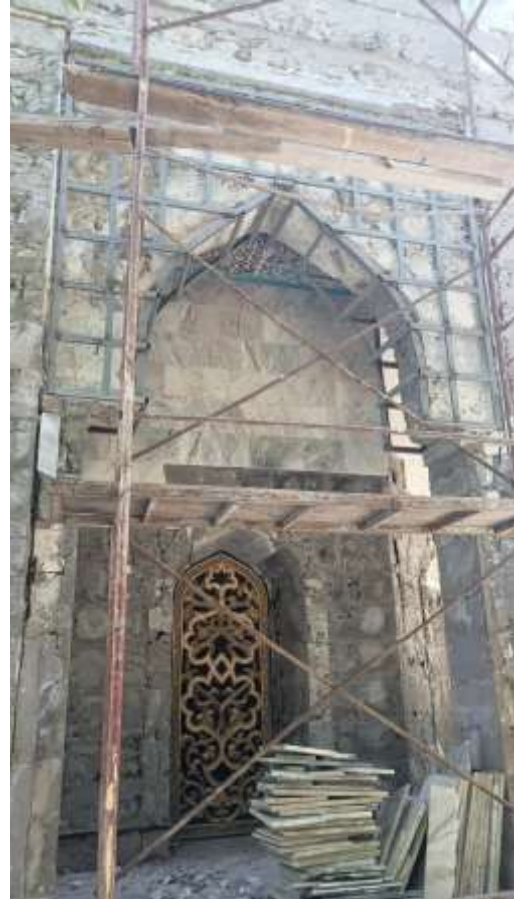
Стены. Оштукатуривание по сетке без устройства каркаса улучшенное
