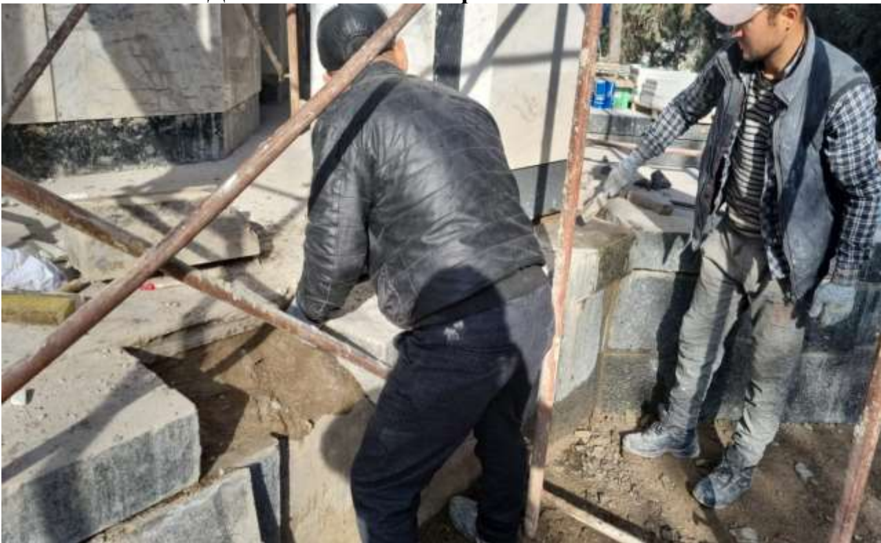
Демонтаж и монтаж гранита стилобата
