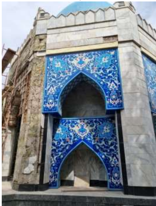
Облицовка стен из плит мраморных. Разборка
