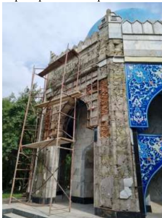
Облицовка стен из плит мраморных. Разборка
