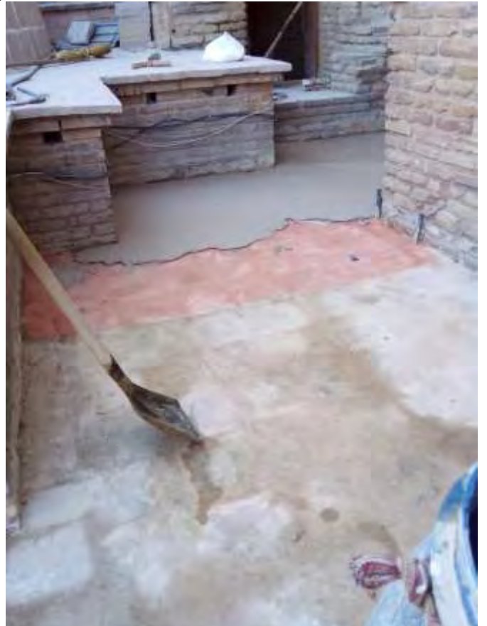
Работы по устройству стяжки по сетке на кровли Малого Аксарая, Коридор 5,6
