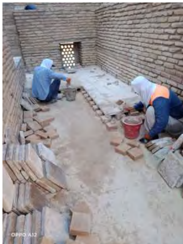
Реставрация покрытия плоской кровли над Северным порталом. Устройство стяжки по сетке Китапханы, Мечети, Коридор 3, Коридор 4
