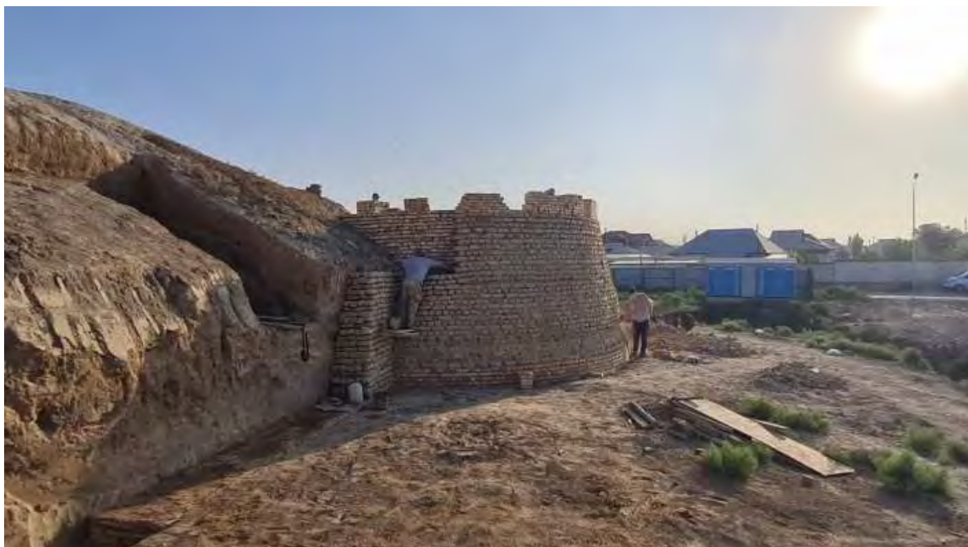
Обратная засыпка башни крепостной стены грунтом с послойным трамбованием
