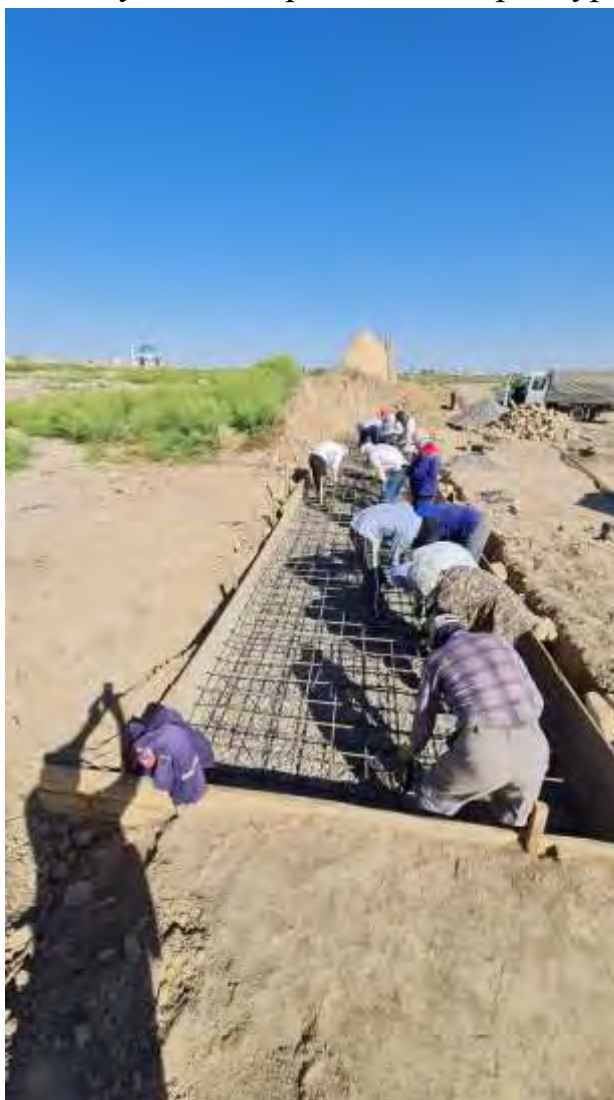
Армирование – укладка строительной арматурной сетки
