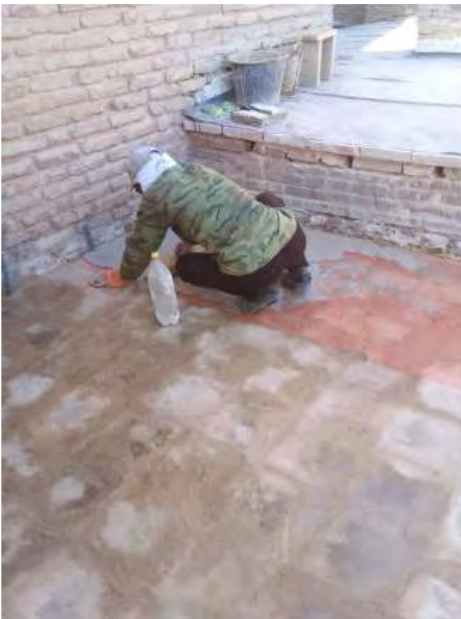
Работы по устройству стяжки по сетке на кровли Малого Аксарая, Коридор 5,6
