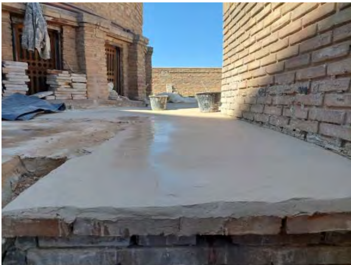
Устройство гидроизоляции в три слоя рубероида на кровле Китапханы, Мечети, Коридор 3, Коридор над Северным порталом, Коридор 4
