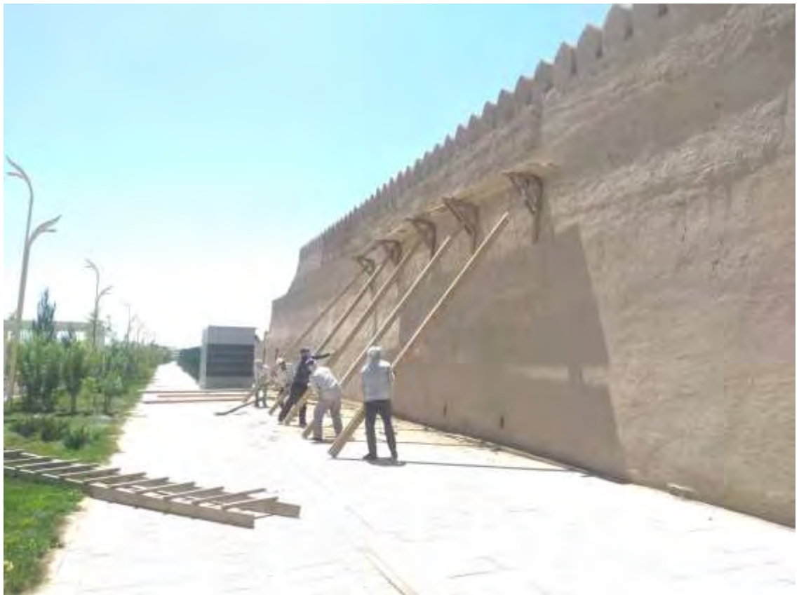
Штукатурка стен глиняным раствором - 463 м 2
