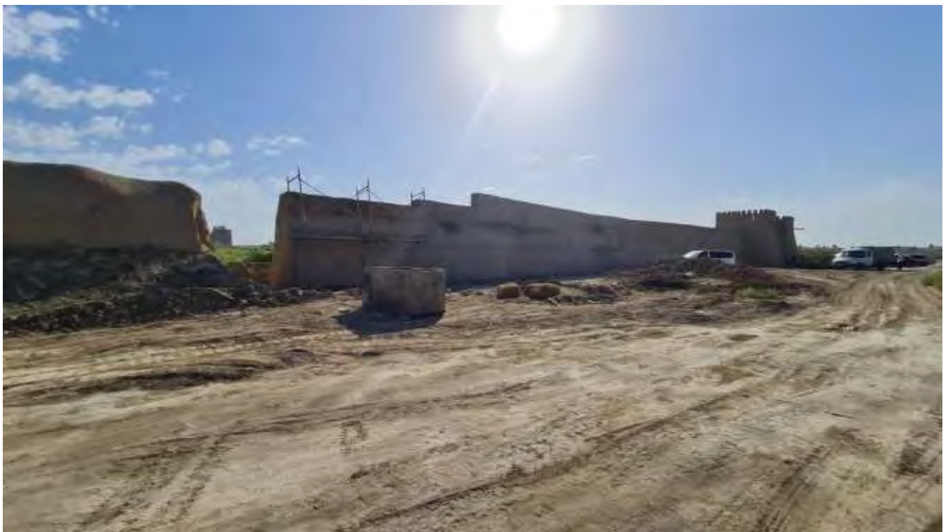
2-й слой штукатурка глиняным раствором с добавлением рисовой шелухи
