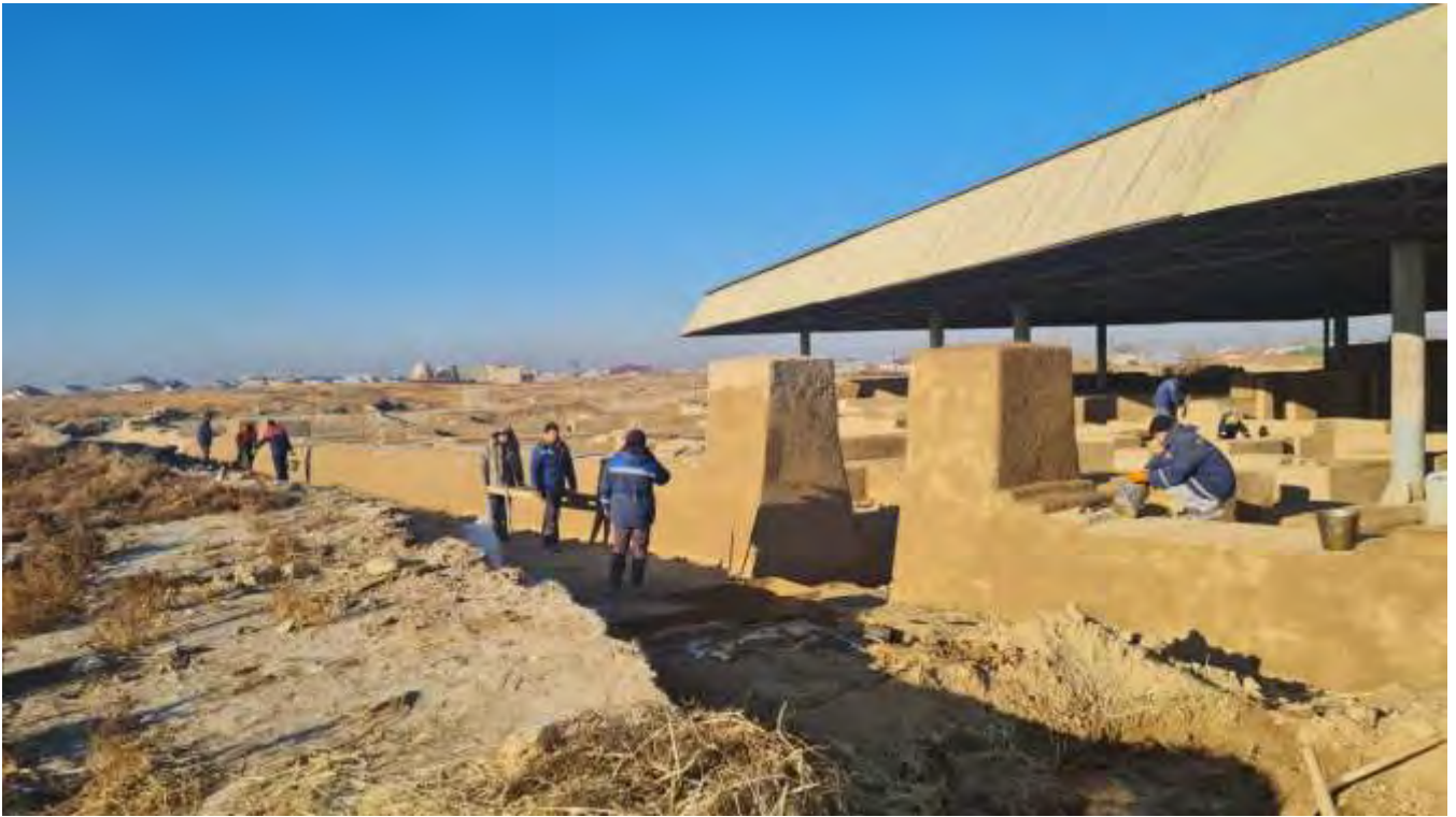
Кладка стен в юго-восточной и юго-западной планировочной структуре
