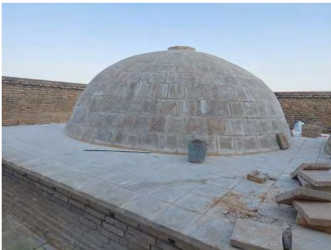
Реставрация покрытия плоской кровли над Ильясхановской нишей. Демонтаж покрытия кровли Ильясхановской Ниши
