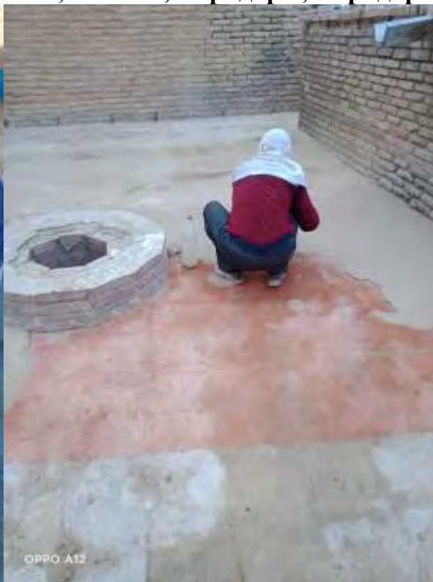
Реставрация покрытия плоской кровли над Северным порталом. Устройство стяжки по сетке Китапханы, Мечети, Коридор 3, Коридор 4
