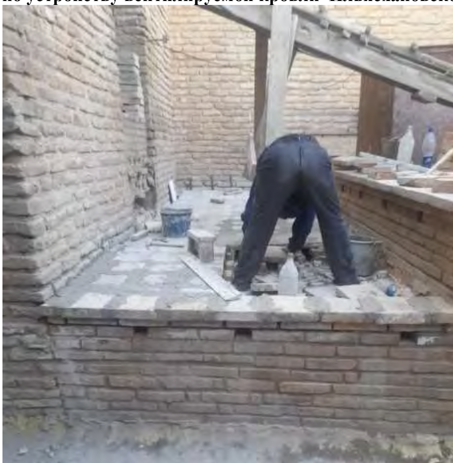
Работы по устройству стяжки по сетке Ильясхановской Ниши
