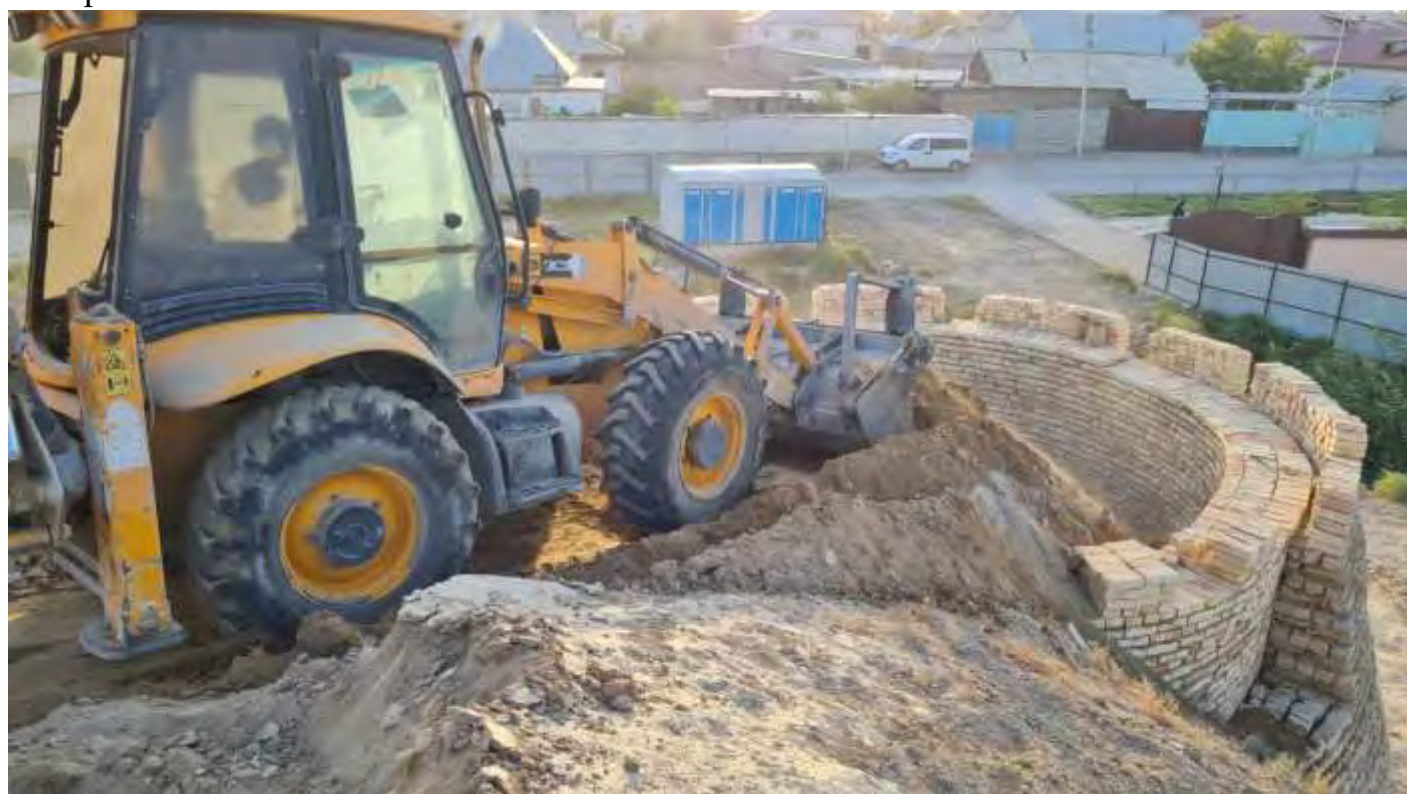
Обратная засыпка башни крепостной стены грунтом с послойным трамбованием
