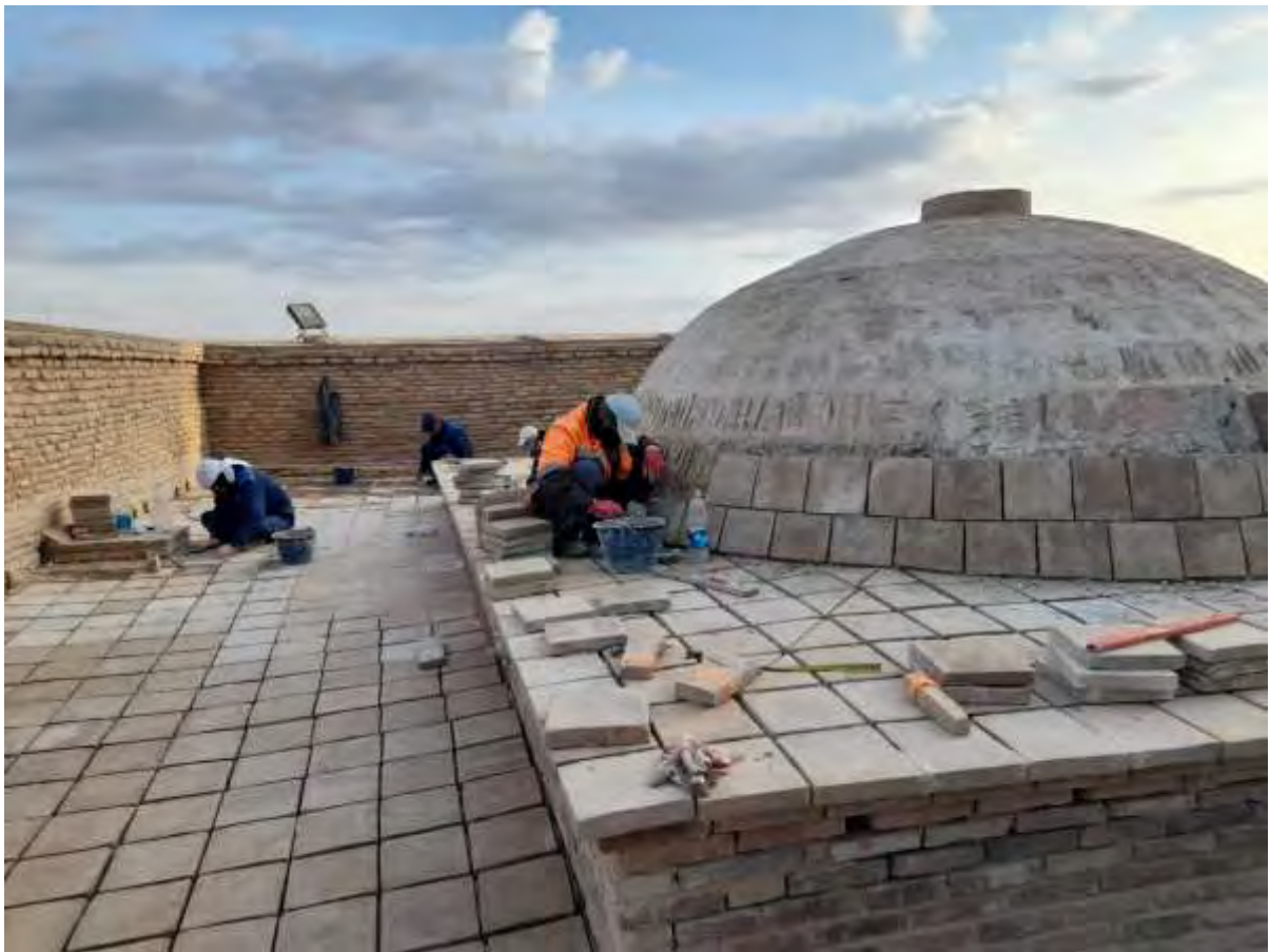
Устройство покрытия купола
