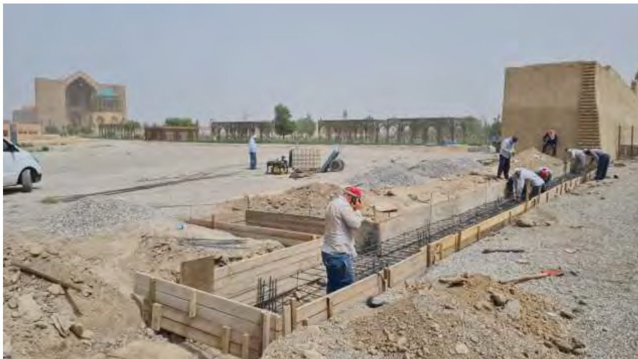
Сетки арматурные плоские. Изготовление в построчных условиях из арматуры
