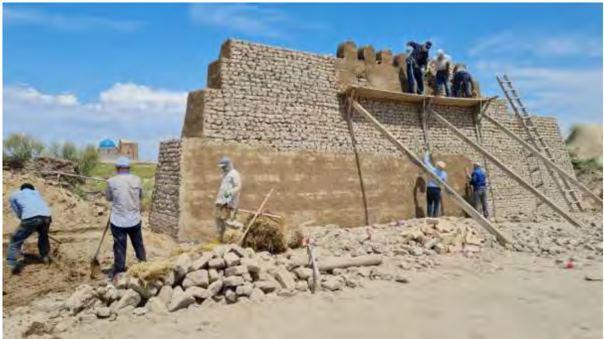
2-й слой штукатурка глиняным раствором с добавлением рисовой шелухи
