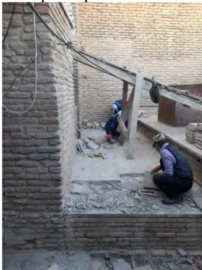
Реставрация покрытия плоской кровли над Ильясхановской нишей. Демонтаж покрытия кровли Ильясхановской Ниши
