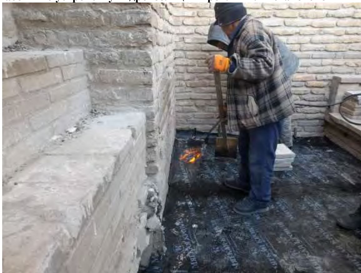
Работы по устройству гидроизоляции кровли Ильясхановской Ниши
