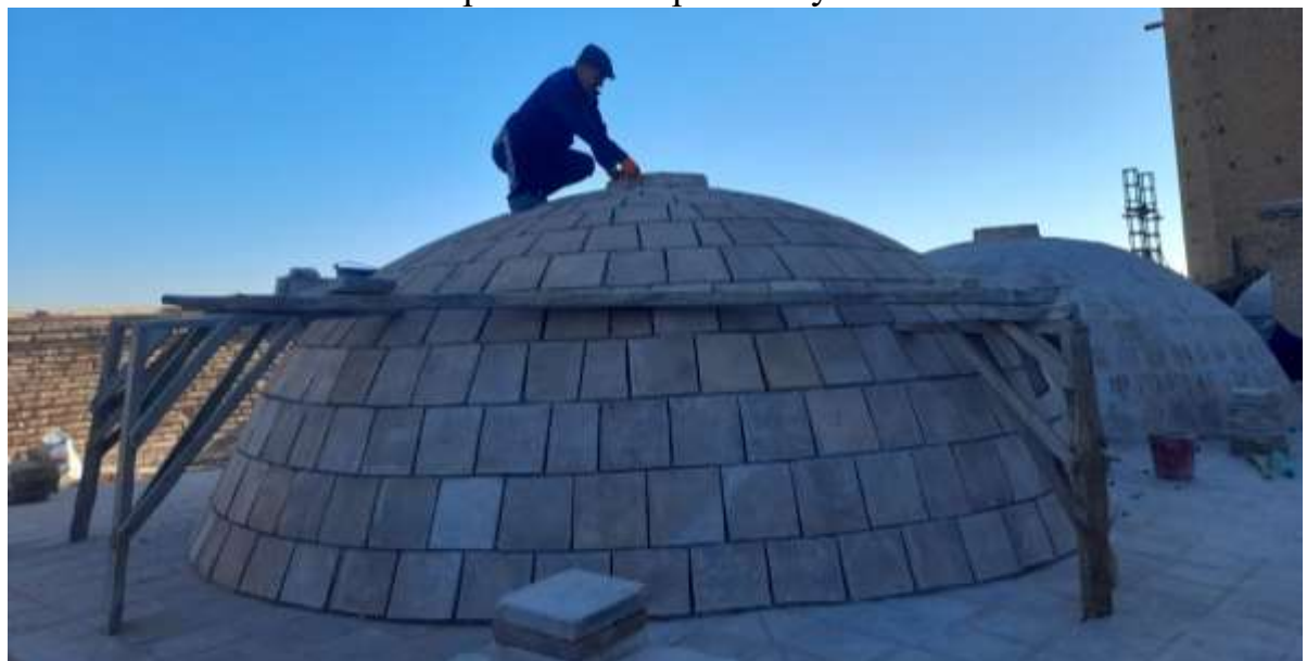
Устройство покрытия купола
