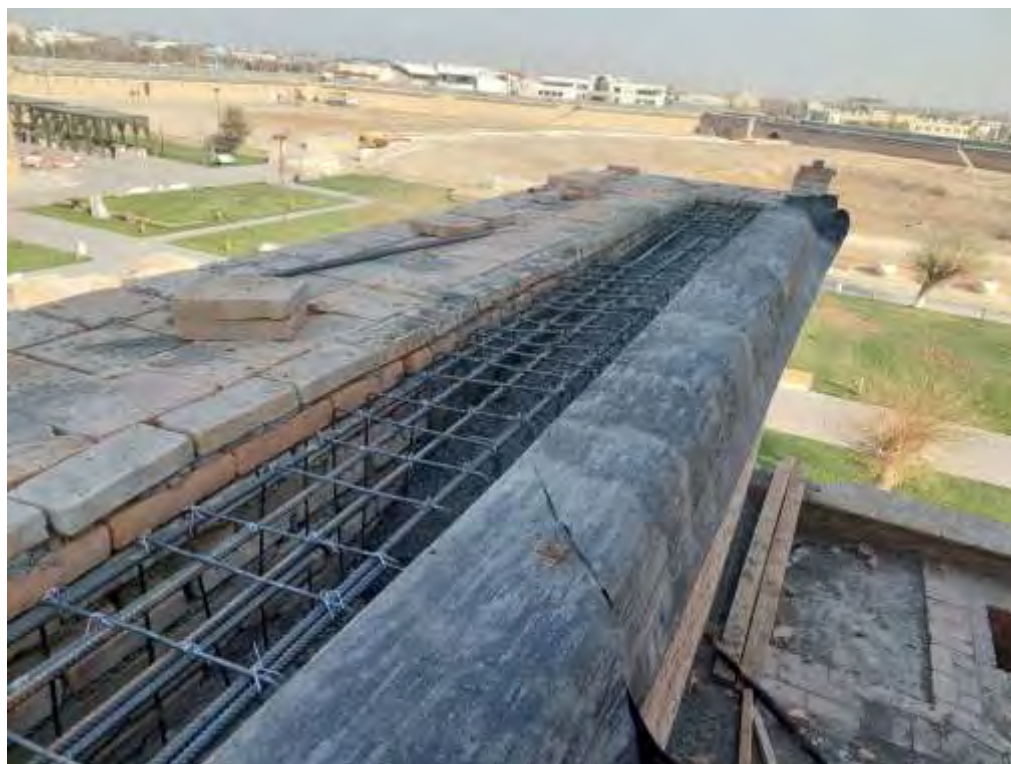
Устройство ригеля Рм-1
