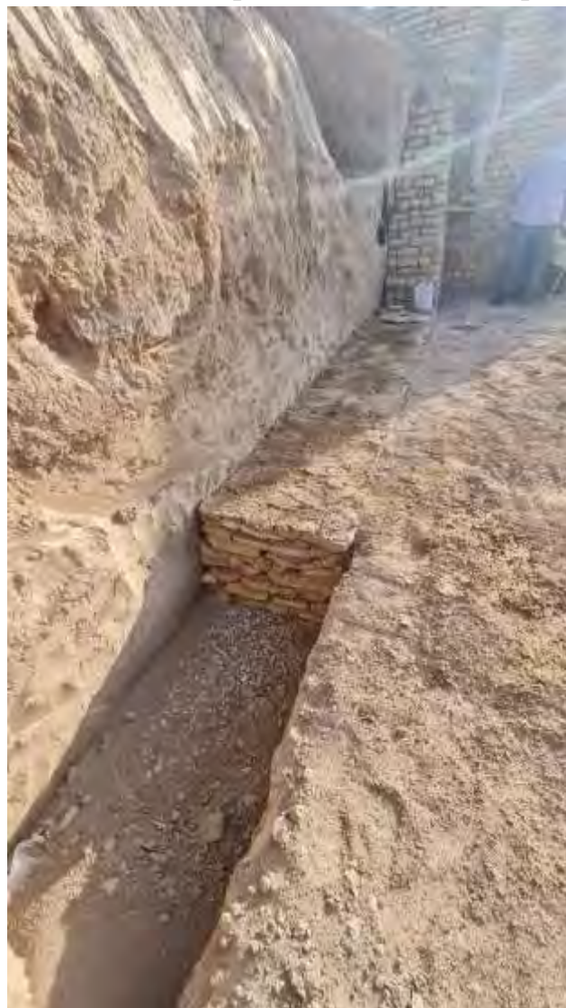
Кладка стен башни крепостной стены сырцовым кирпичом
