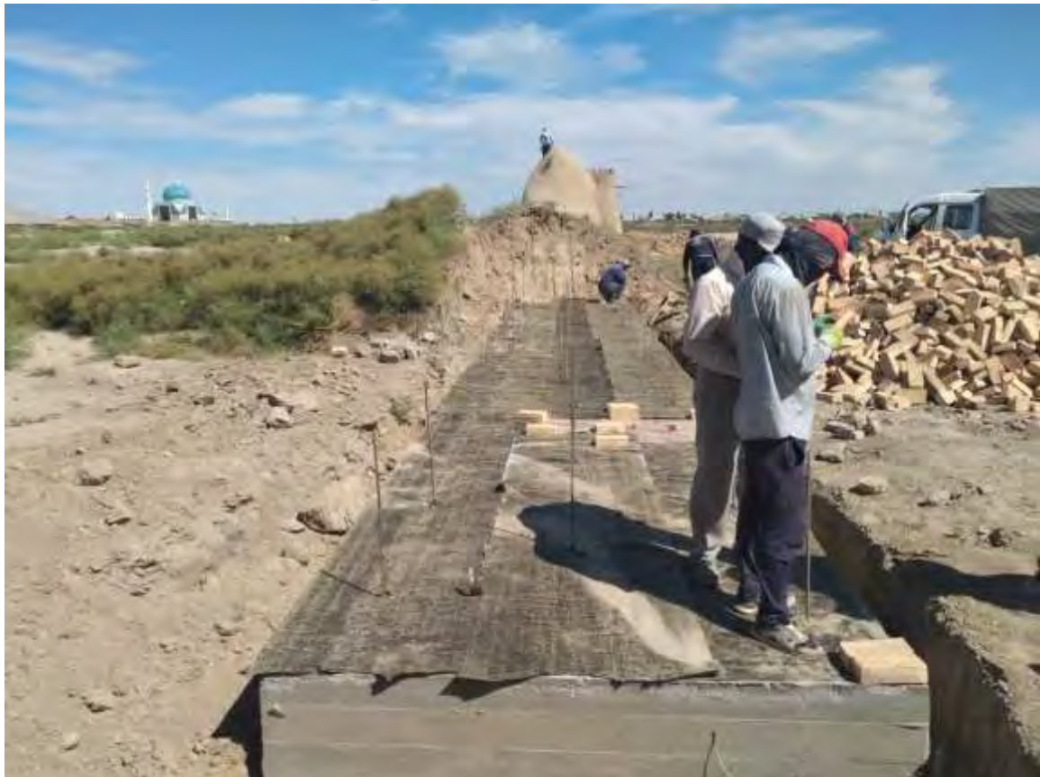
Гидроизоляция оклеечная в 1 слой
