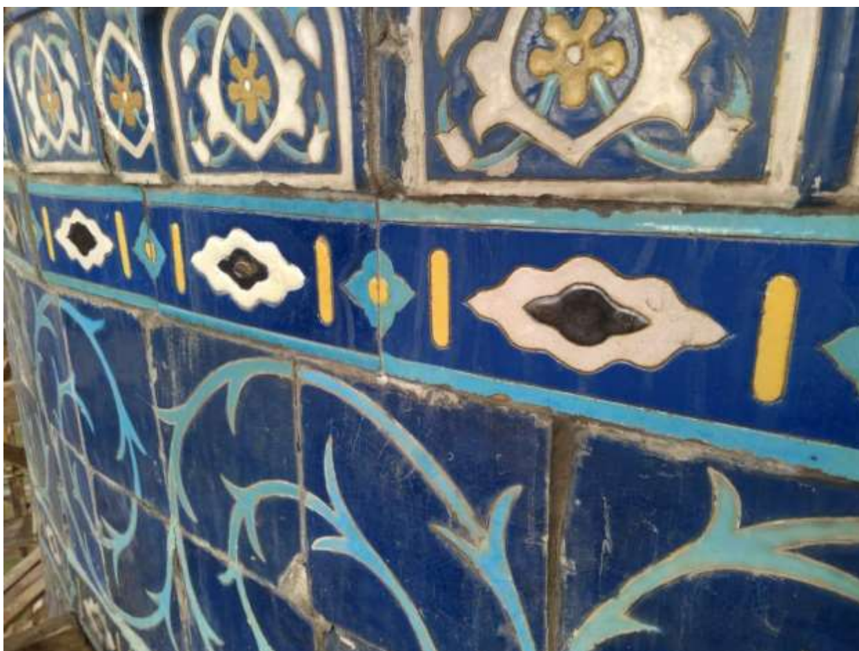
После научно-реставрационных работ
