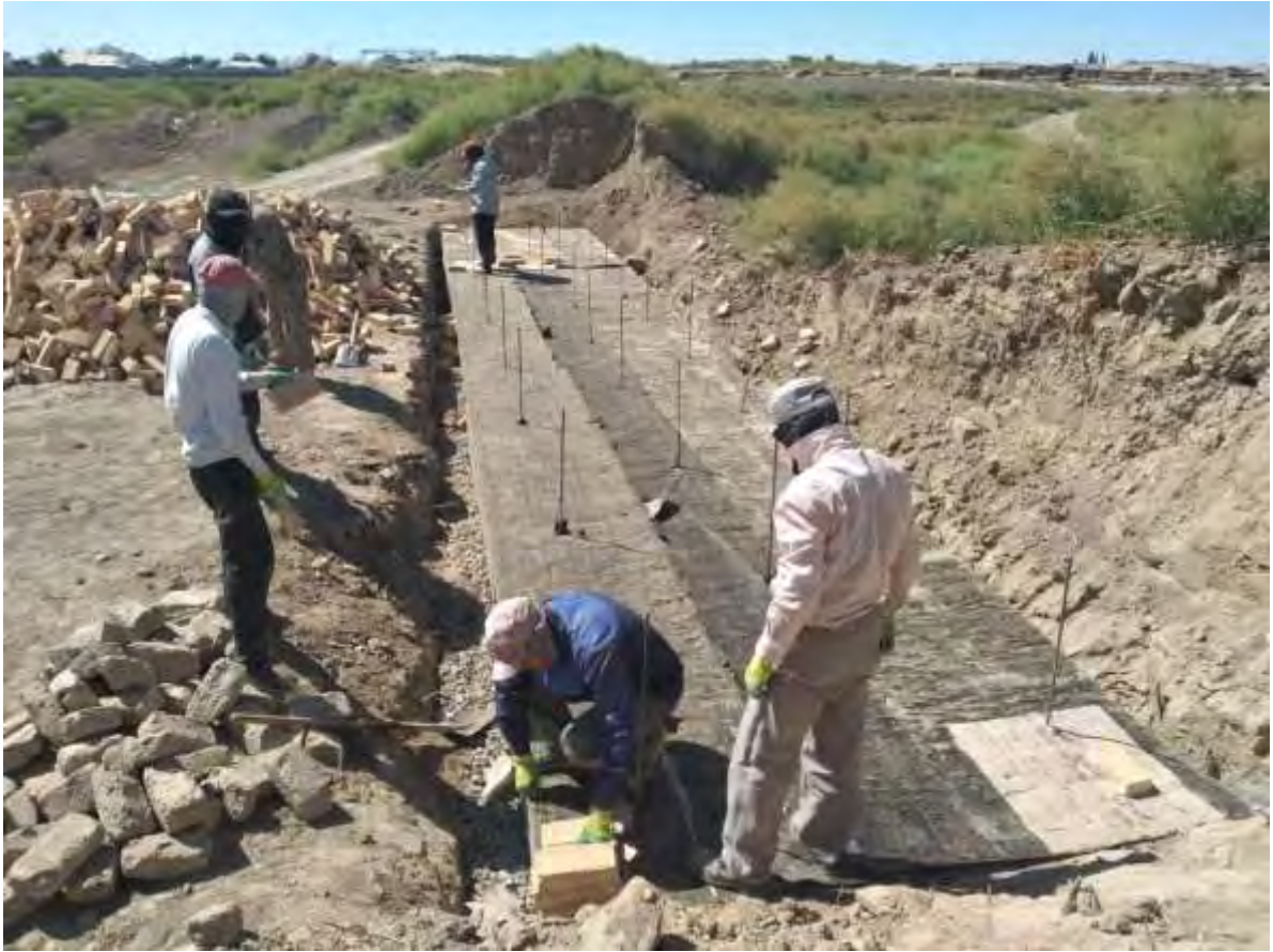
Обмазка бетонных поверхностей битумом
