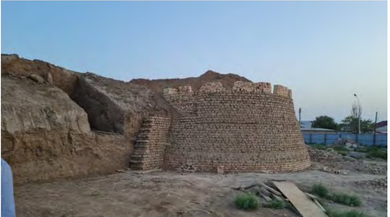
Кладка стен башни крепостной стены сырцовым кирпичом
