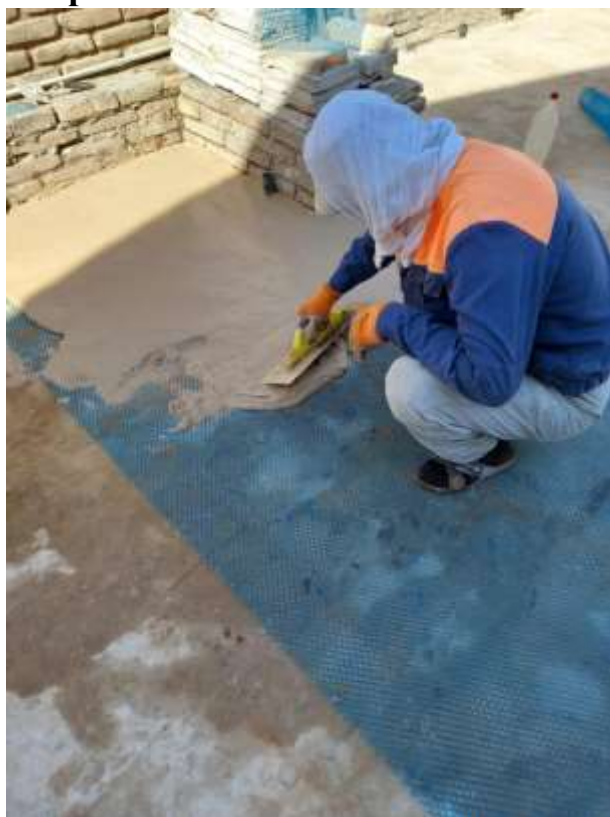
Реставрация покрытия плоской кровли над Северным порталом. Устройство стяжки по сетке Китапханы, Мечети, Коридор 3, Коридор 4
