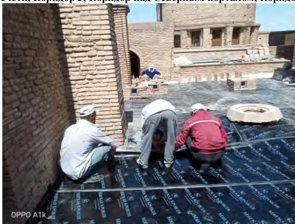
Устройство гидроизоляции в три слоя рубероида на кровле Китапханы, Мечети, Коридор 3, Коридор над Северным порталом, Коридор 4
