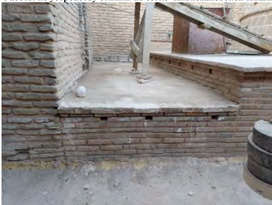
Работы по устройству стяжки по сетке Ильясхановской Ниши
