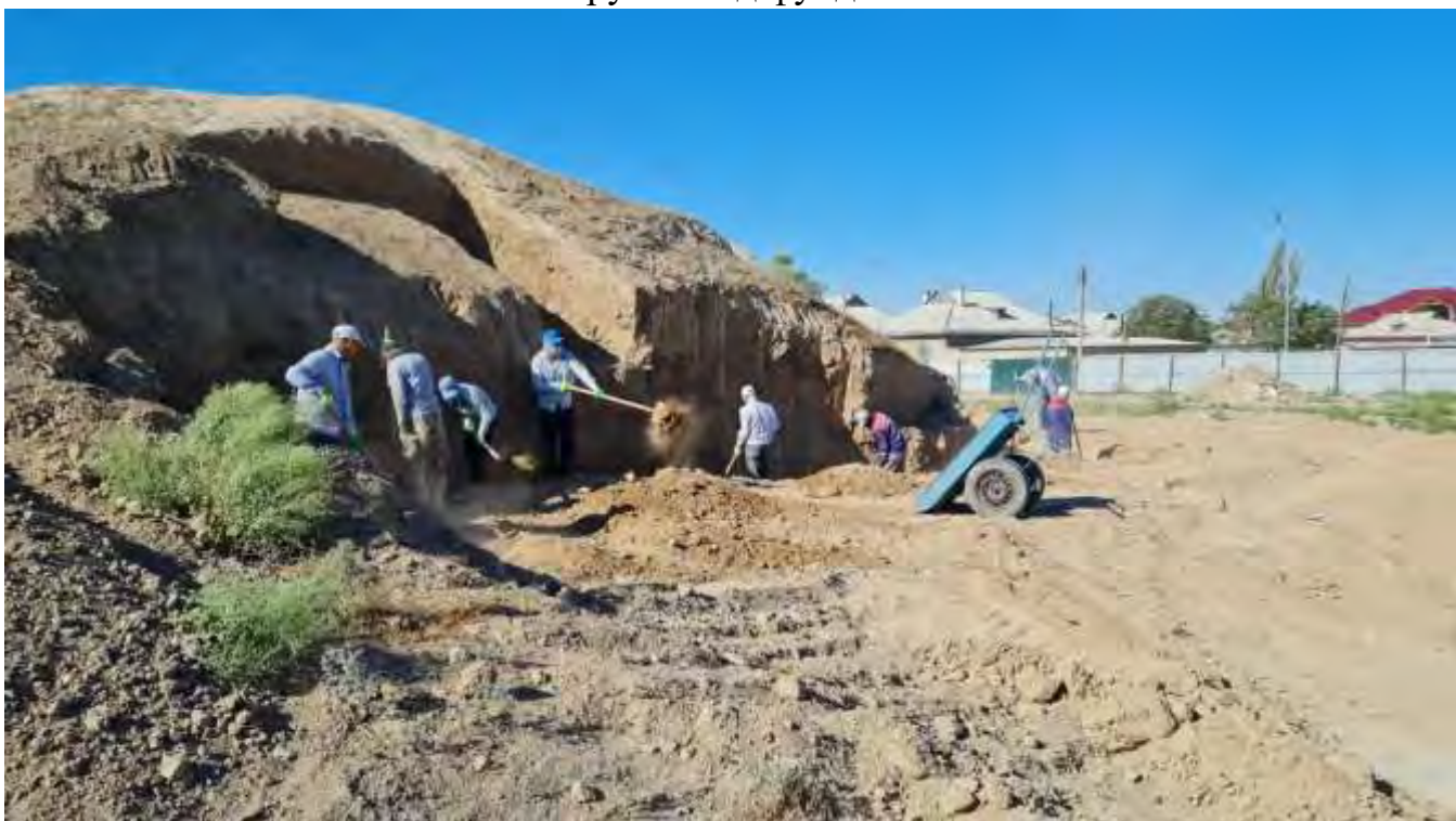
Выемка грунта под фундамент башни
