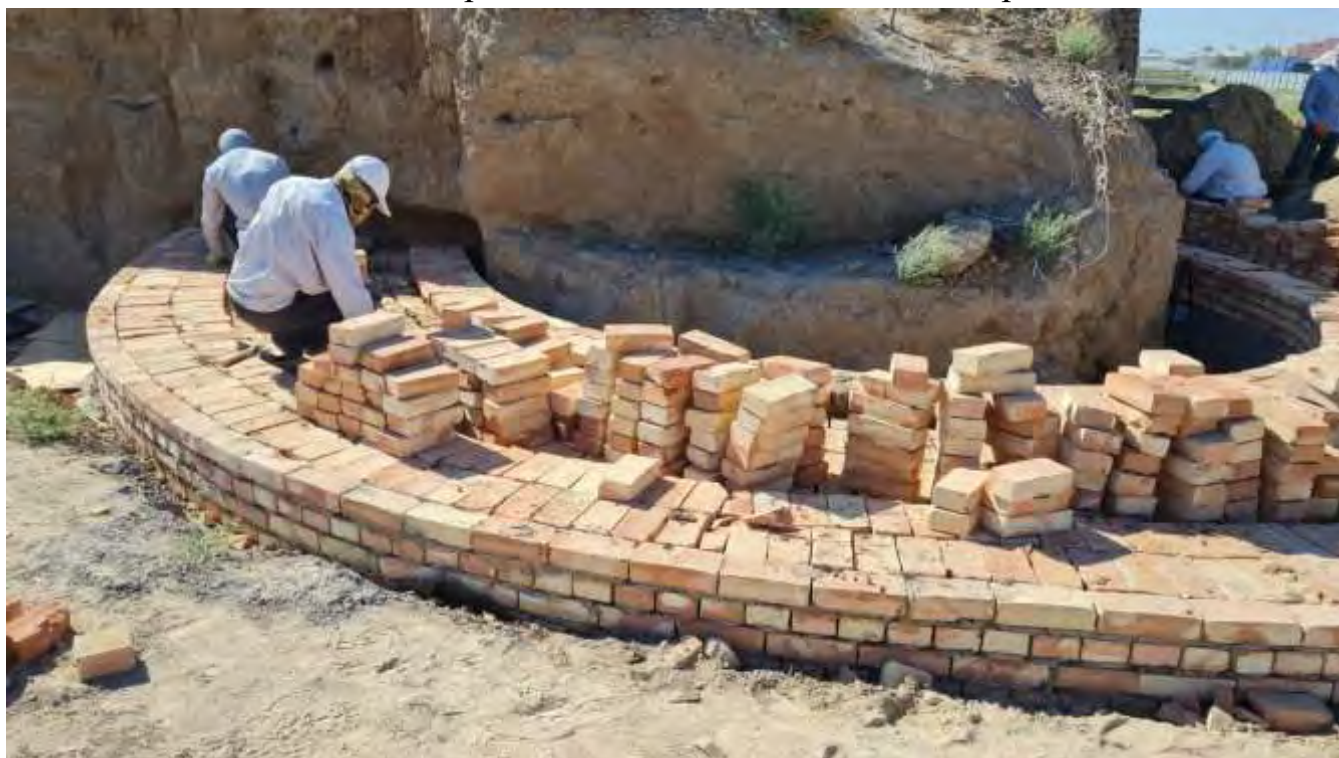
Кладка стен башни крепостной стены обожженным кирпичом
