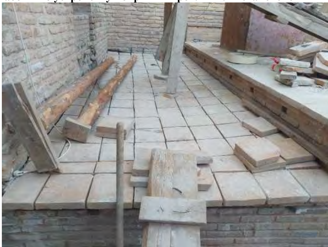
Работы по устройству покрытия кровли Ильясхановской Ниши
