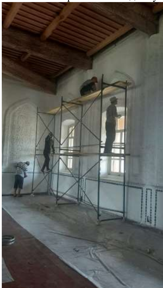
Реставрационные работы внутри здания Окраска стен водоэмульсией стен помещения мечети
