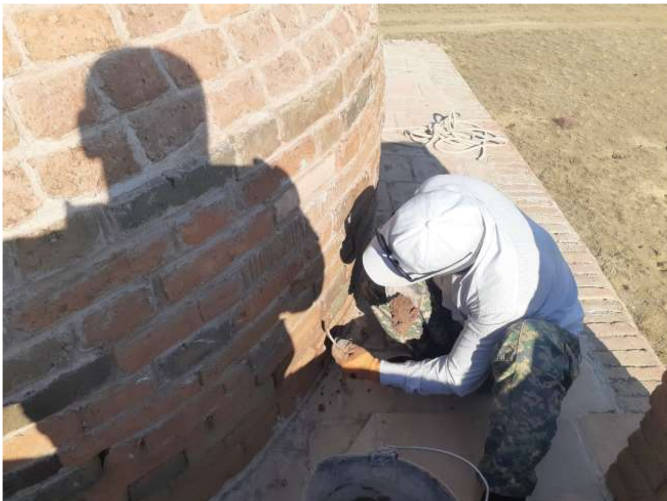
Устройство гидроизоляции кровли из специального глиняного раствора;
