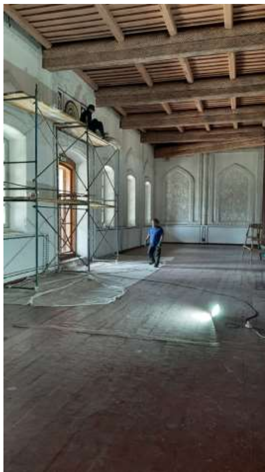
Реставрационные работы внутри здания Окраска стен водоэмульсией стен помещения мечети
