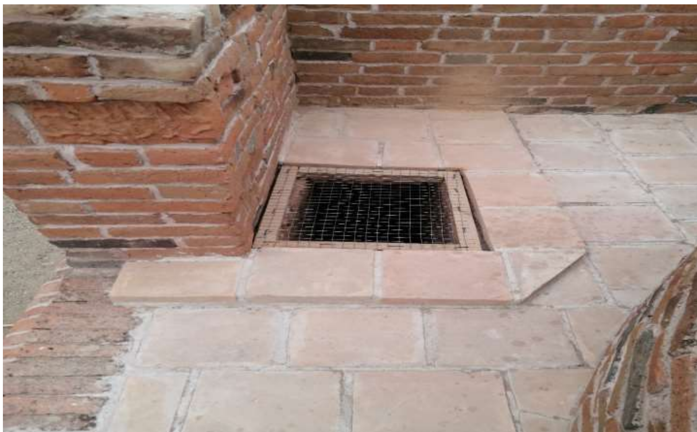
Зачеканка швов кладки специальным глиняным раствором;
