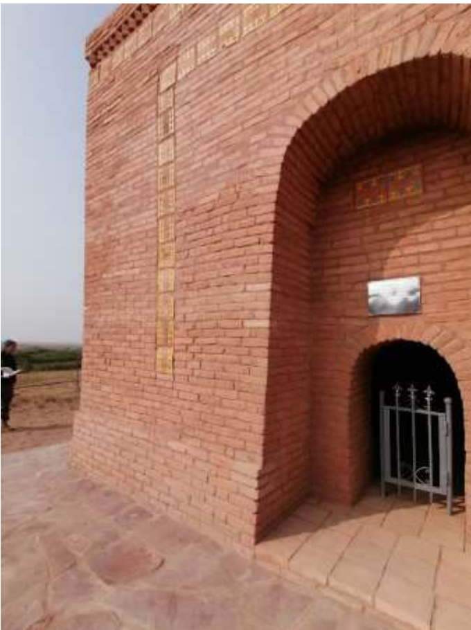
Установка металлической решетчатой двери в проеме входа.
