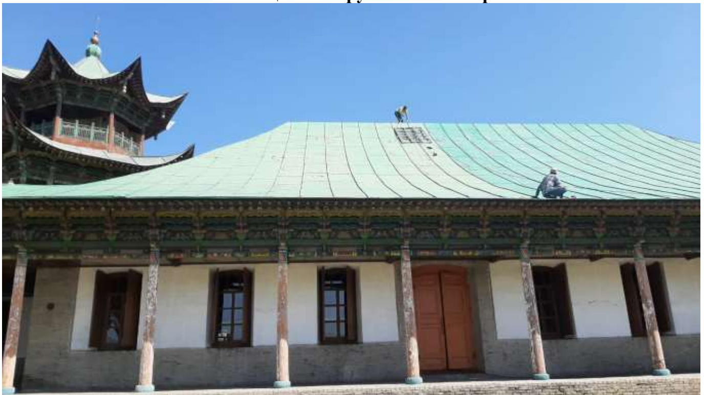
Расчистка и окраска, кровли головной мечети, с предварительной шпатлевкой щелей и грунтовкой поверхности
