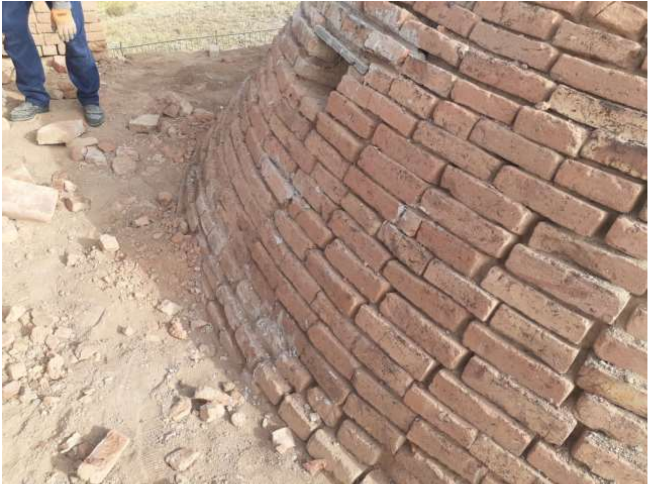
Ремонт пола в местах разрушения раствора глины между кирпичами
