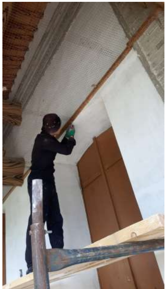
Реставрация деревянных колонн
