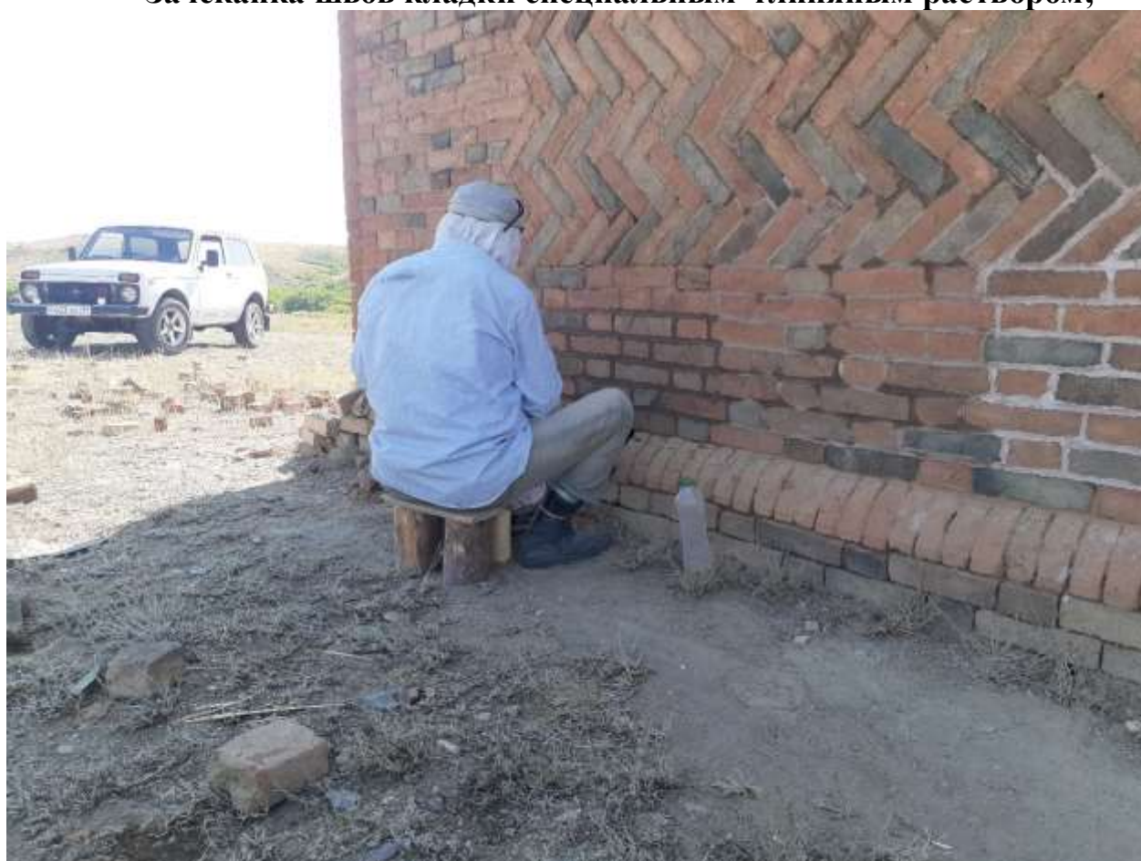
Зачеканка швов кладки специальным глиняным раствором;
