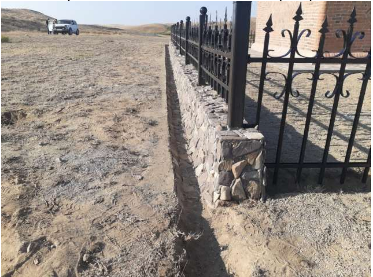
Устройство отмостки из специального глиняного раствора
