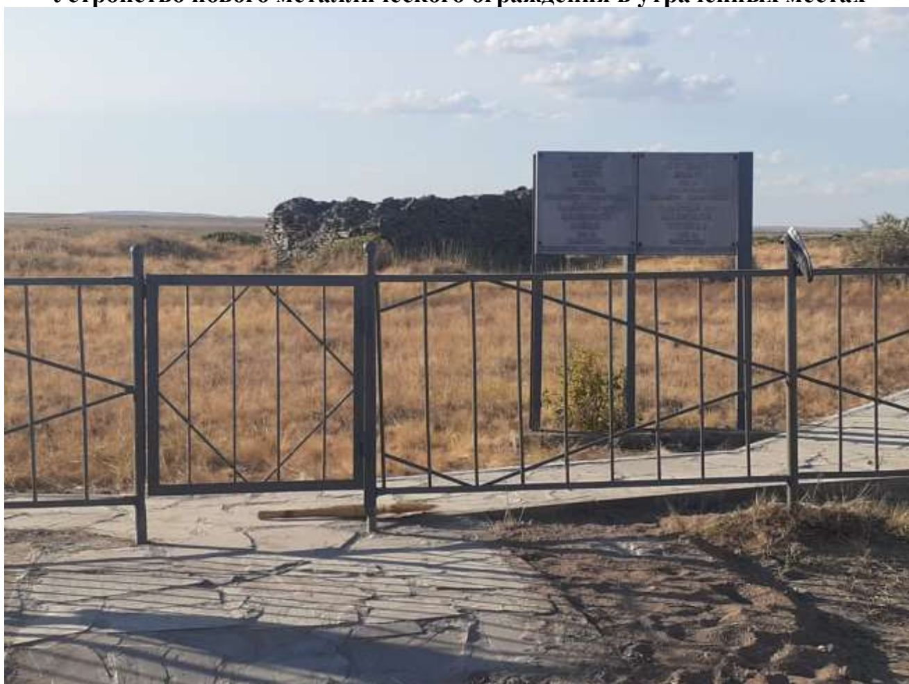
Устройство нового металлического ограждения в утраченных местах
