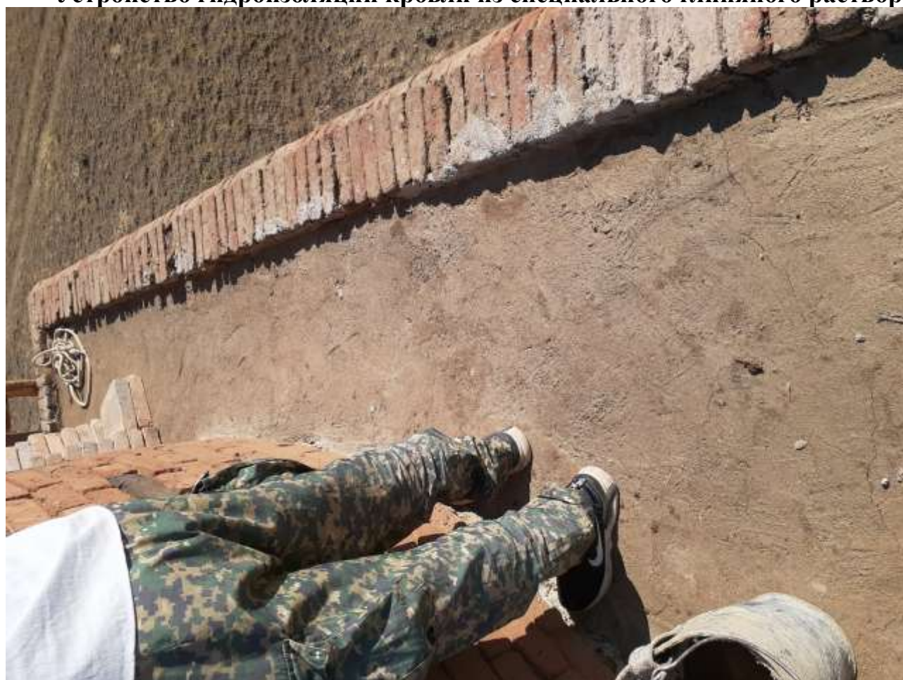
Устройство гидроизоляции кровли из специального глиняного раствора;
