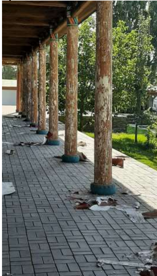
Реставрация деревянных колонн
