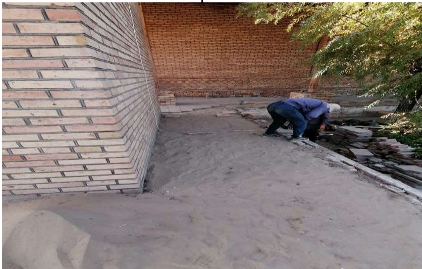
Устройство отмостки
