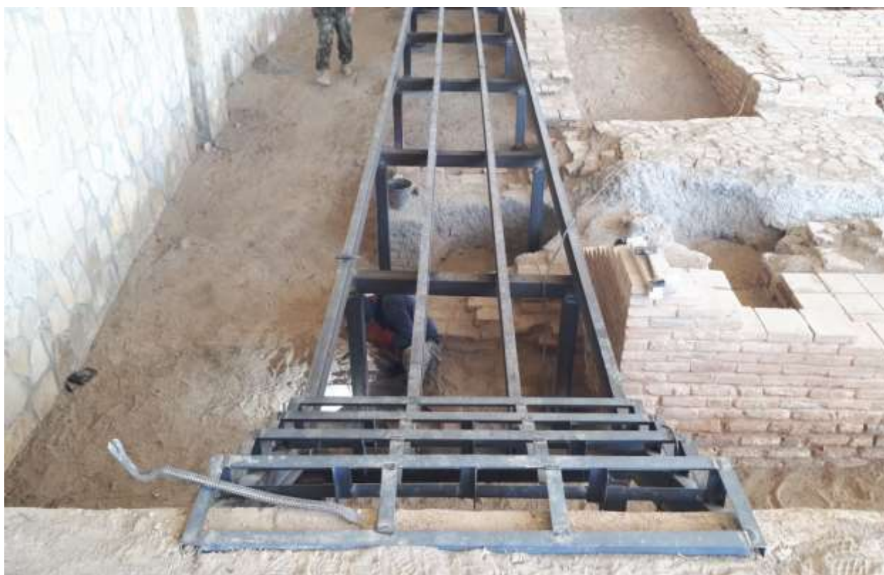
Изготовление решетчатых конструкций в построчных условиях и на производственных базах смотровой дорожки №2
