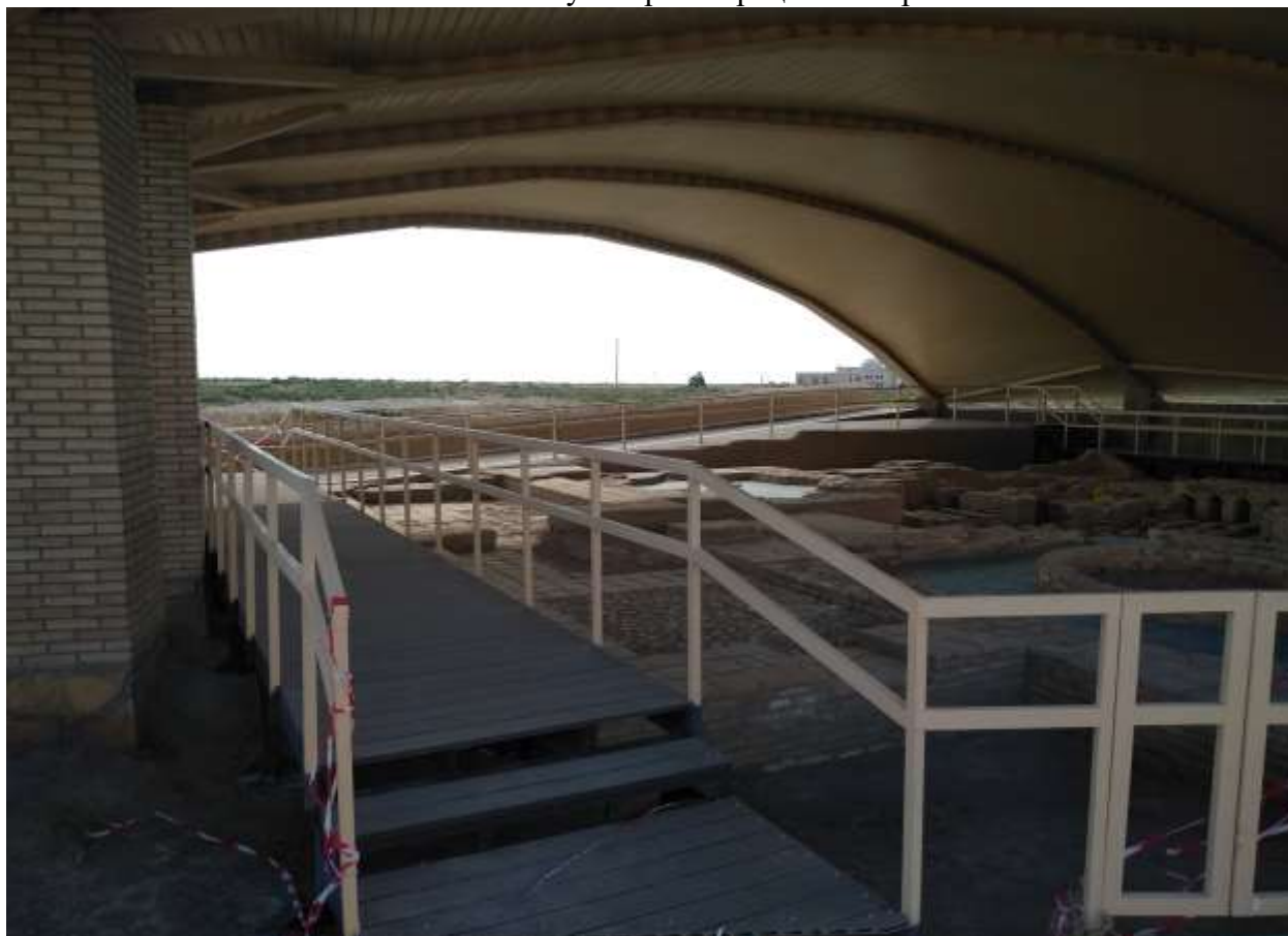
После научно-реставрационных работ
