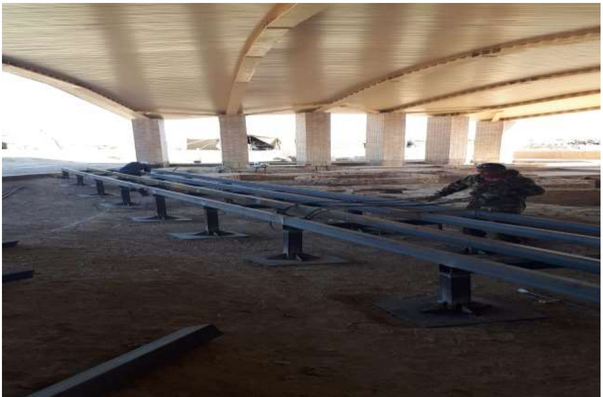
Изготовление решетчатых конструкций в построечных условиях и на производственных базах с широкой стороны
