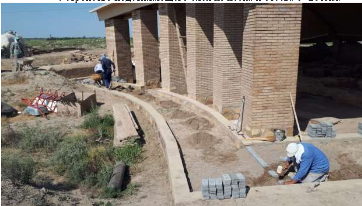
Дорожки и площадки из брусчатки. Устройство с подготовкой
