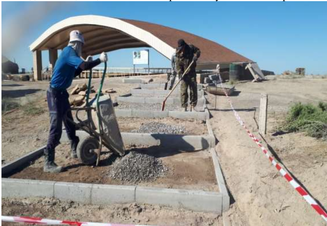
Слои подстилающие щебеночные. Устройство с уплотнением трамбовками
