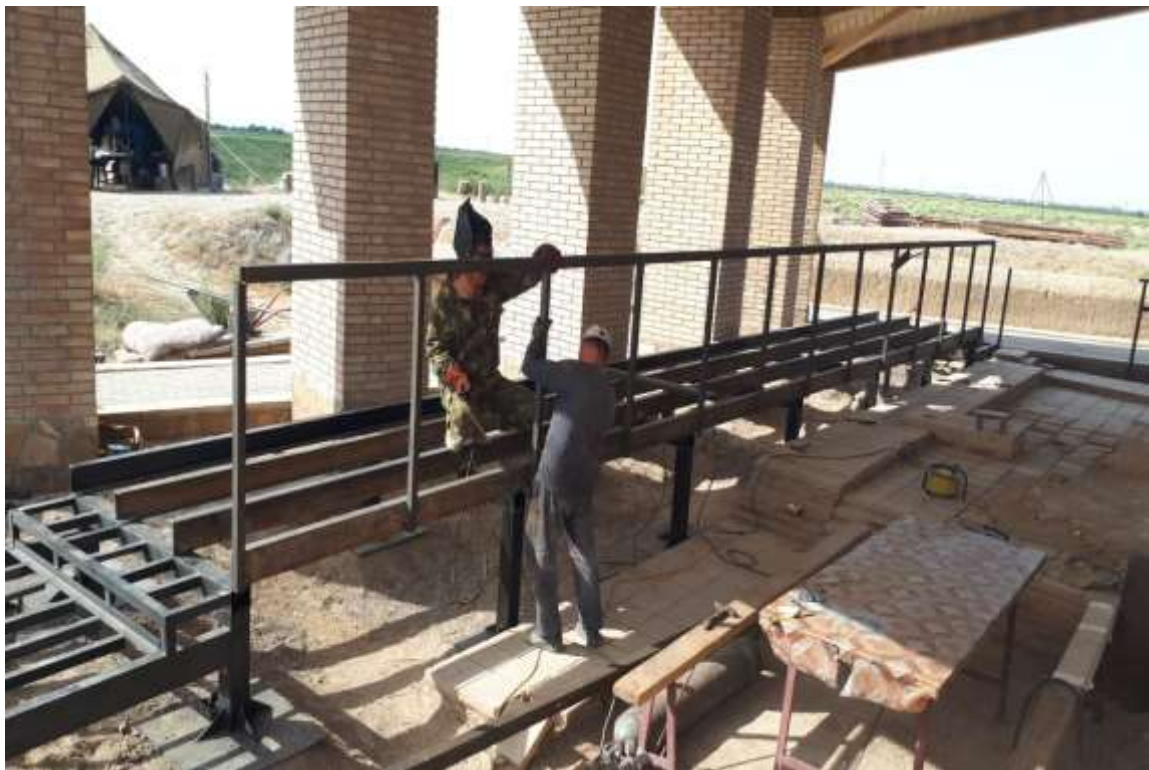
Монтаж металлической лестницы Л-1
