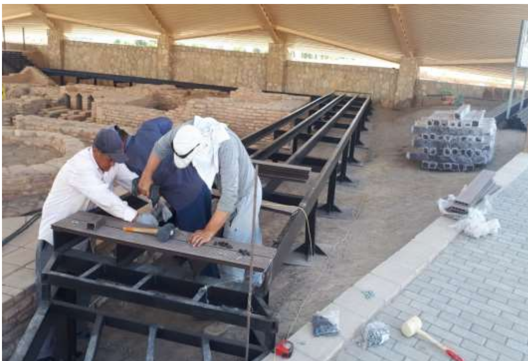
Изготовление решетчатых конструкций в построчных условиях и на производственных базах смотровой дорожки №2
