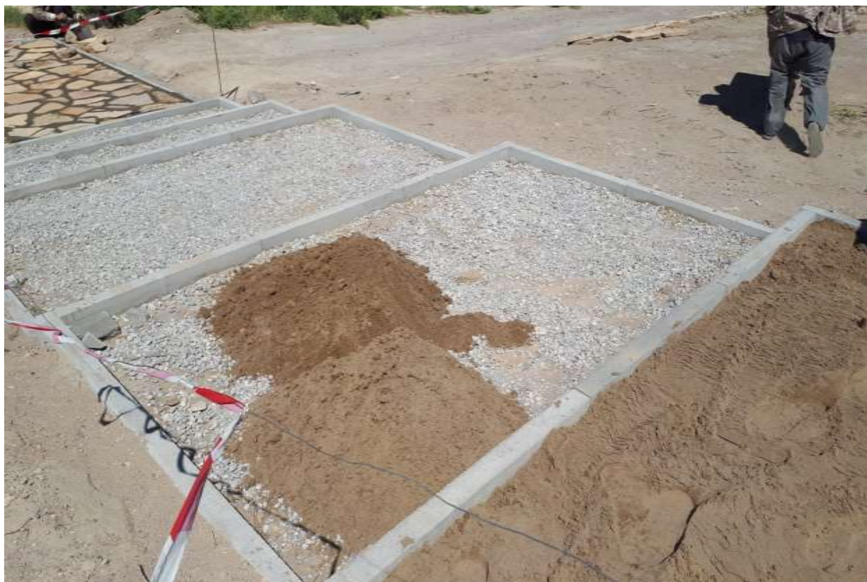
Слои оснований подстилающие и выравнивающие из песка. Устройство
