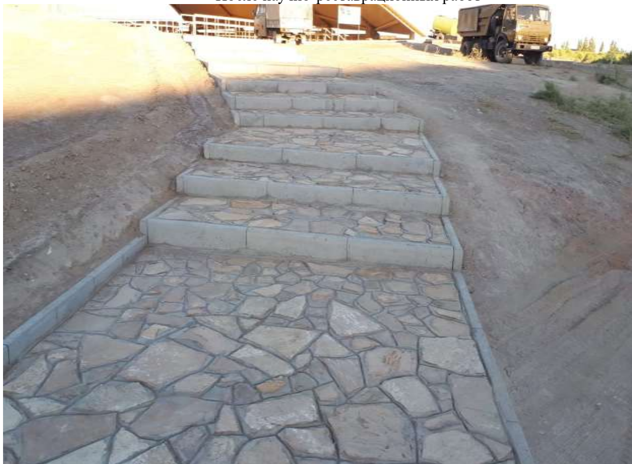
После научно-реставрационных работ
