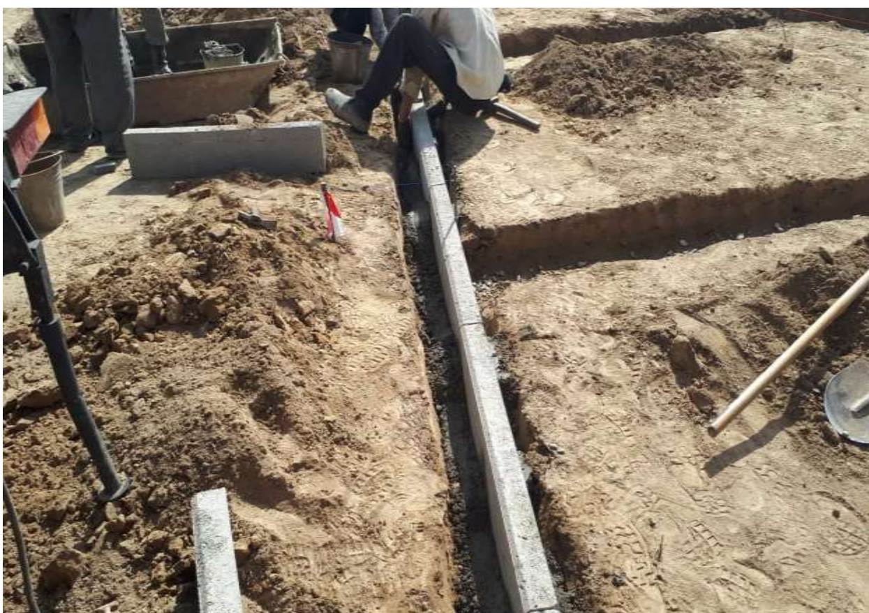
Камни бортовые бетонные. Установка при других видах покрытий
