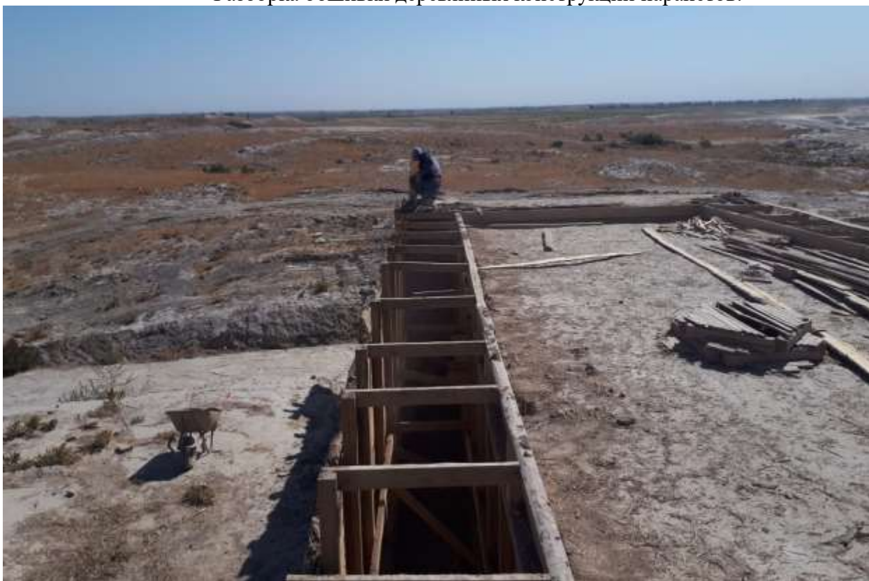
Разборка обшивки деревянных конструкции парапетов.
