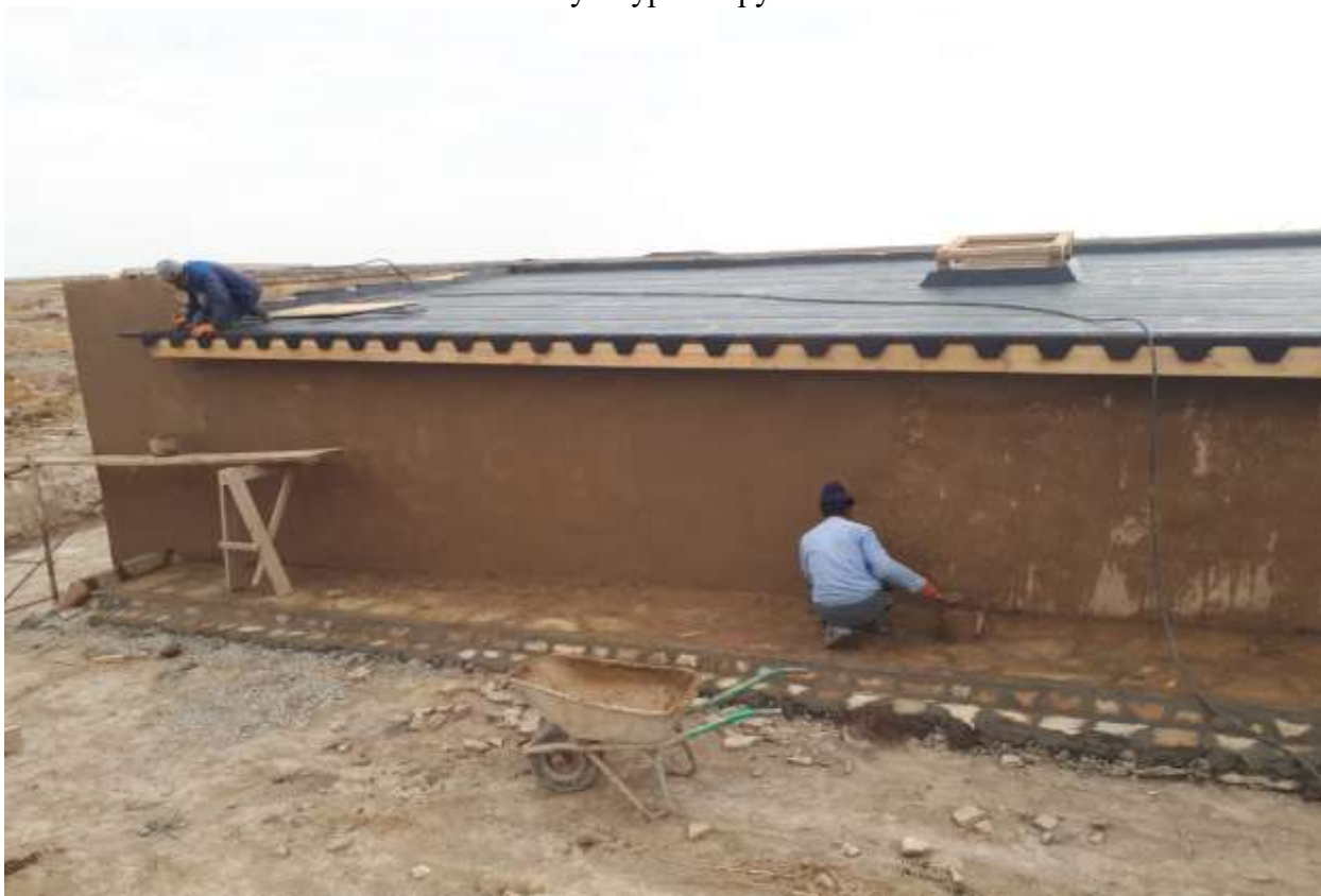
Штукатурка наружных стен.
