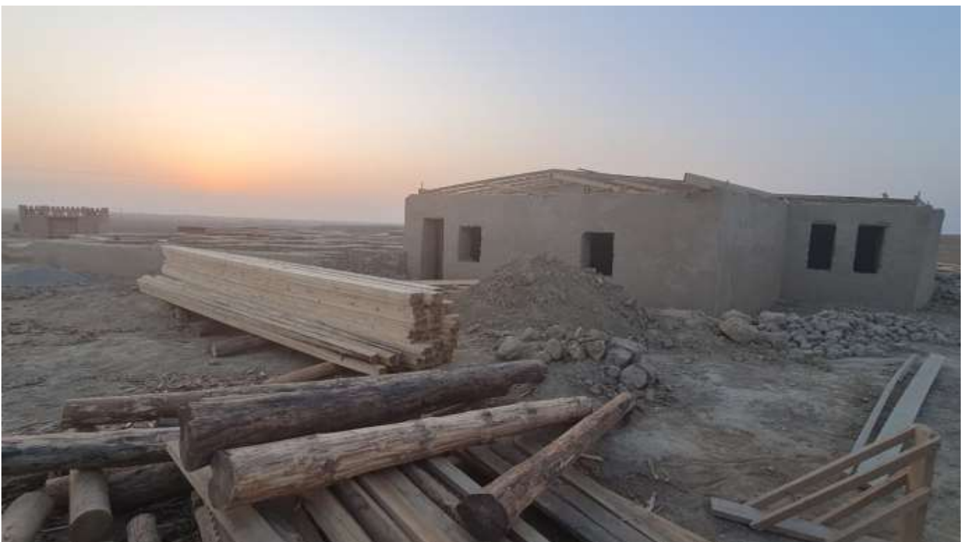
Устройство деревянных конструкции перекрытия
