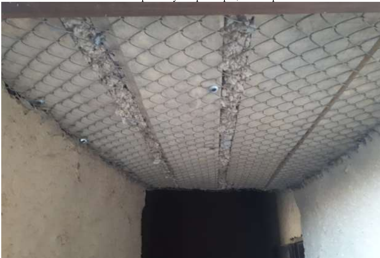
Обшивка сеткой перемычек дверных проемов.
