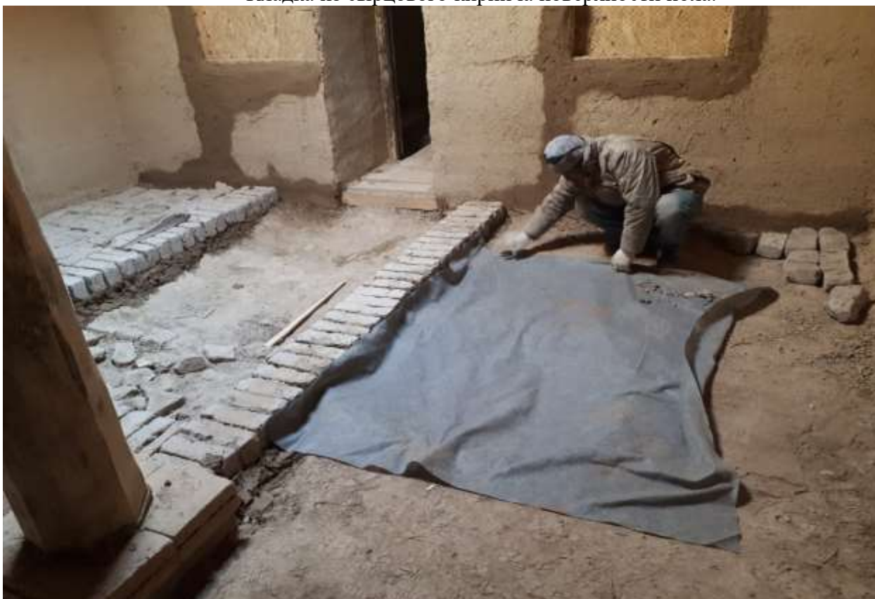
Укладка геотекстиля под кладку из кирпича.
