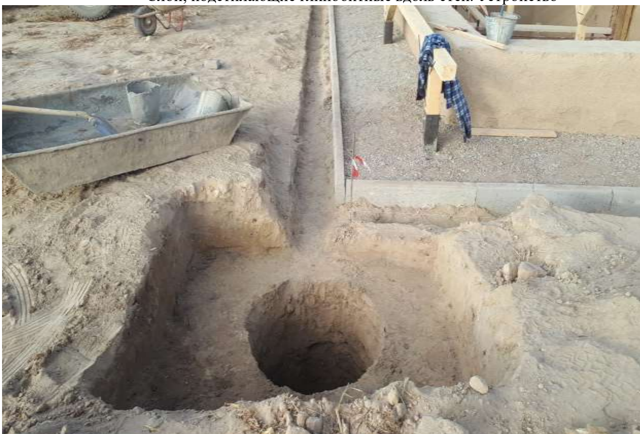
Устройство слоев, подстилающих щебеночных под отсыпки.
