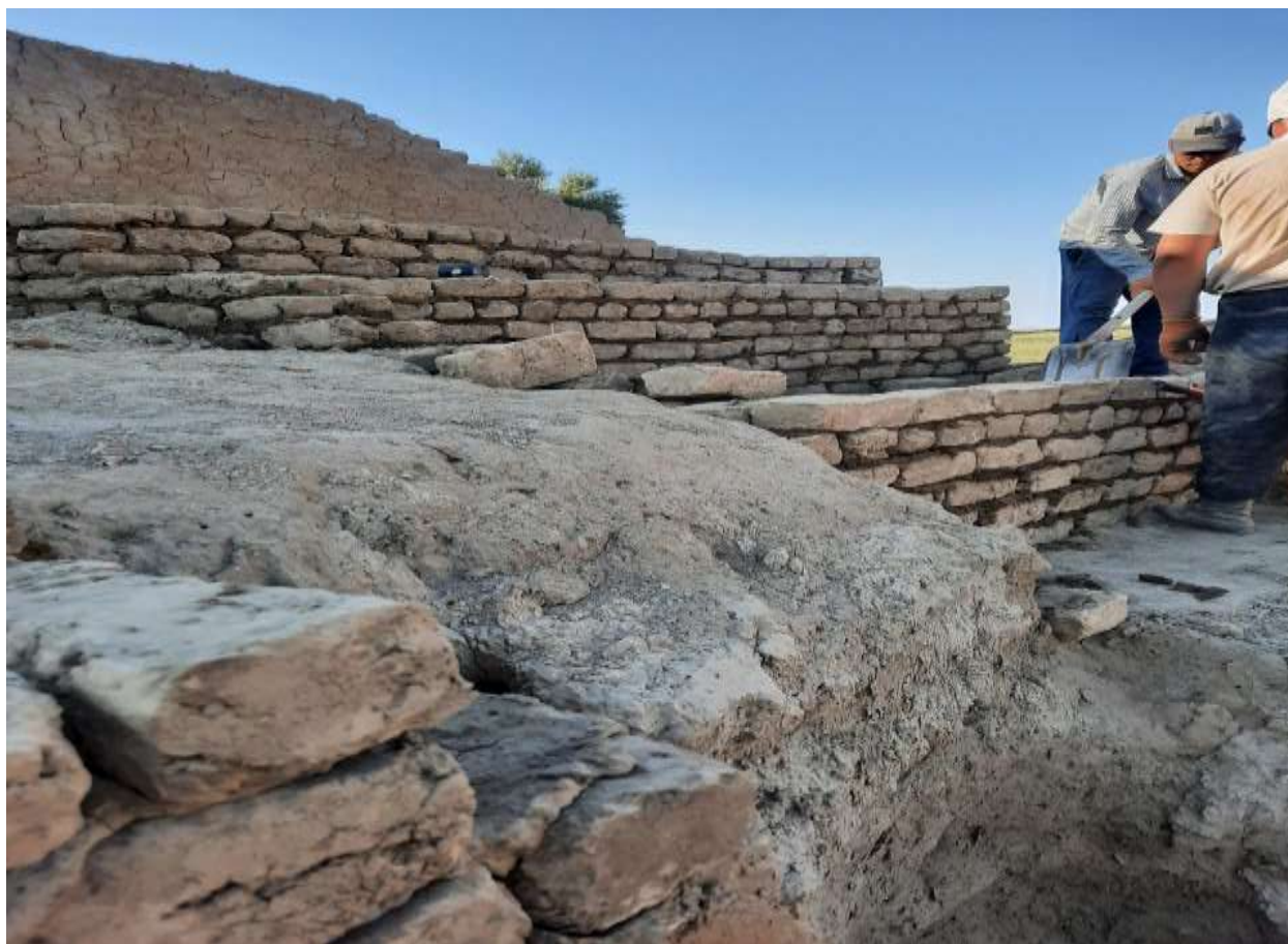
Кладка стены справа у входа
