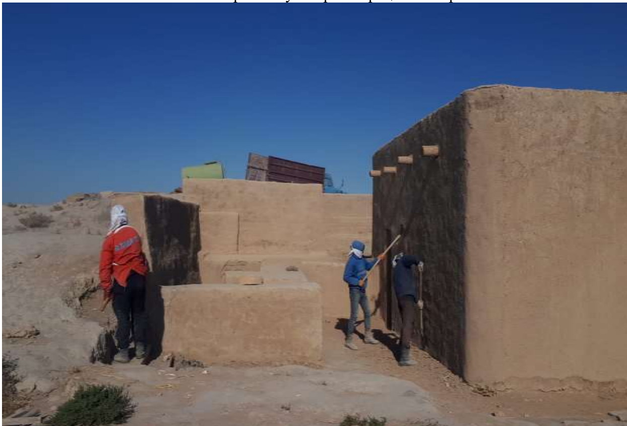
Снятие 2-го слоя штукатурки.
