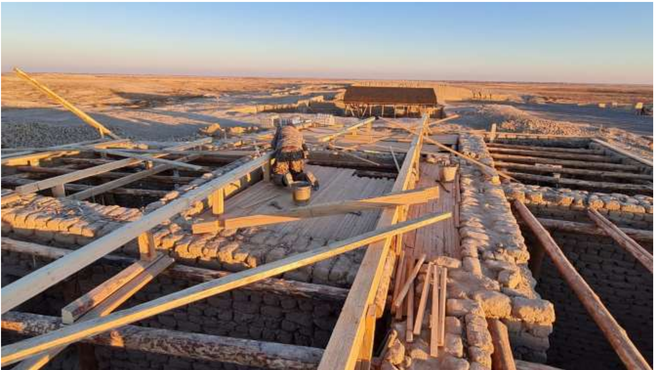
Устройство кровли жилого дома
