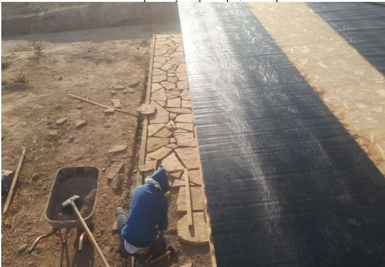
Устройство подкладочного слоя из рулонных наплавляемых материалов.
