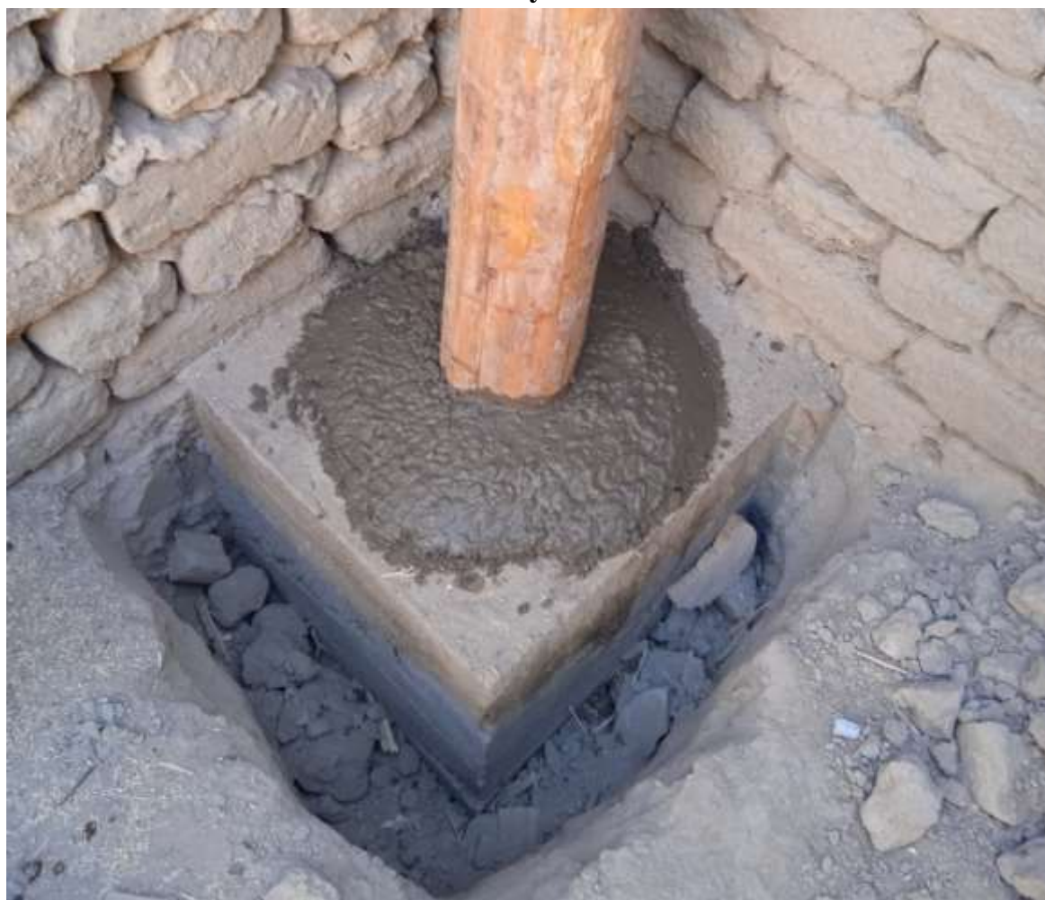
Изготовление и установка стоек
