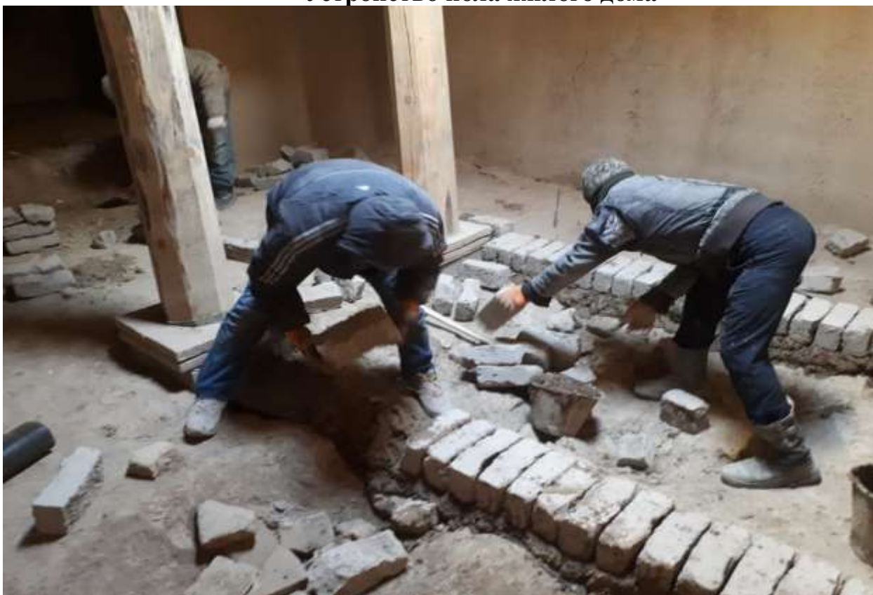
Кладка из сырцового кирпича поверхности пола.
