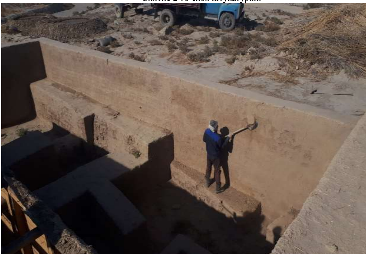
Снятие 2-го слоя штукатурки.
