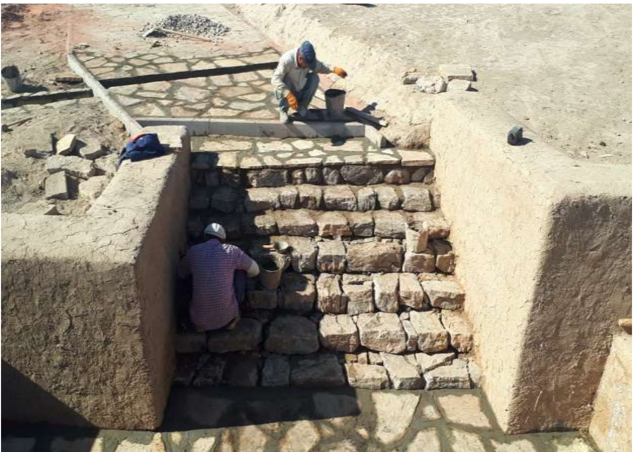
Воссоздание ступеней из бутового камня
