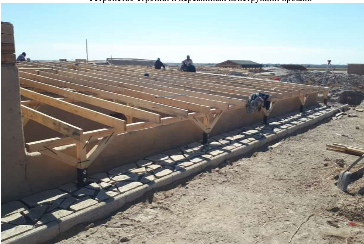
Устройство стропил и деревянных конструкций кровли.
