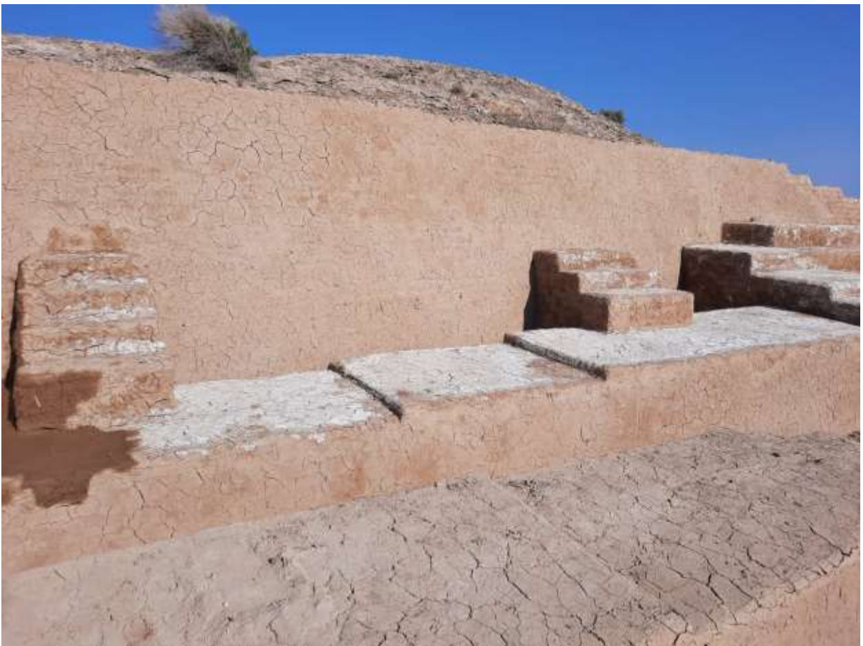
Воссоздание штукатурки подпорной стены
