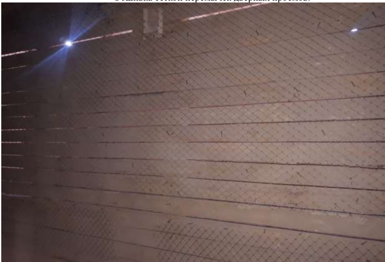
Обшивка сеткой внутренних стен.
