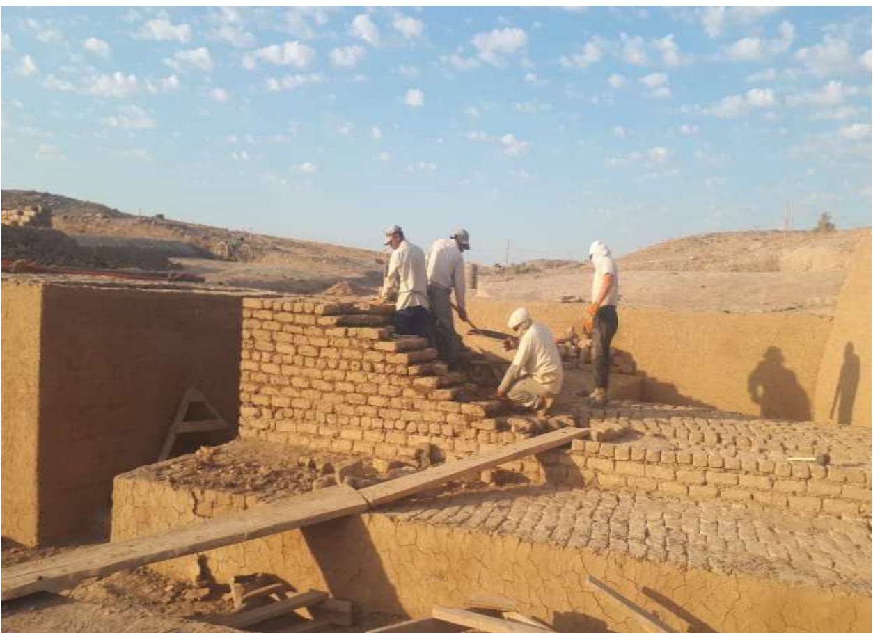
Кладка части крепостной стены
