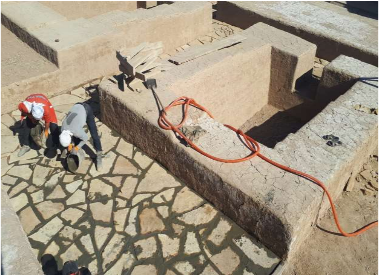
Воссоздание ступеней из бутового камня
