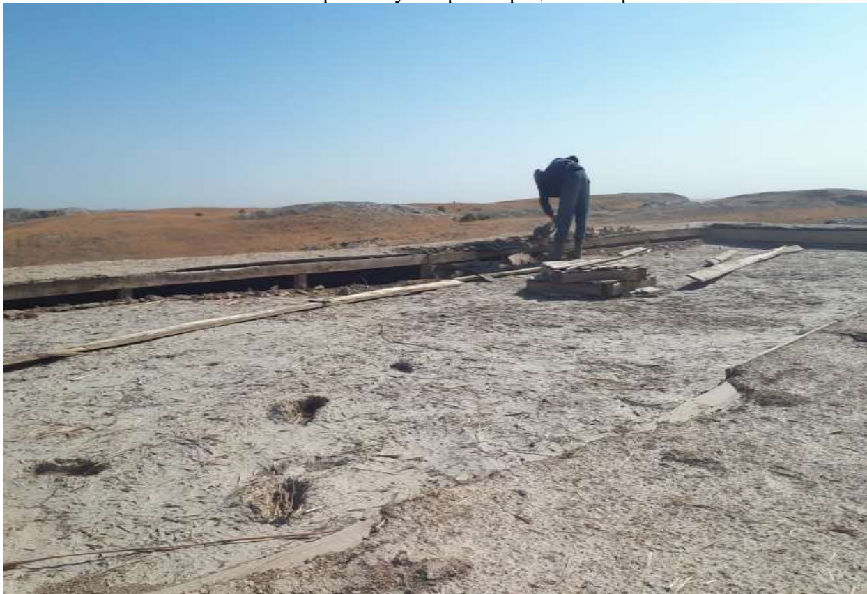
Разборка обшивки деревянных конструкции парапетов.
