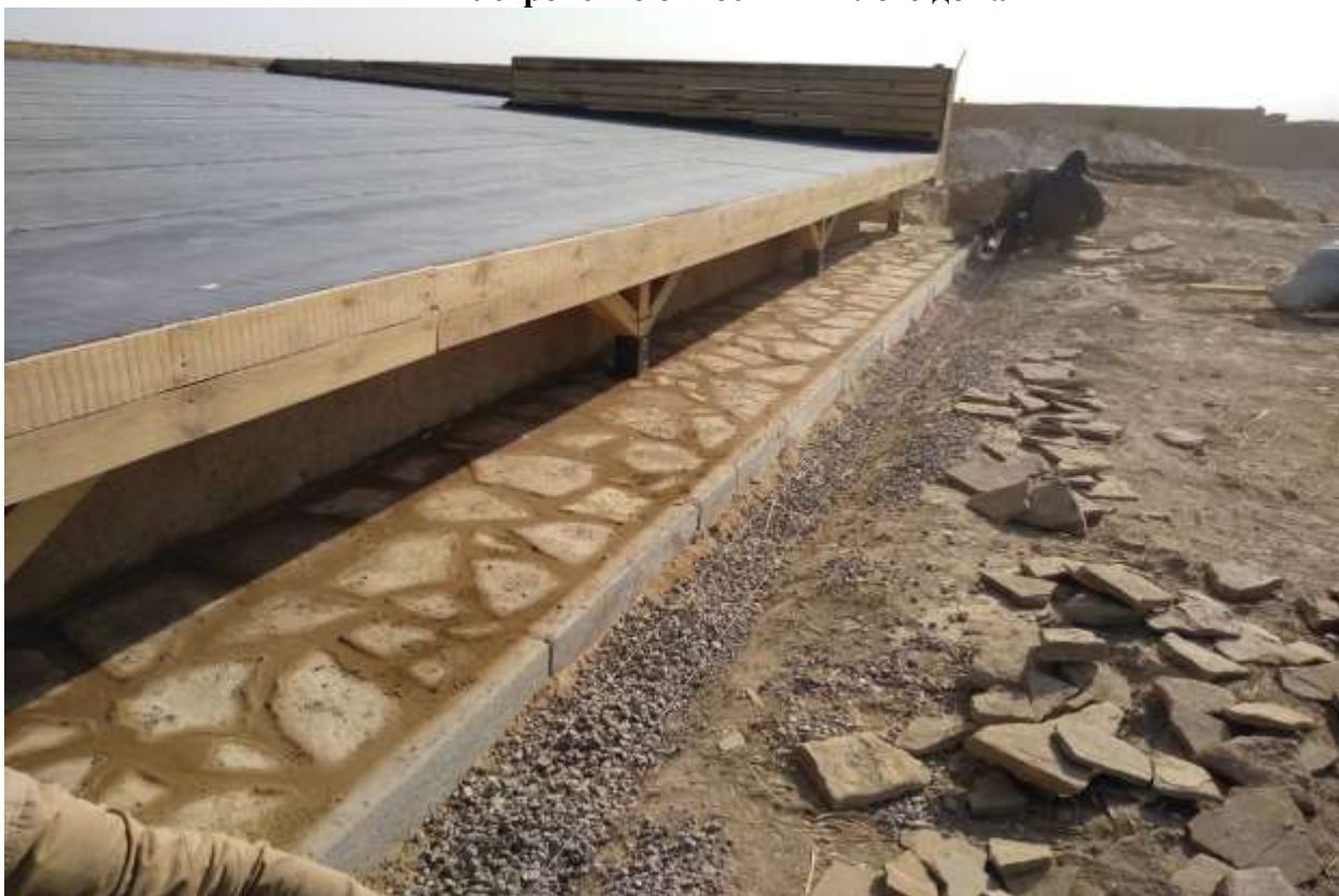
Устройство отмостки из камня-плитняка.
