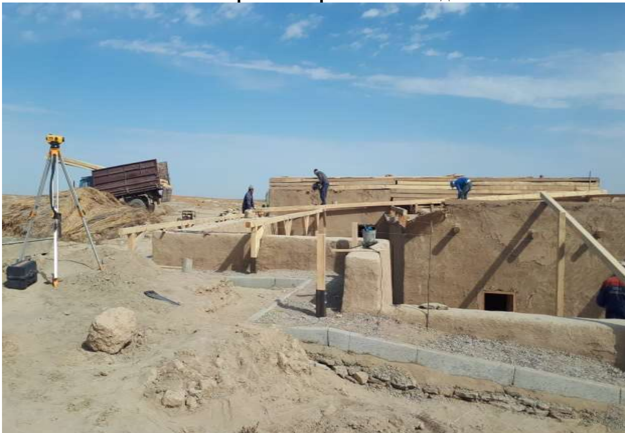
Устройство стропил и деревянных конструкций кровли.
