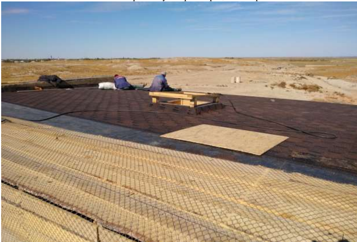
Устройство обшивки парапетов из сеток.
