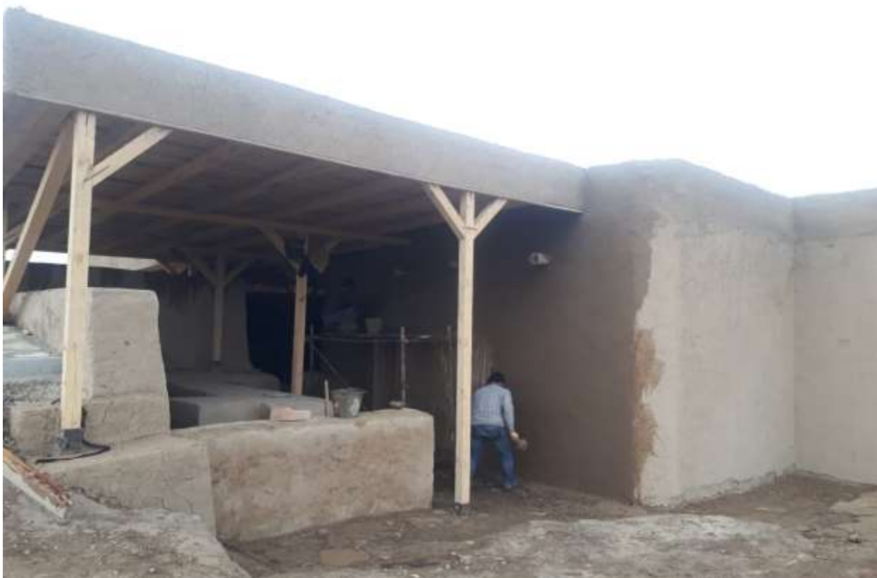
Штукатурка наружных стен.
