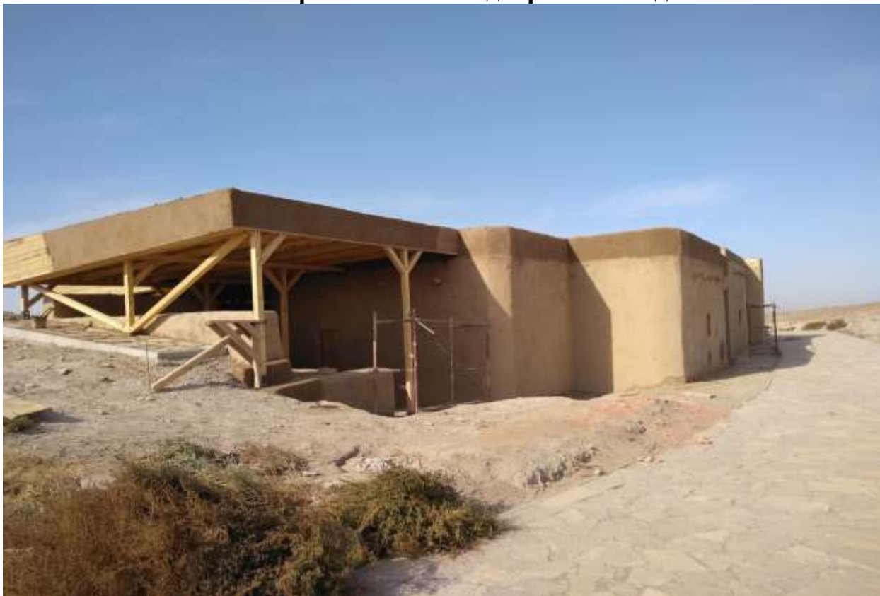
Штукатурка парапетов глиняным раствором.
