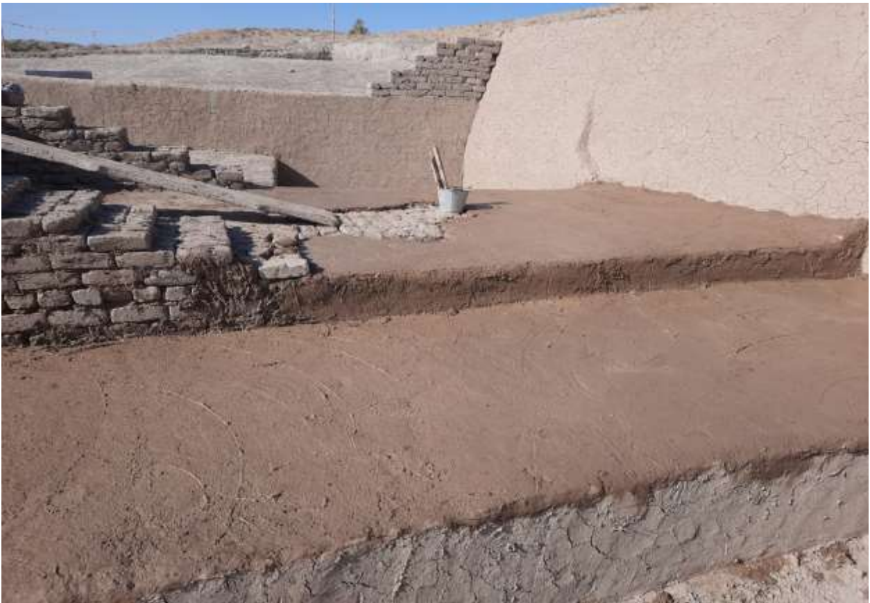
Воссоздание штукатурки подпорной стены
