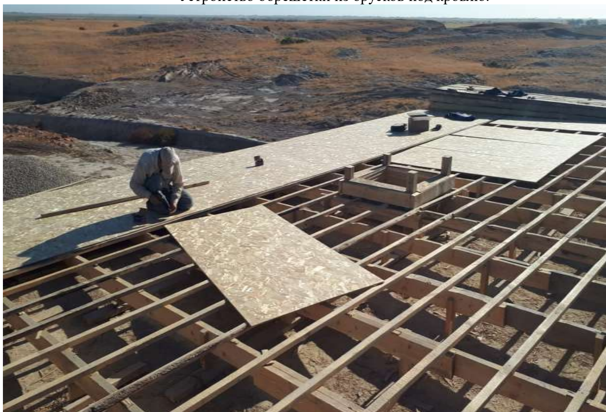
Устройство основания из плит OSB.
