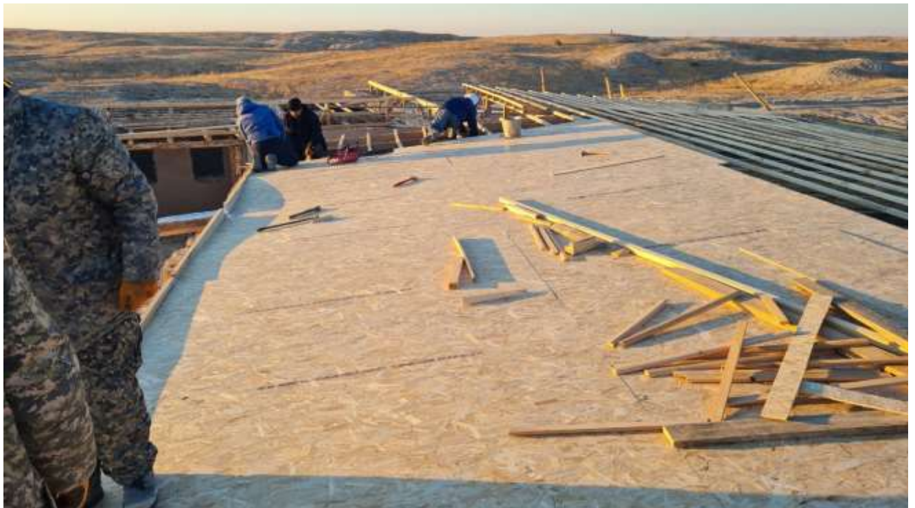
Устройство настила из OSB
