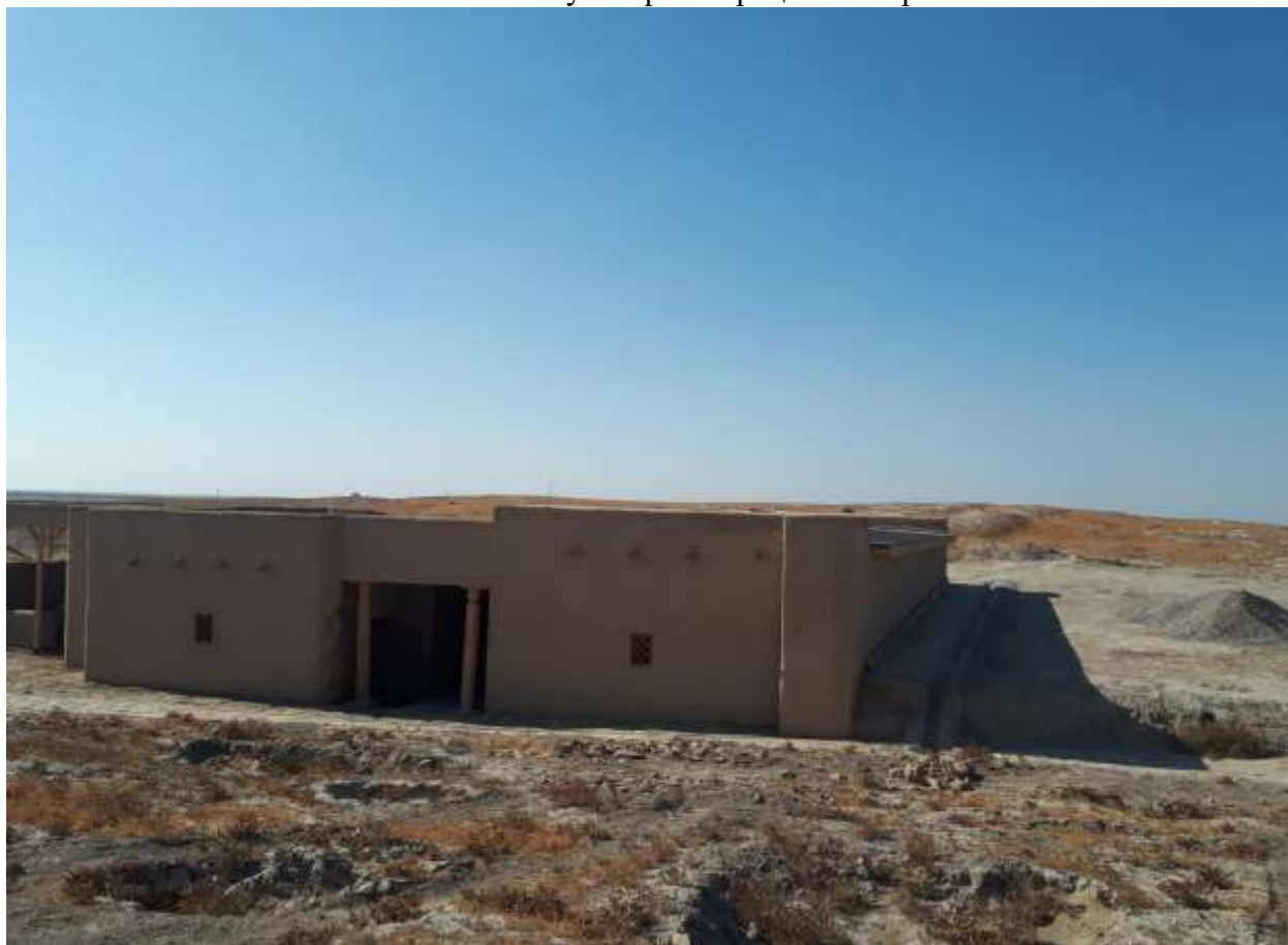
После научно-реставрационных работ
