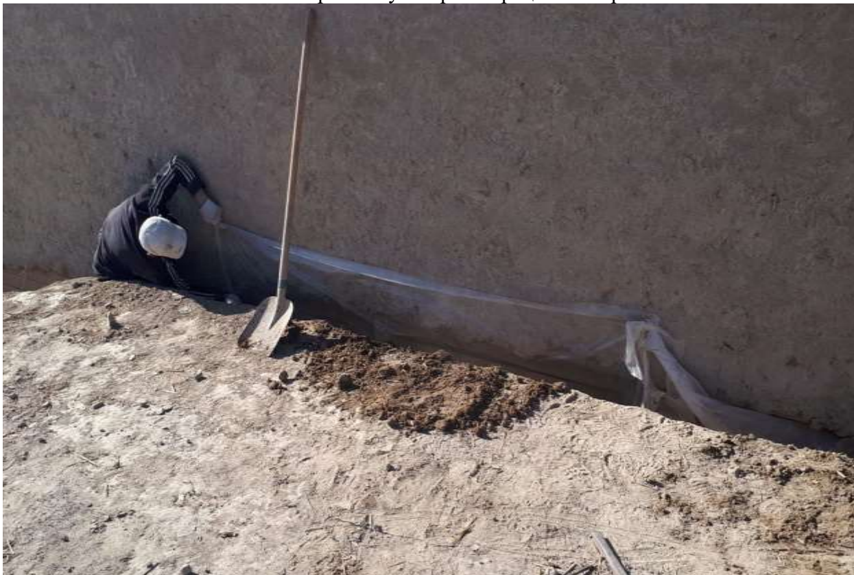
Слои, подстилающие глинобитные вдоль стен. Устройство
