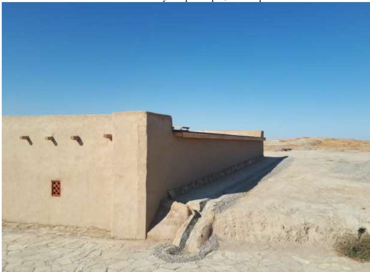
После научно-реставрационных работ
