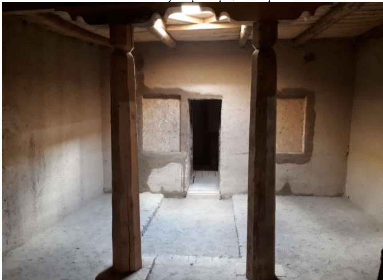
После научно-реставрационных работ
