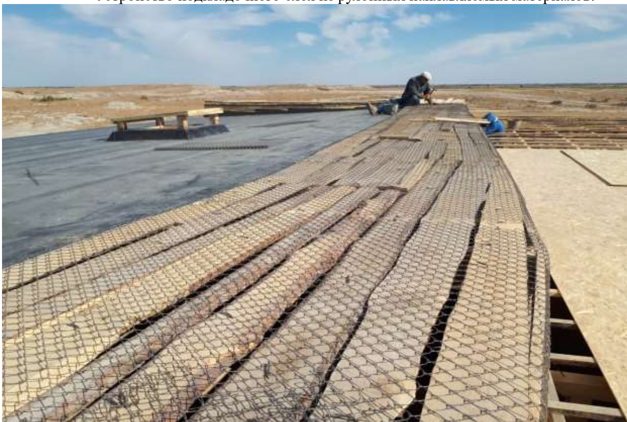
Устройство обшивки парапетов из сеток.
