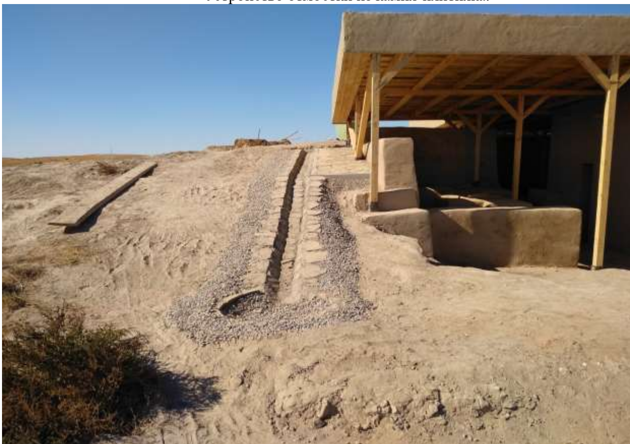
Устройство канавки из камня-плитняка.
