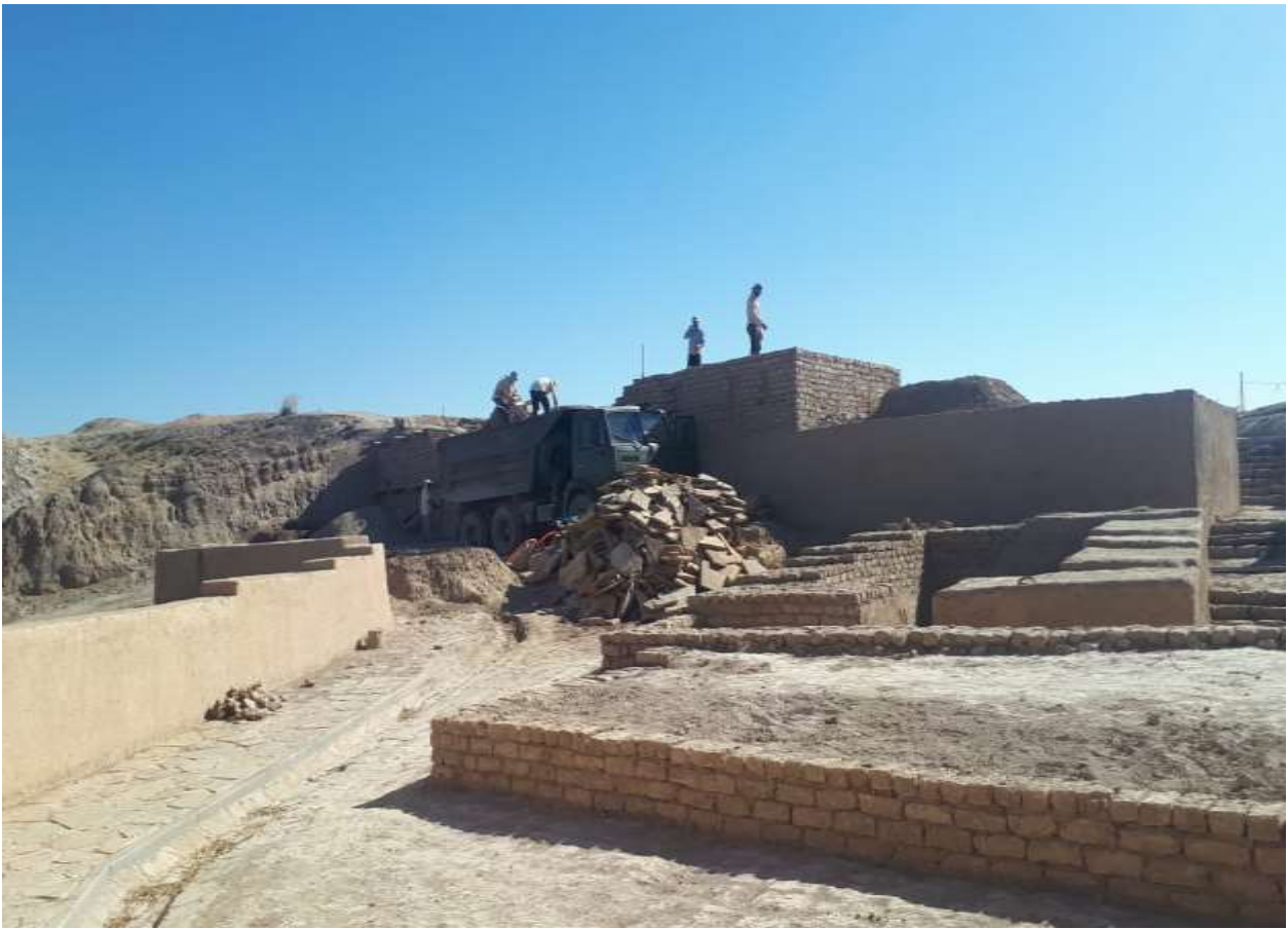
Кладка части крепостной стены
