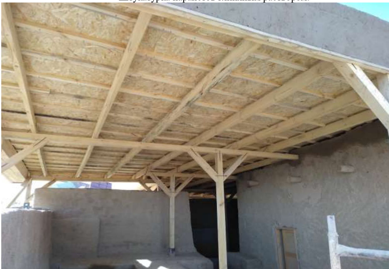
Устройство стропил и конструкции кровли.
