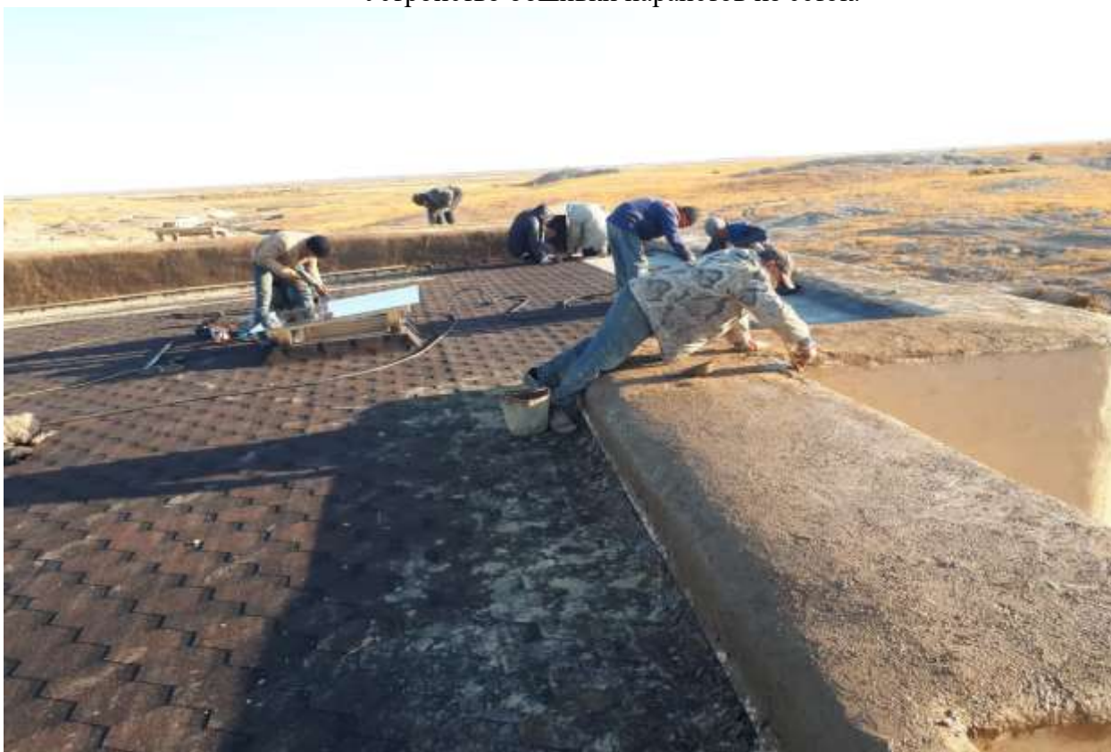
Штукатурка глиняным раствором по сетке парапетов.
