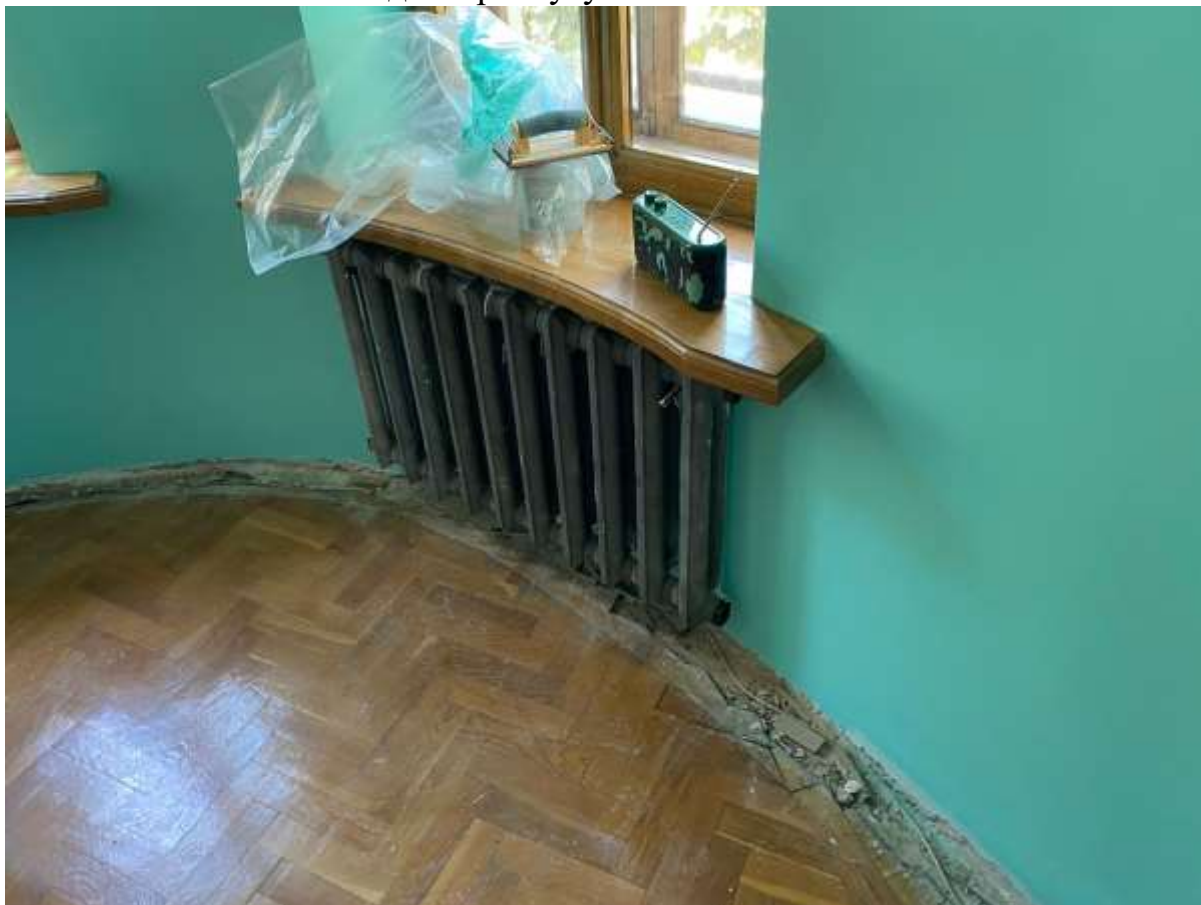
Радиаторы чугунные. Установка
