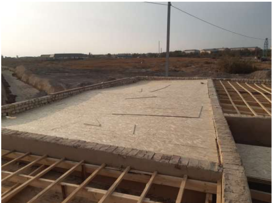
Устройство плиты ОСБ, подкладочного ковра, гибкая черепица Катепал
