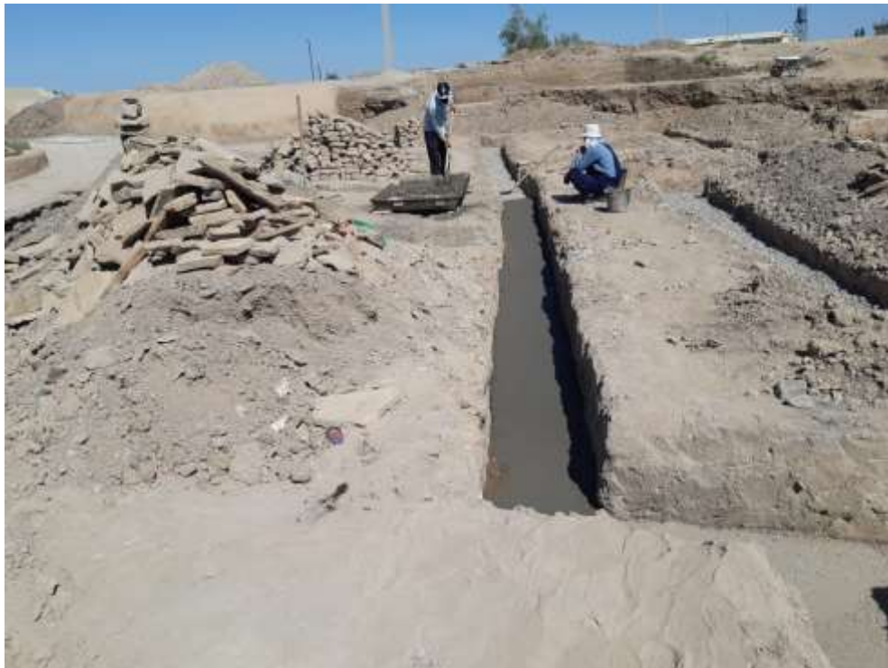
Устройство Бетонного основания
