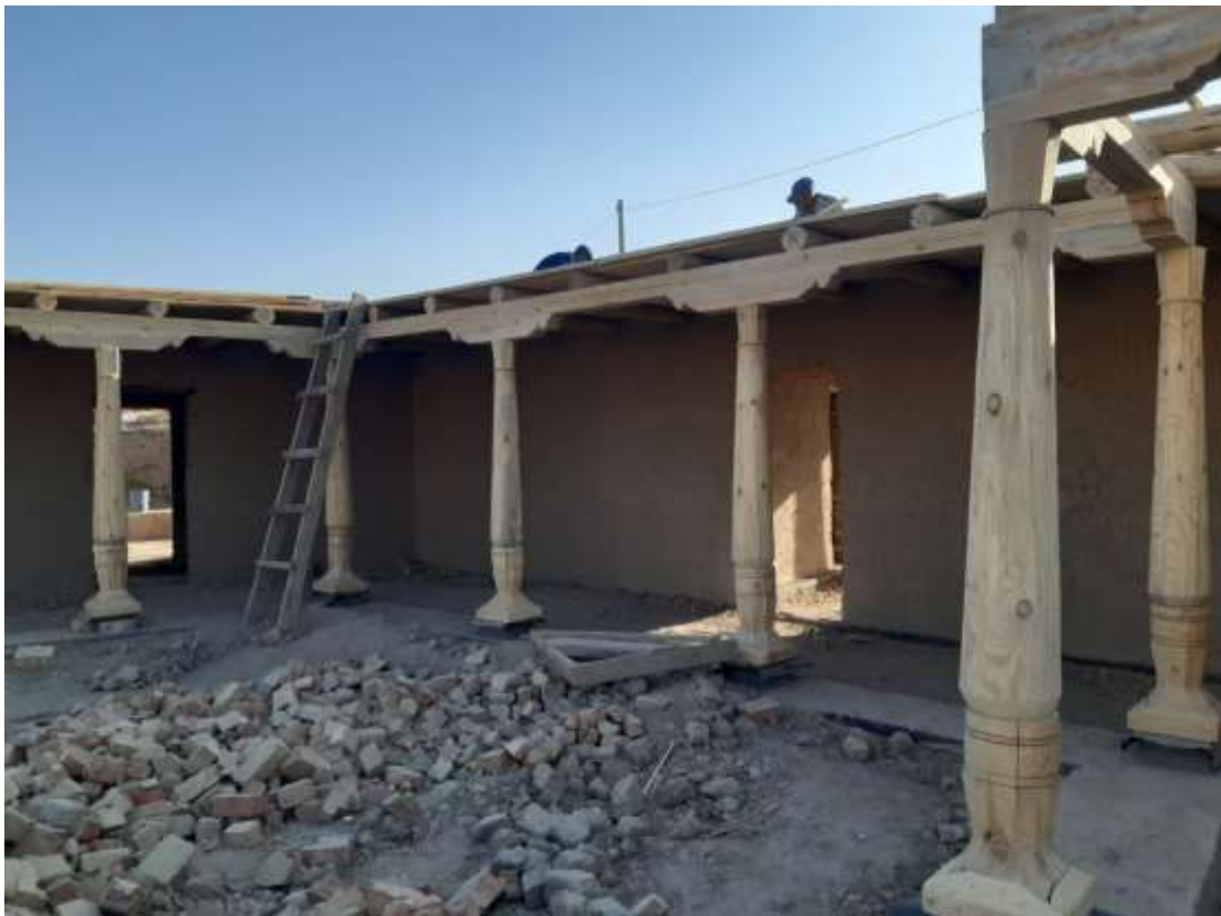
Устройство колон, балок перекрытий, вассы, стропильной конструкции
