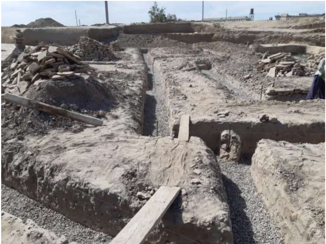
Устройство Бетонного основания
