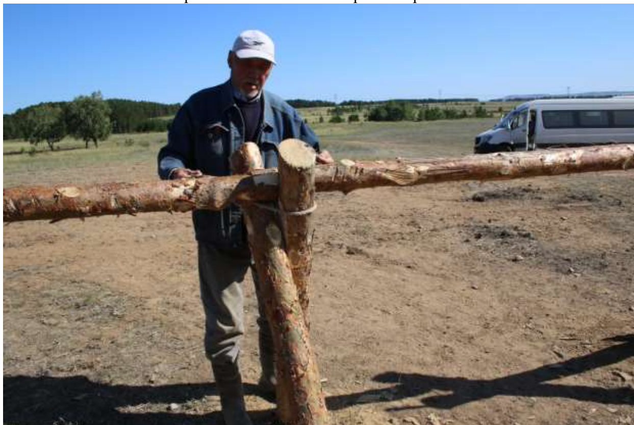
Привязывание льняной веревкой бревен загона.
