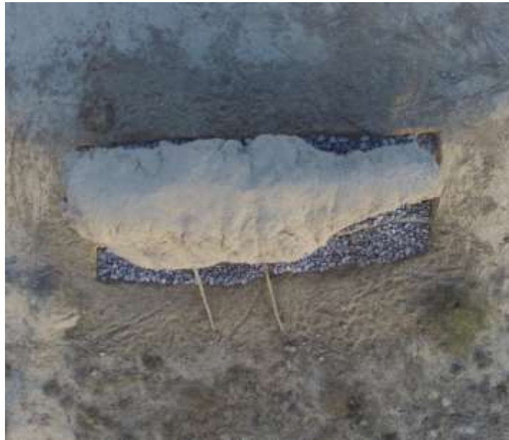
Участок 2. Вид после устройства контрфорсов из сырцовых кирпичей.
