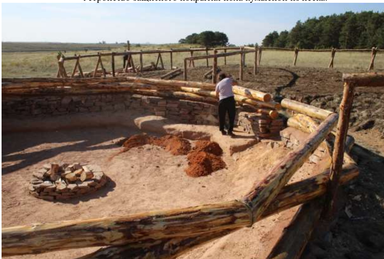
Устройство защитного покрытия пола кумысной из песка.
