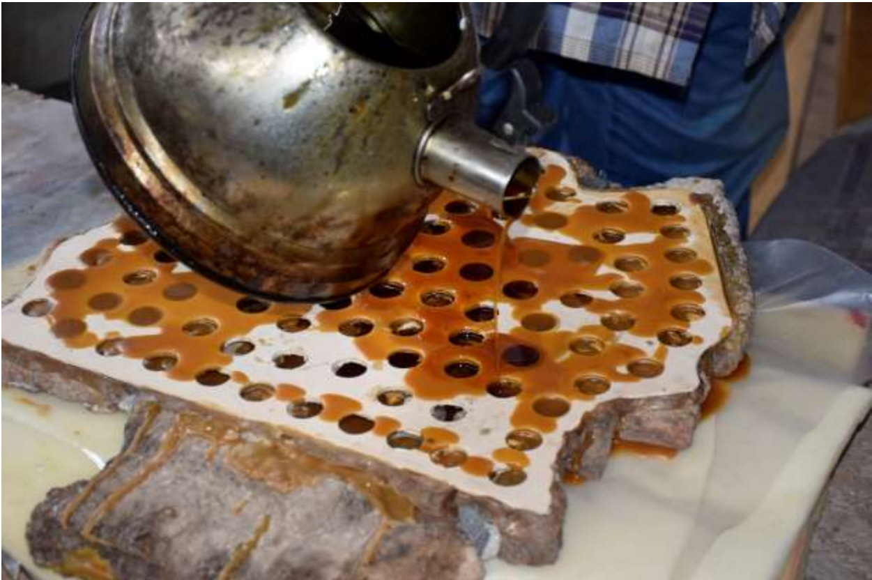
Заполнение полостей расплавленной воско-канифольной мастикой
