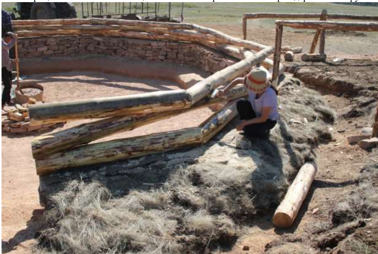
Процесс нанесения огнезащитного слоя и окрашивания олифой деревянных срубов.
