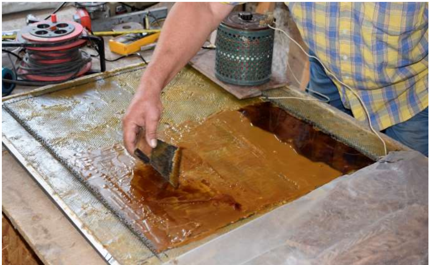
Подготовка нового основания для крупных фрагментов: установка нихромовой спирали вместо металлической сетки
