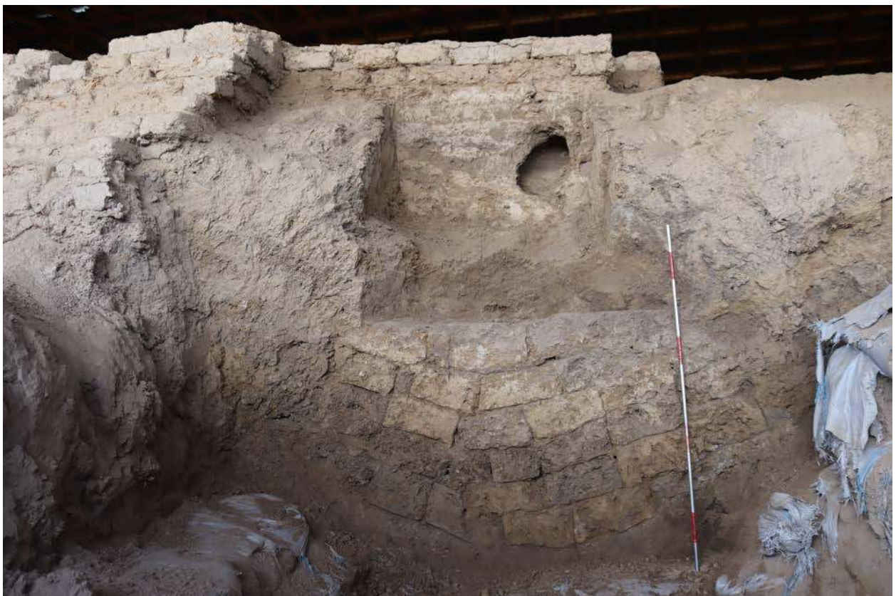
Место дверного проема
