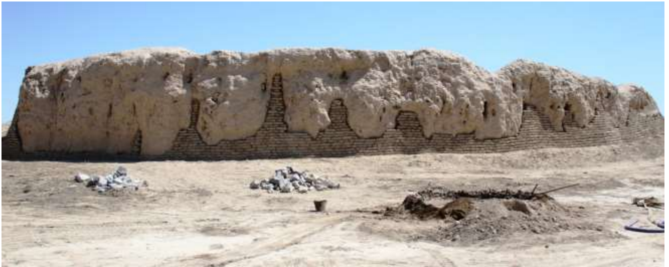
Участок 1. Вид после обмазки глиняным раствором с добавлением соломы и рисовой шелухи.
