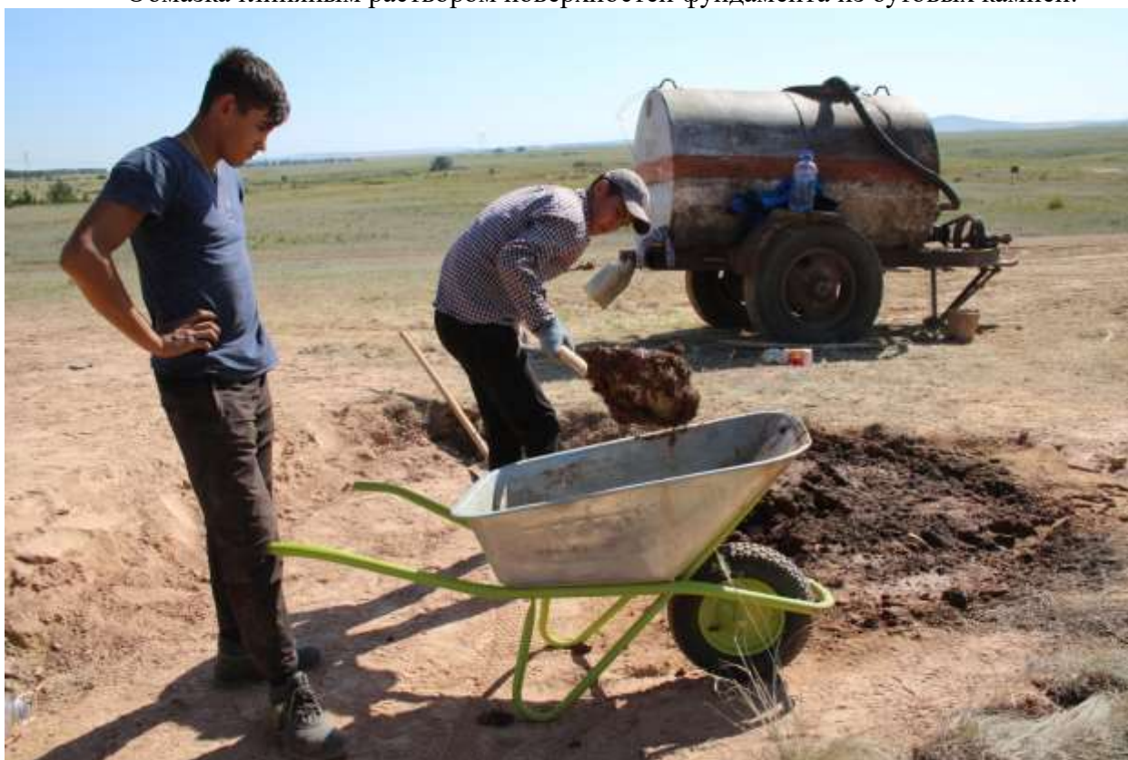
Обмазка глиняным раствором поверхностей фундамента из бутовых камней.
