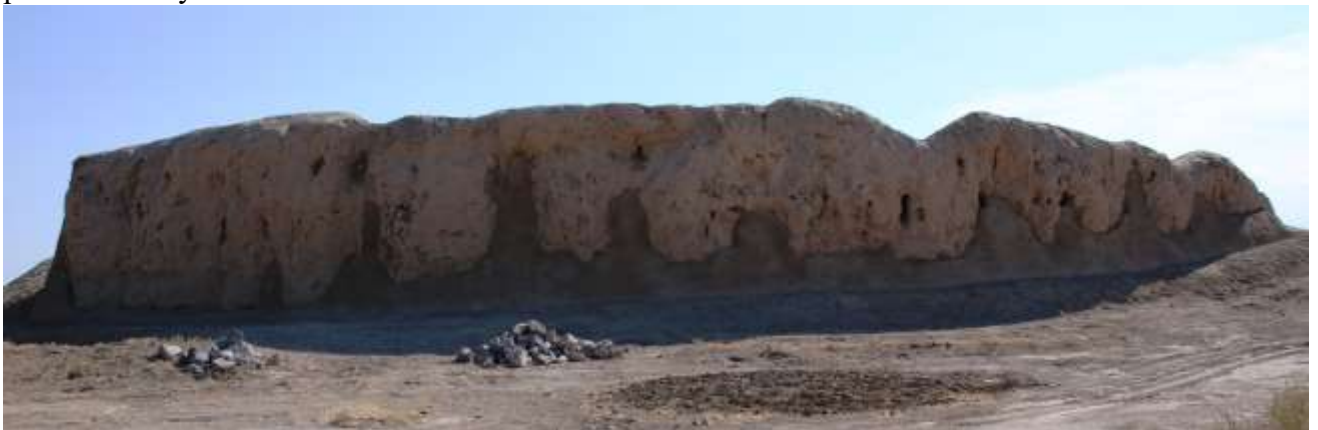
Участок 1. Вид после обмазки глиняным раствором с добавлением соломы и рисовой шелухи.
