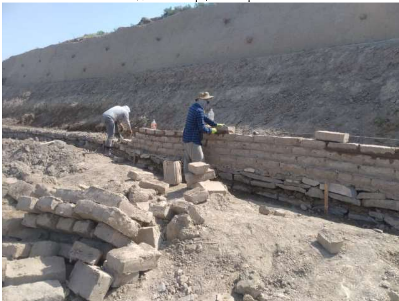
Кладка стен сырцевым кирпичом
