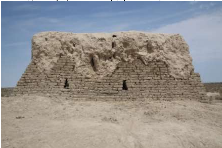
Участок 2. Вид после устройства контрфорсов из сырцовых кирпичей.
