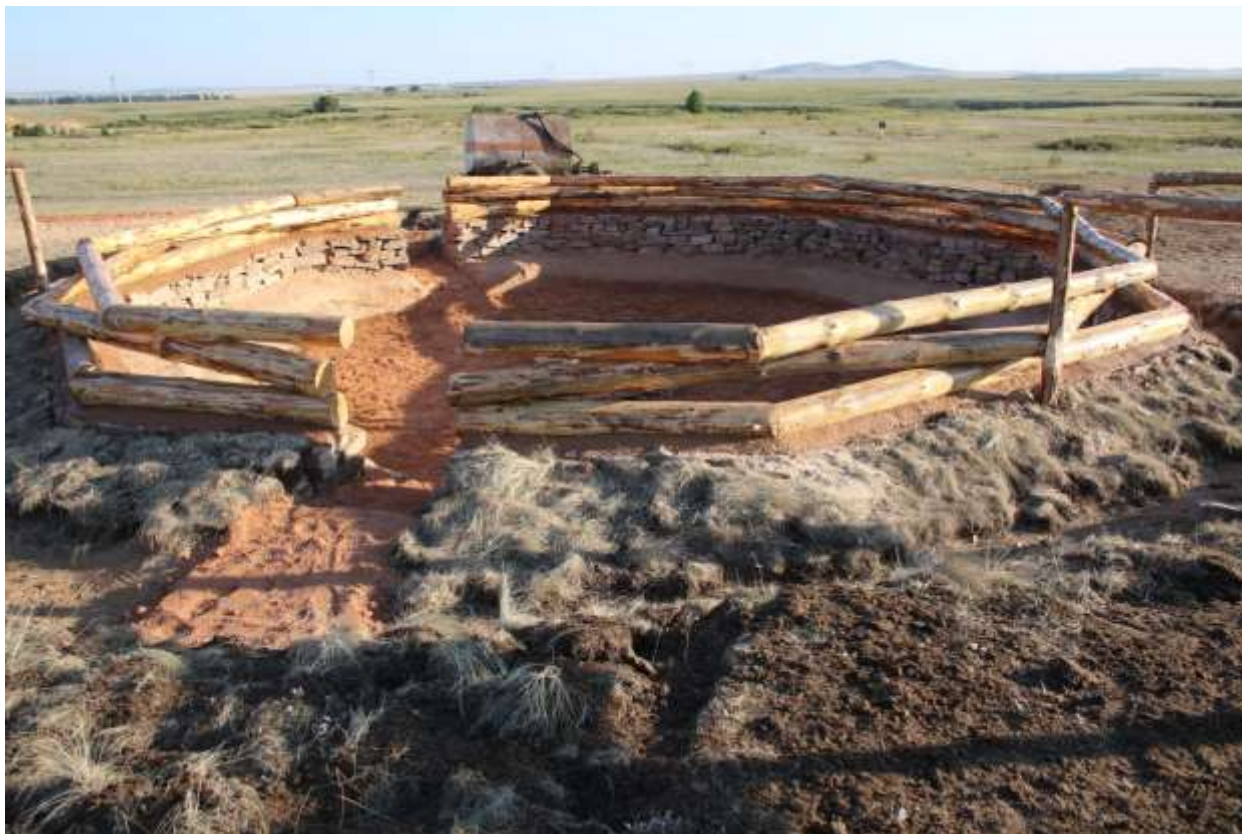
Устройство защитного покрытия пола кумысной из песка.
