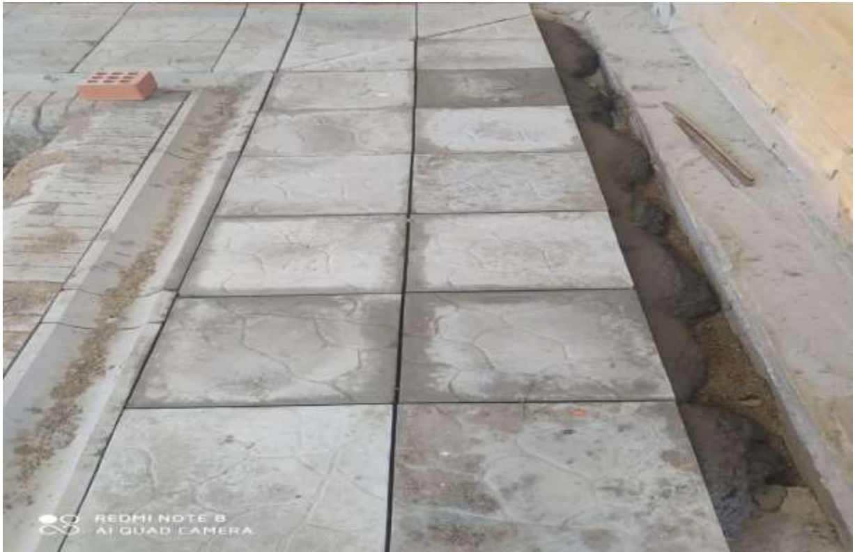
Крыльцо-укладка плитки
