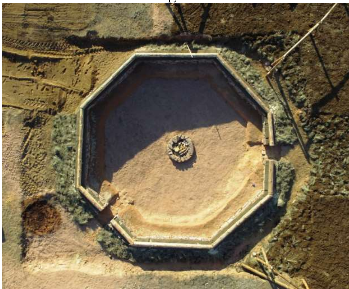
Вид объекта после устройства первого ряда оснований стен в виде восьмигранного деревянного сруба
