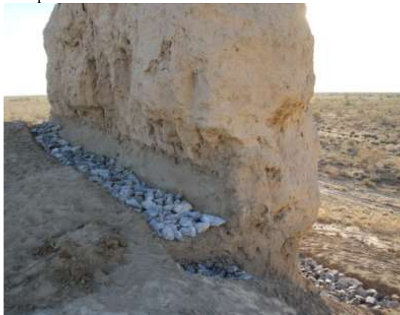
Участок 2. Устройство каменного основания
