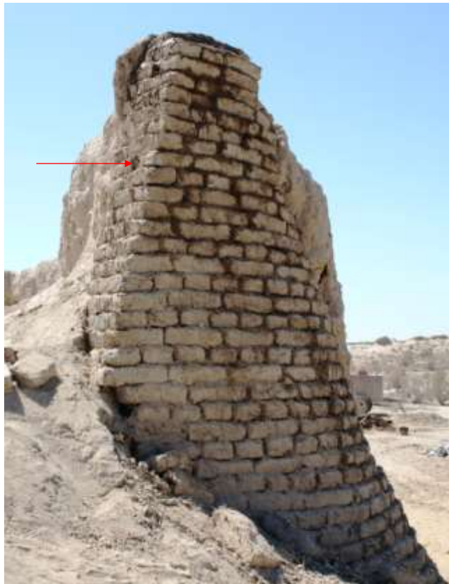
Участок 1. Вид после устройства контрфорсов из сырцовых кирпичей.
