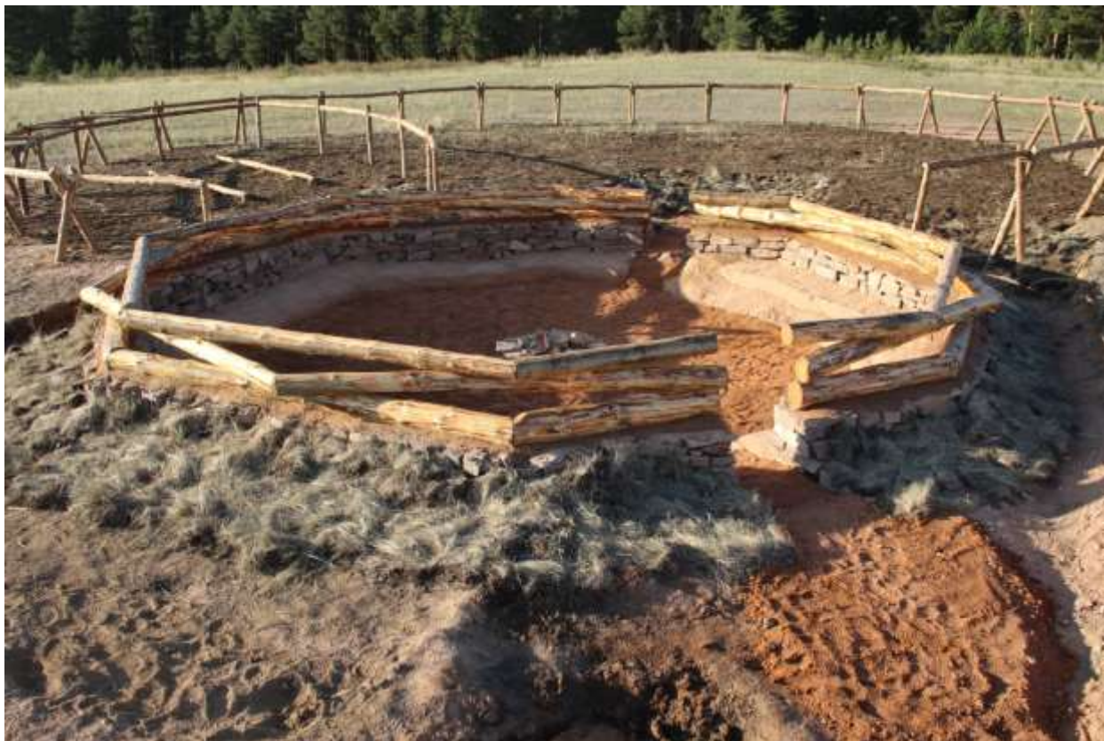
Обмазка глиняным раствором поверхностей фундамента из бутовых камней.
