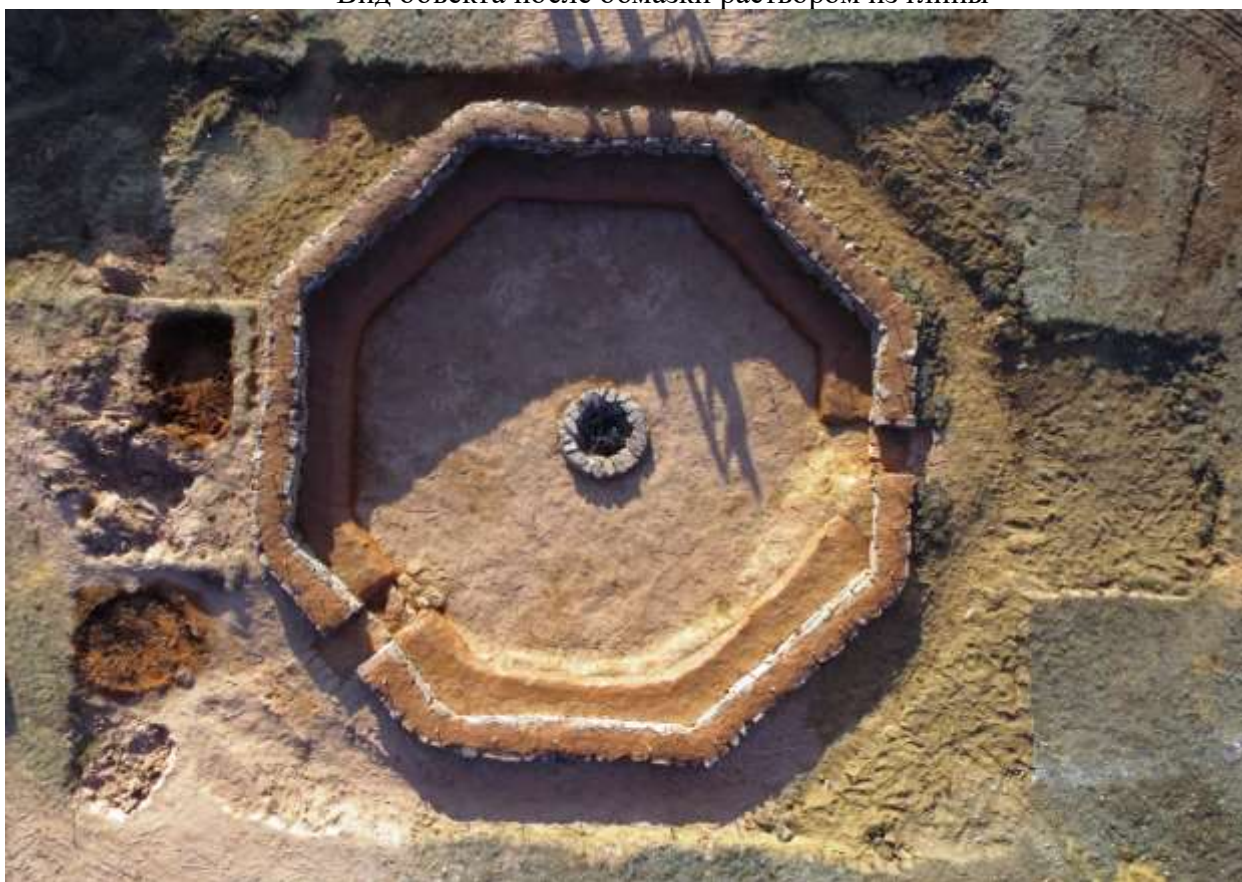
Вид объекта после обмазки раствором из глины
