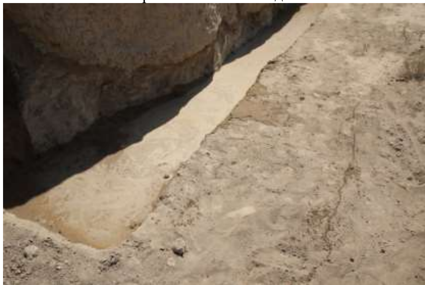
Участок 1. Уплотнение поверхностного слоя водой.
