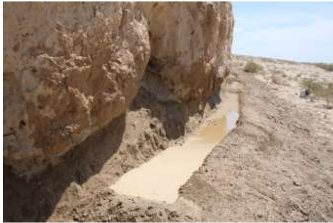
Участок 1. Устройство каменного основания
