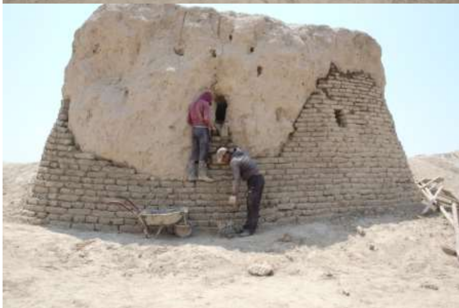
Участок 2. Вид после обмазки глиняным раствором с добавлением соломы и
