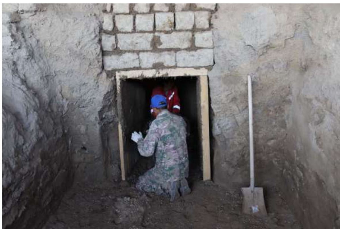
Обмазка вертикальных стеновых поверхностей глиняным раствором
