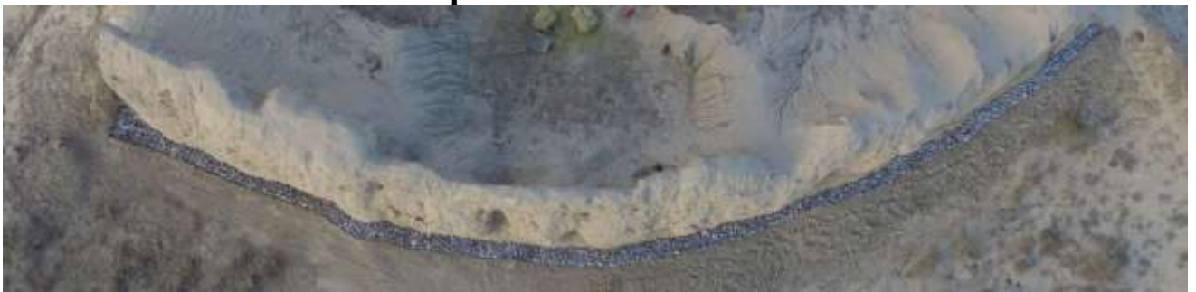
Участок 1. Вид после устройства контрфорсов из сырцовых кирпичей.
