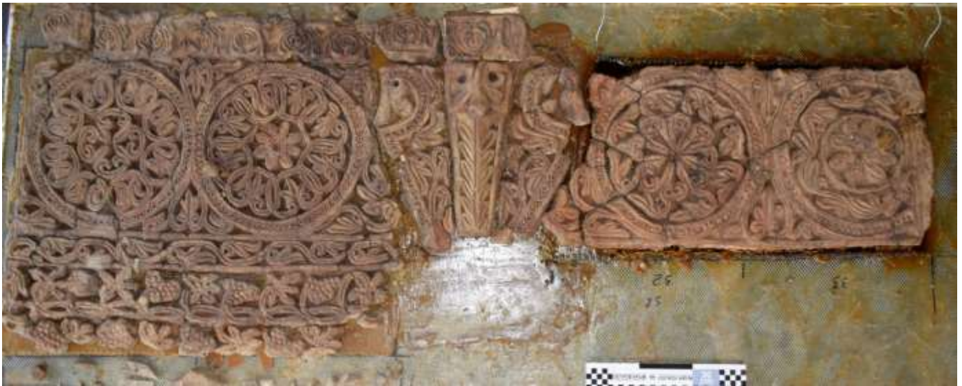
Крупные фрагменты панелей резной глины после приклейки на новое основание. Фрагменты ЮЗ-1, 2, 3. Следующим этапом будут работы по дополнению глины в местах утрат
