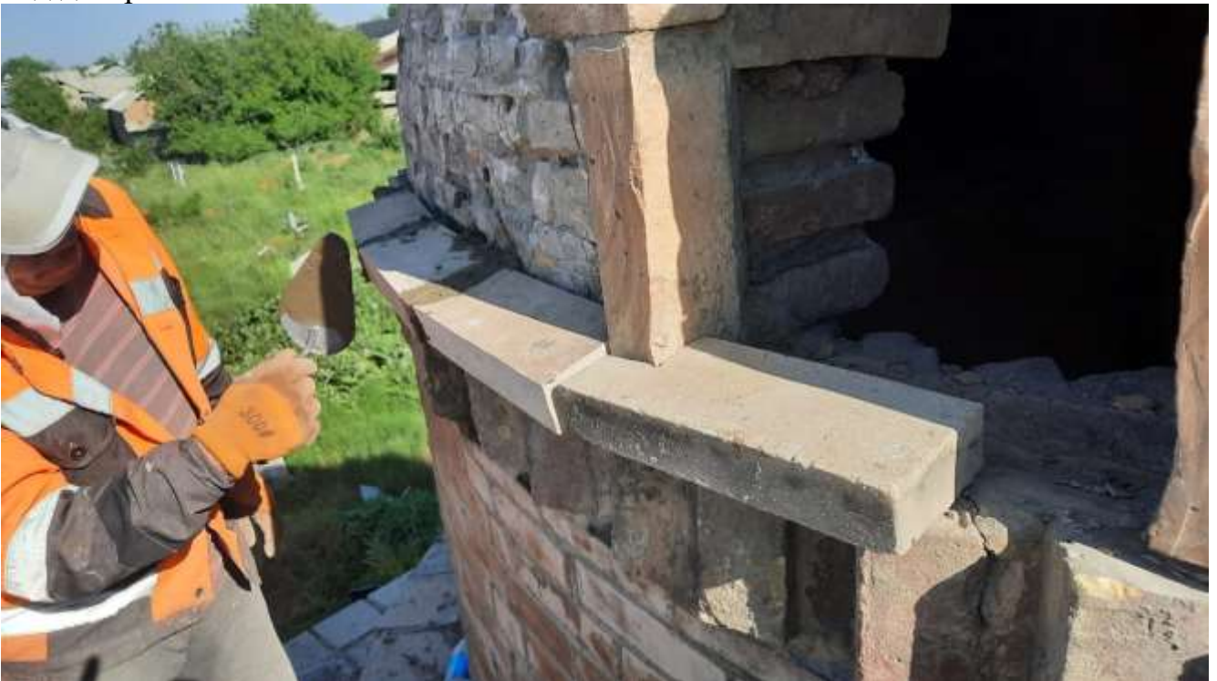
Устройство одного ряда кирпича по периметру купола в виде напускного карниза над декоративным поясом
