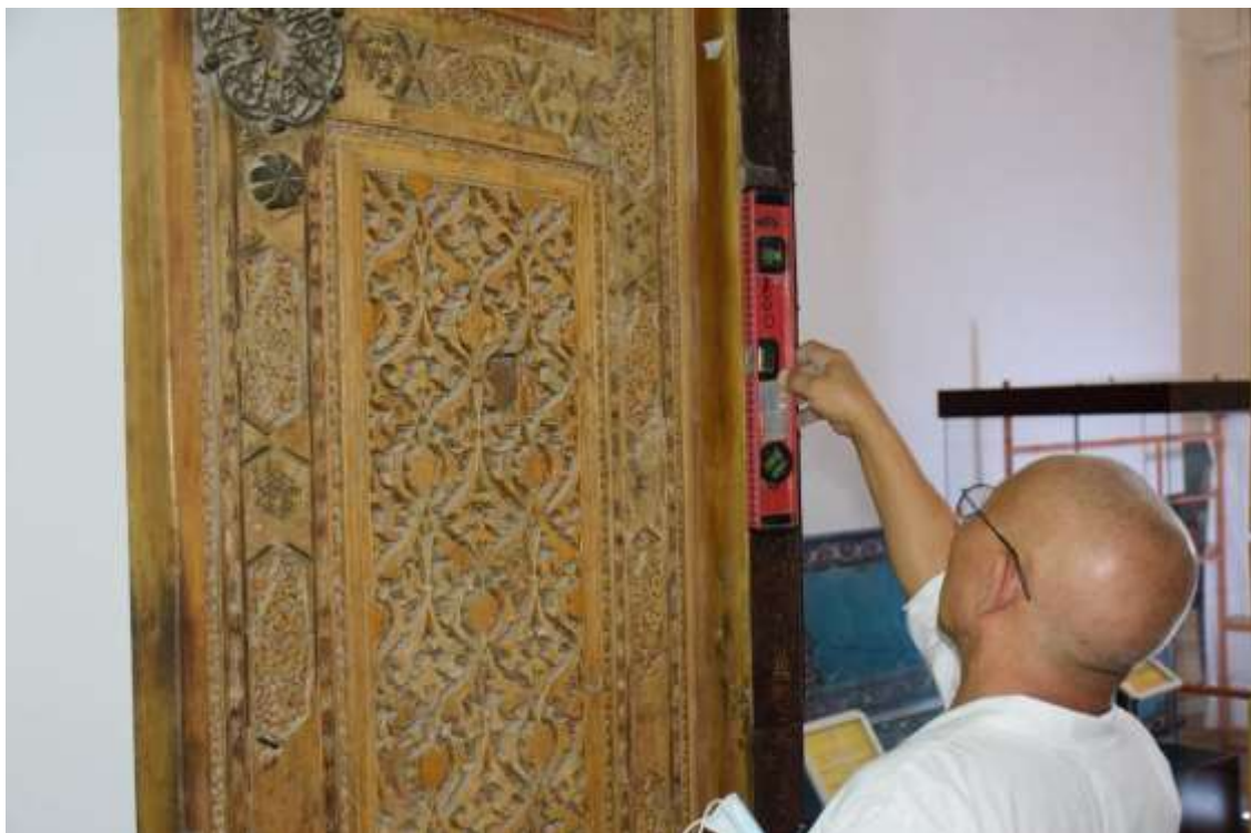
Подготовка к снятию старой двери
