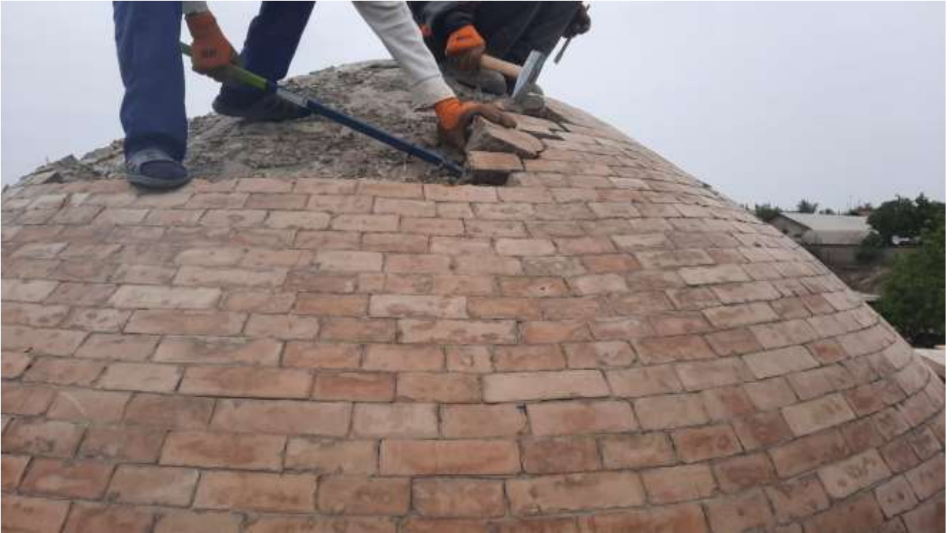
Демонтаж облицовки купола
