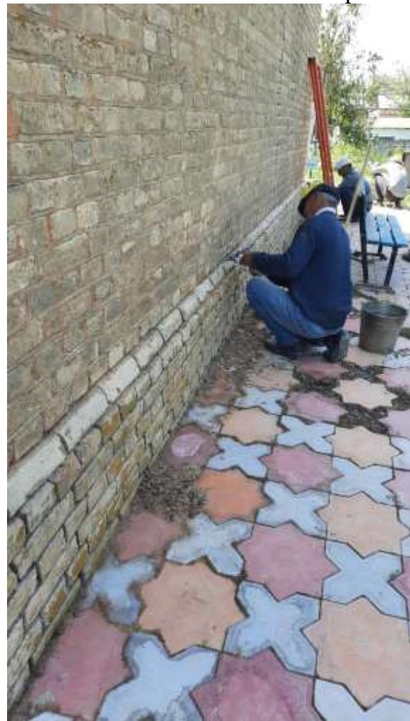
Вычинка швов кладки существующих стен с заполнением швов извест. раствором
