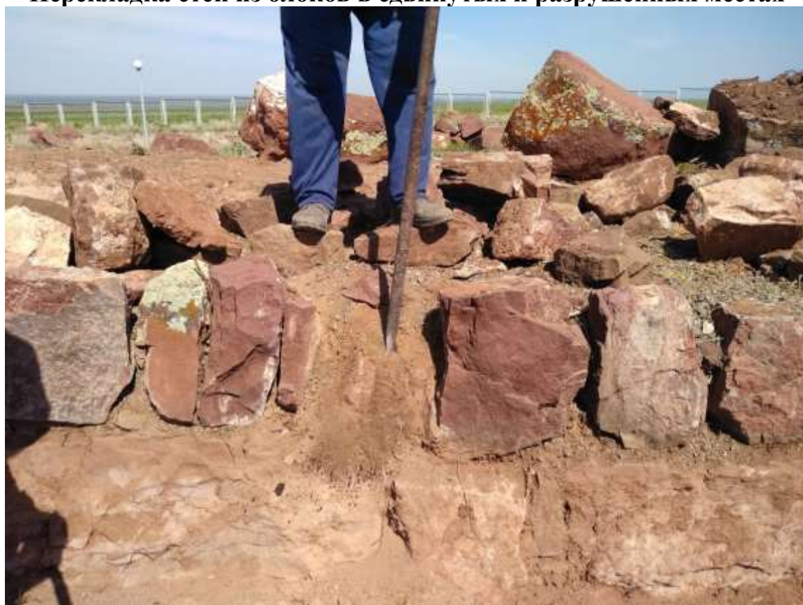
Перекладка стен из блоков в сдвинутых и разрушенных местах
