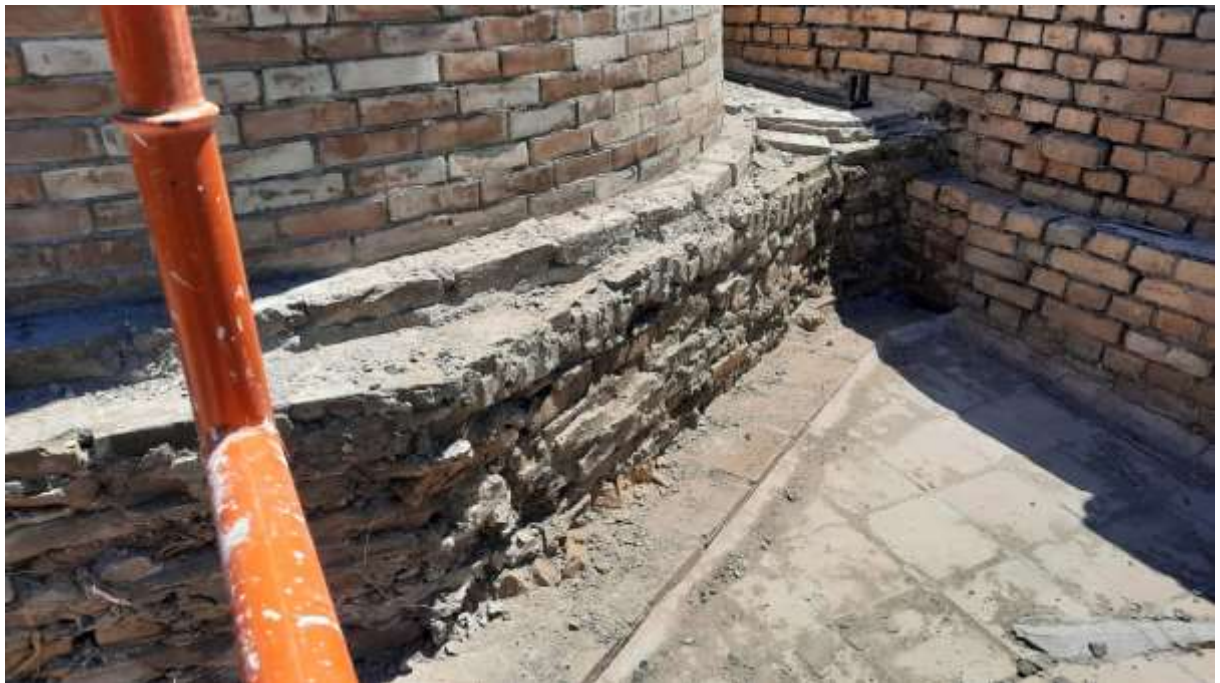
Перекладка восьмигранного барабана из реставрационного кирпича
