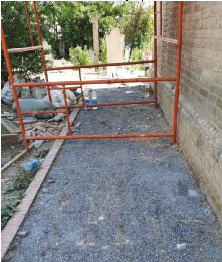
Укладка щебня, устройство отмостки из камня песчаника
