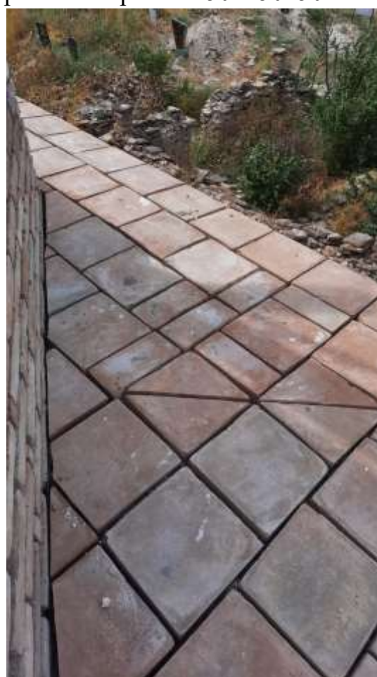
Покрытие плоской кровли четверика из кирпича 250x250x50
