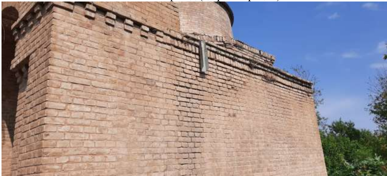
Восточный фасад (до реставрации)
