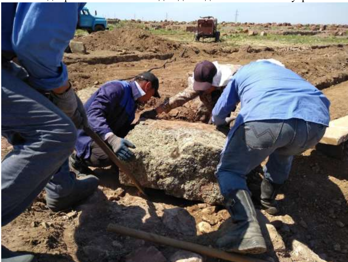
Подбор каменных блоков для докладки стен в местах утрат
