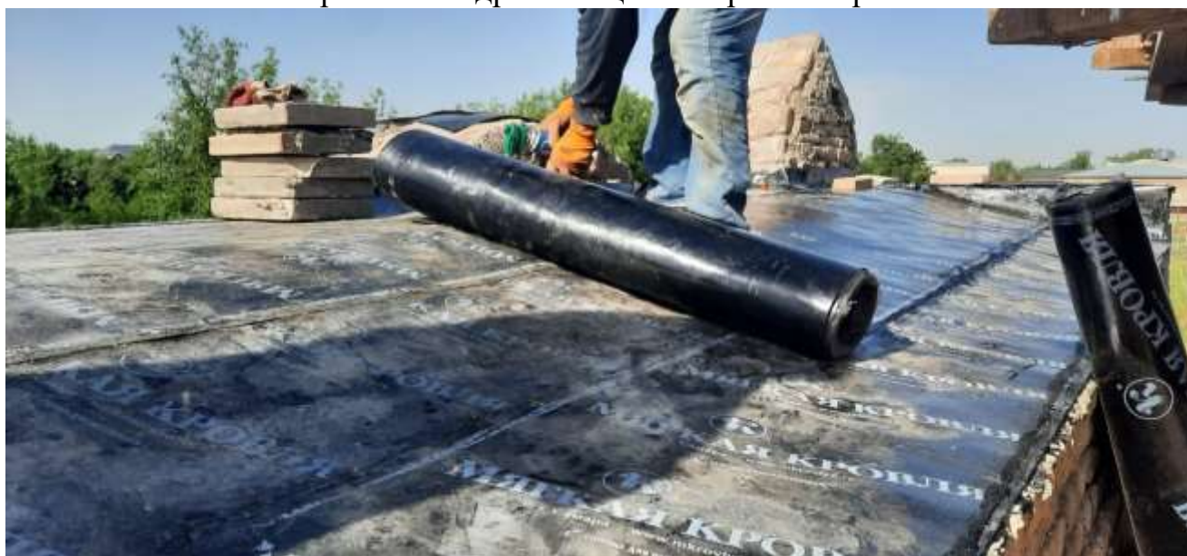
Устройство гидроизоляции на кровле портала
