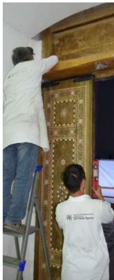
Установка одного полотна новой двери
