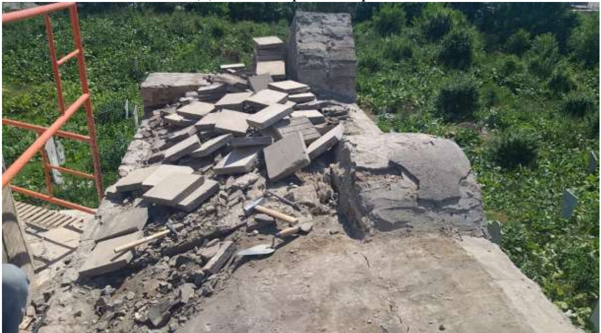
Демонтаж кровли портала
