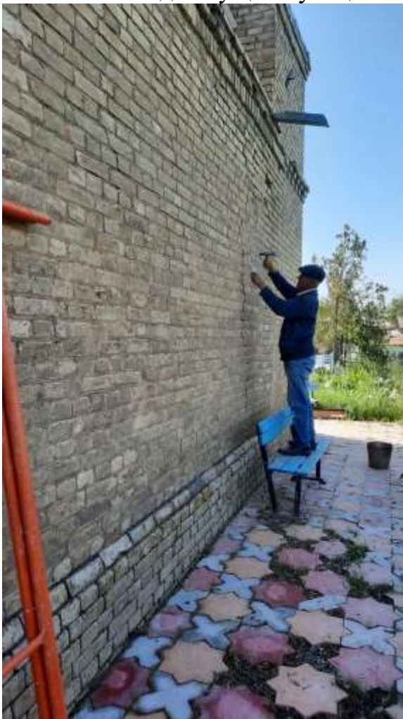
Вычинка швов кладки существующих стен с заполнением швов извест. раствором
