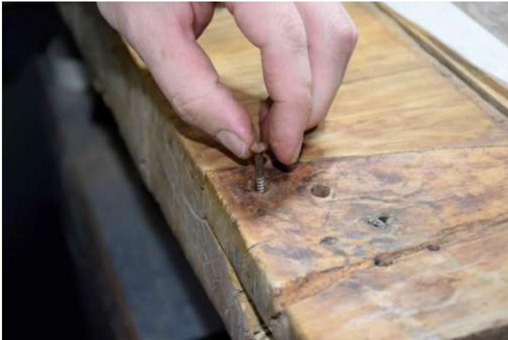
Удаление скобы и современного шурупа
