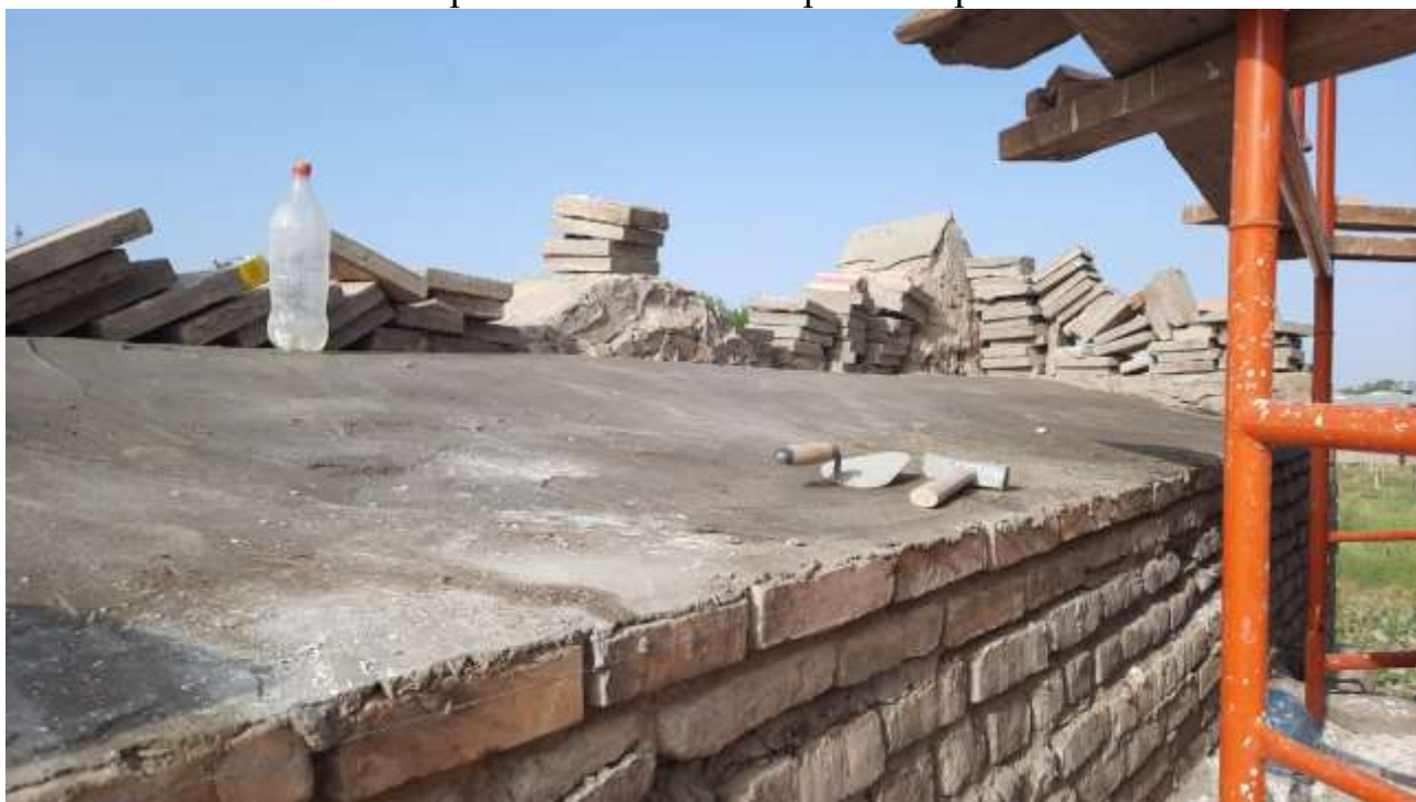
Устройство стяжки на кровле портала
