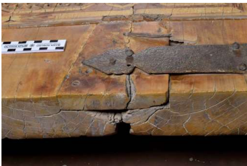
Металлическая полоса-стяжка находится на вставке
