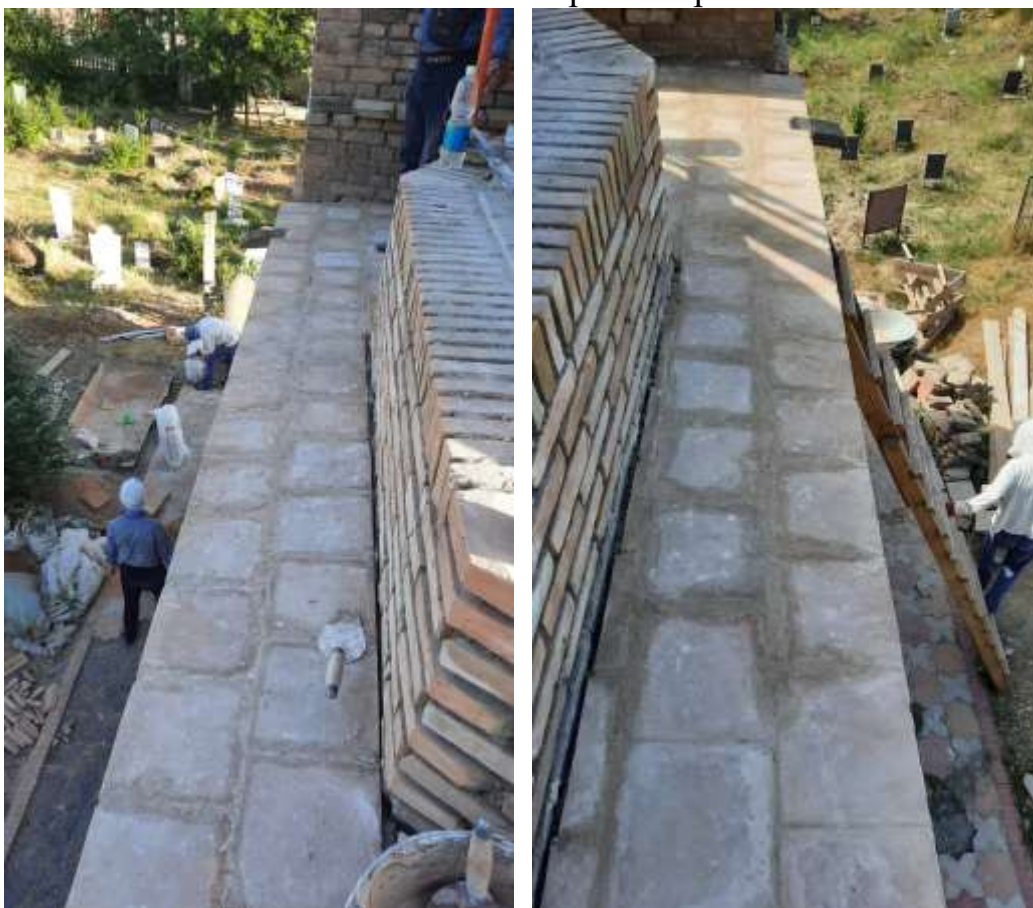
Расшивка швов покрытия кровли
