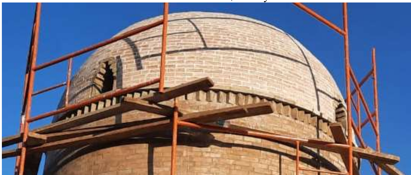
Расшивка швов облицовки купола
