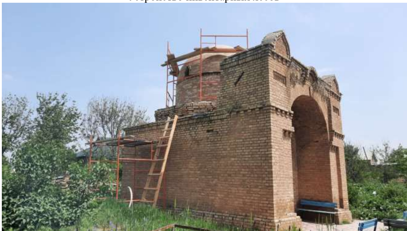
Реставрационные работы кровли. Устройство инвентарных лесов
