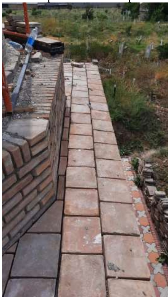
Покрытие плоской кровли четверика из кирпича 250x250x50
