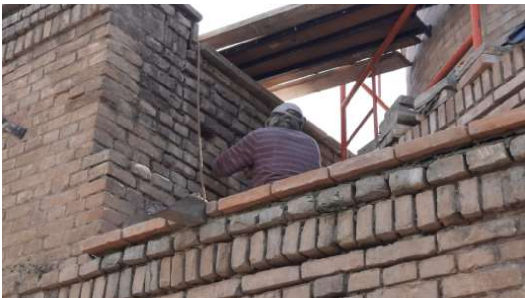
Реставрация кирпичной кладки верхнего ряда северной стены портала
