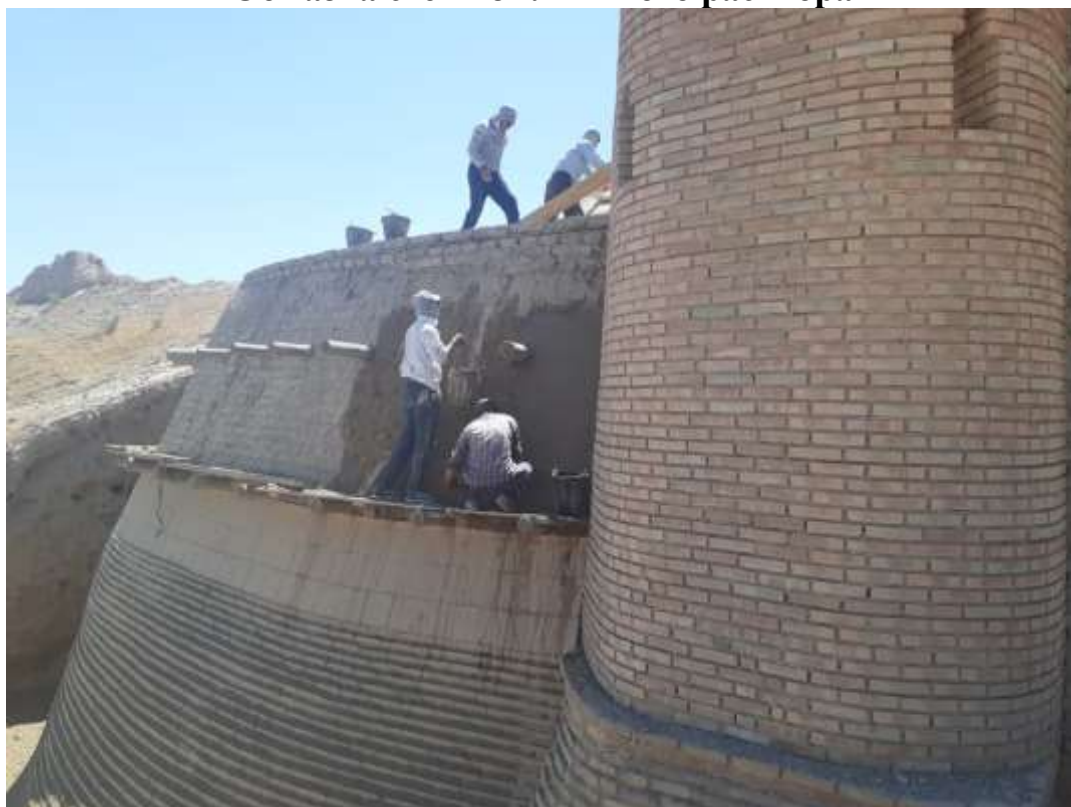
Обмазка стен из глиняного раствора
