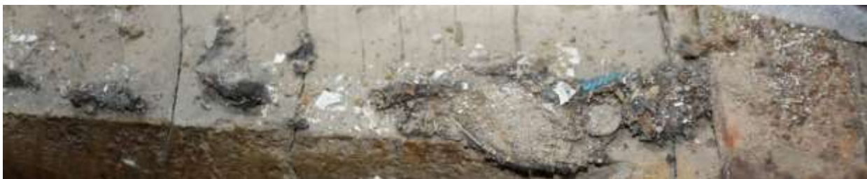
Загрязнения под нижней металлической накладкой внешней стороны двери
