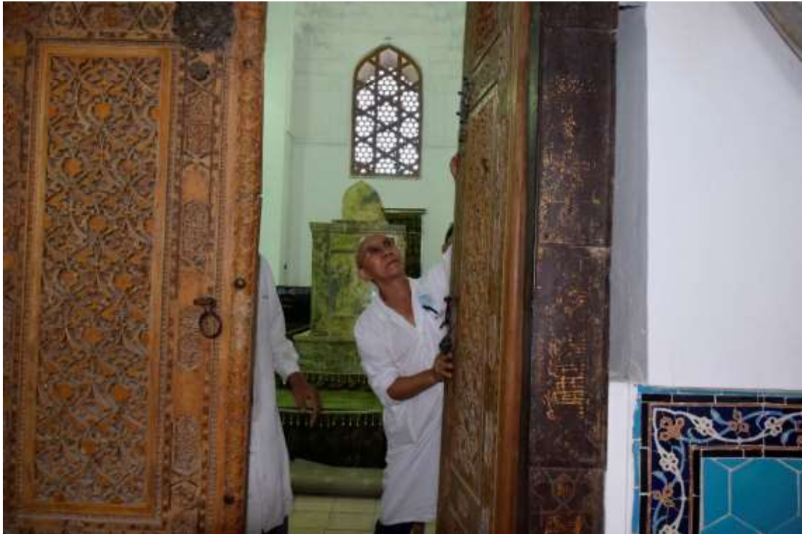
Подготовка к снятию старой двери
