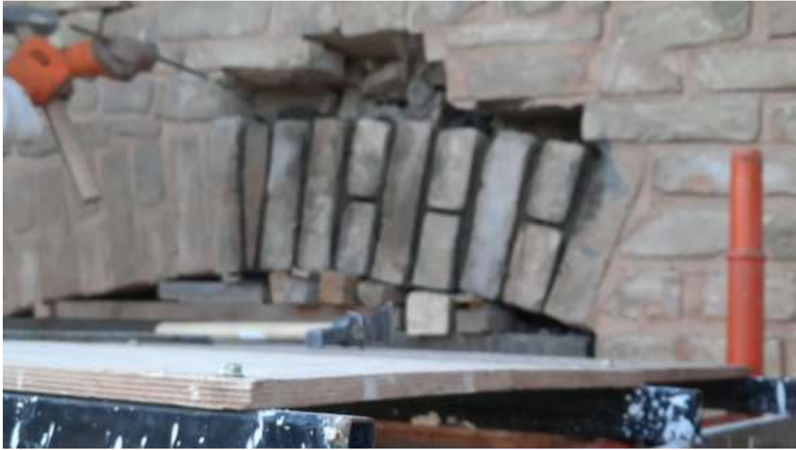
Вычинка швов кладки существующих стен с заполнением швов извест. раствором
