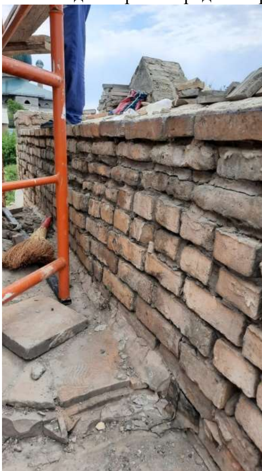
Реставрация кирпичной кладки верхнего ряда северной стены портала
