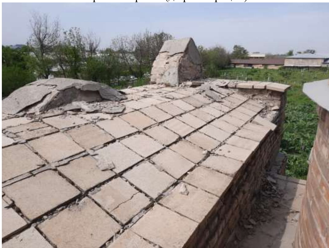
Кровля портала (до реставрации)
