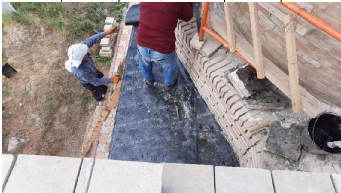
Покрытие плоской кровли четверика из кирпича 250x250x50
