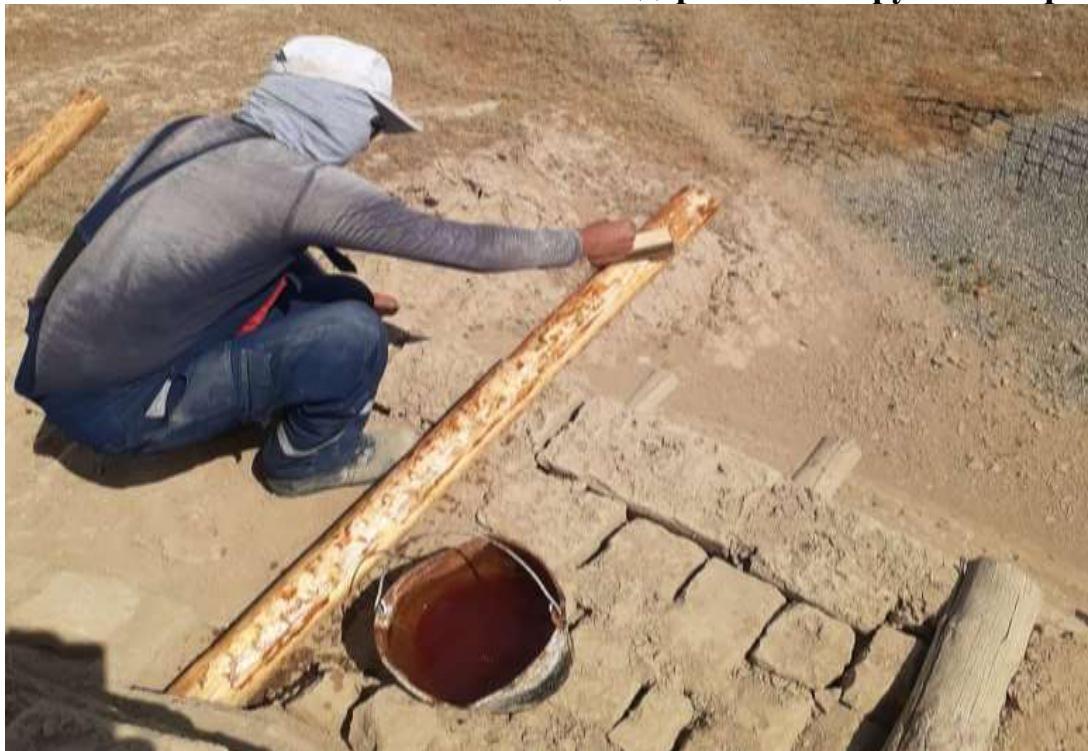
Работы по выполнению огнезащиты деревянных брусков за 2 раза
