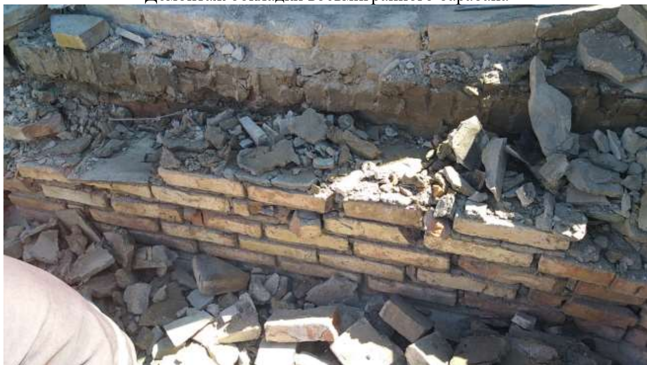
Демонтаж обкладки восьмигранного барабана
