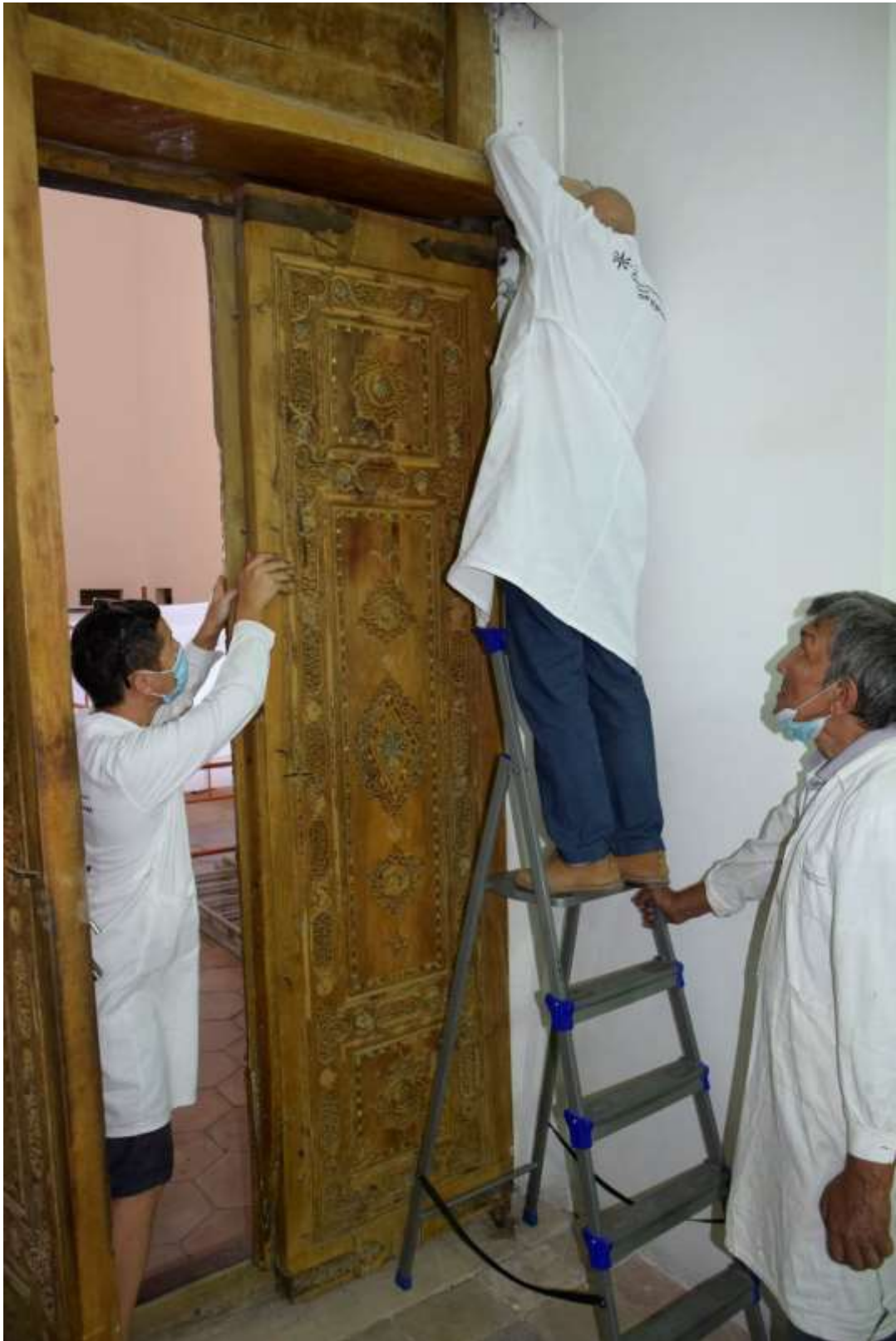
Подготовка к снятию старой двери
