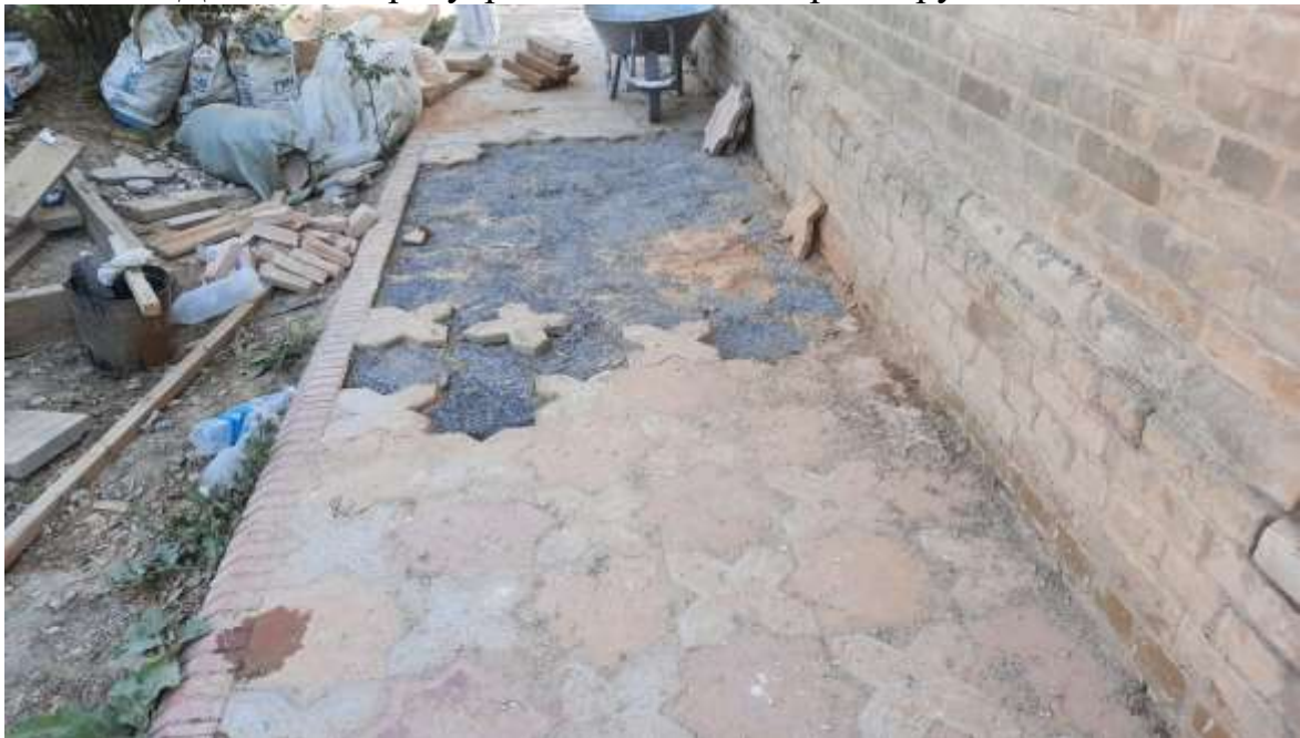
Укладка щебня, устройство отмостки из камня песчаника
