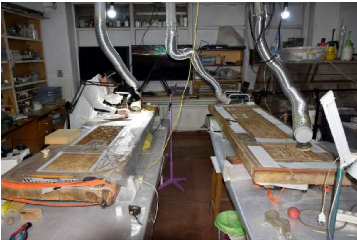
Рабочие места оснащены вытяжной вентиляцией
