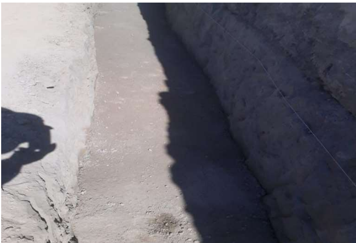
Устройство подготовки бетонной под фундамент
