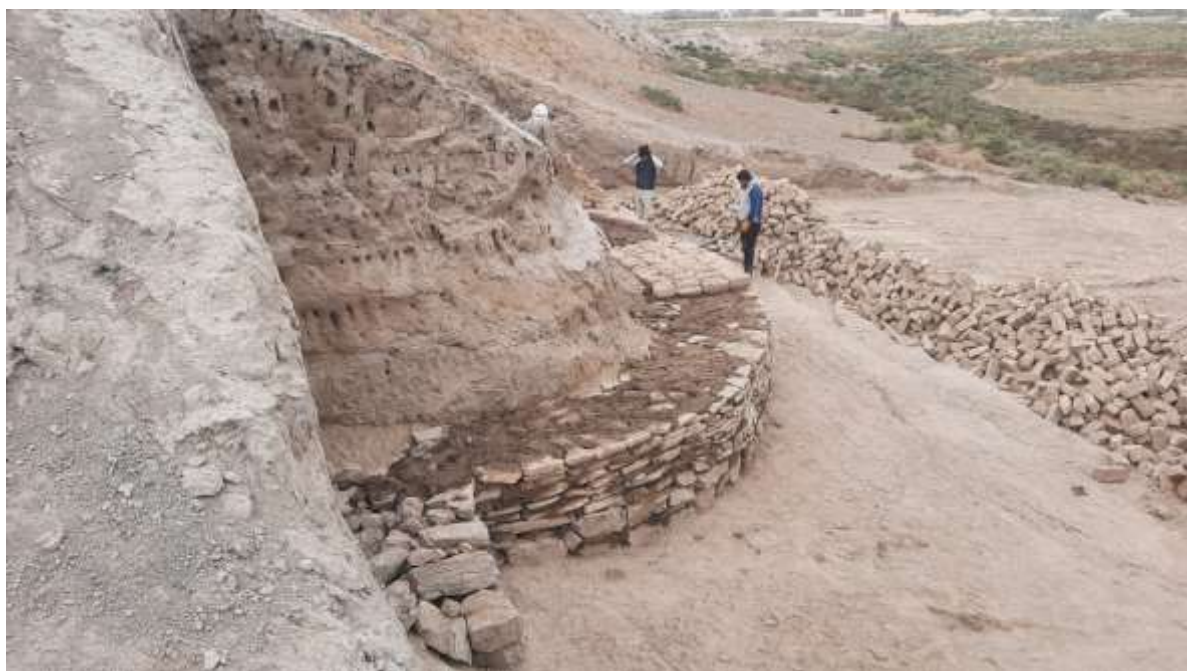
Устройство фундамента из камня плитняка
