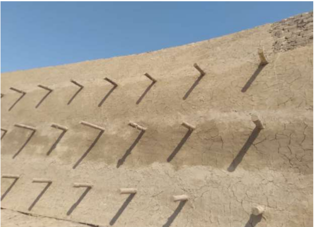
Штукатурка крепостной стены 1-ый слой
