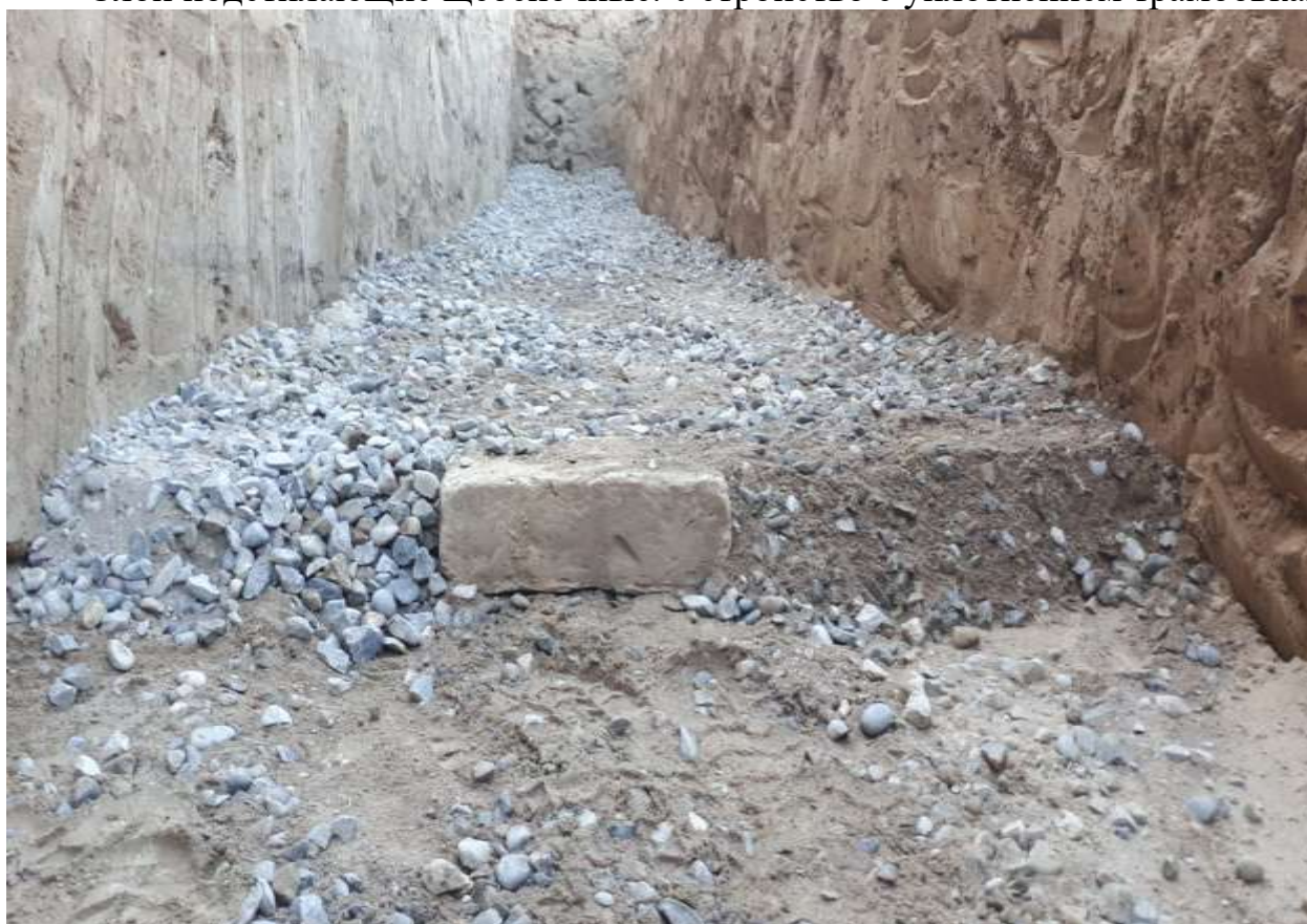
Слой подстилающие щебеночные. Устройство с уплотнением трамбовками
