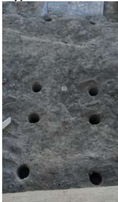
Деревянная лестница Устройство ж/б буронабивных свайных фундаментов
