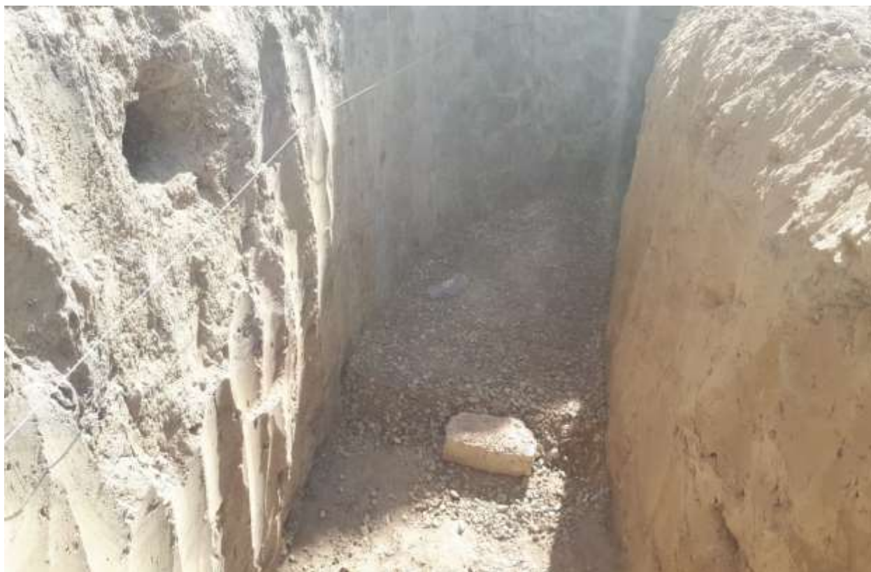
Слой подстилающие щебеночные. Устройство с уплотнением трамбовками
