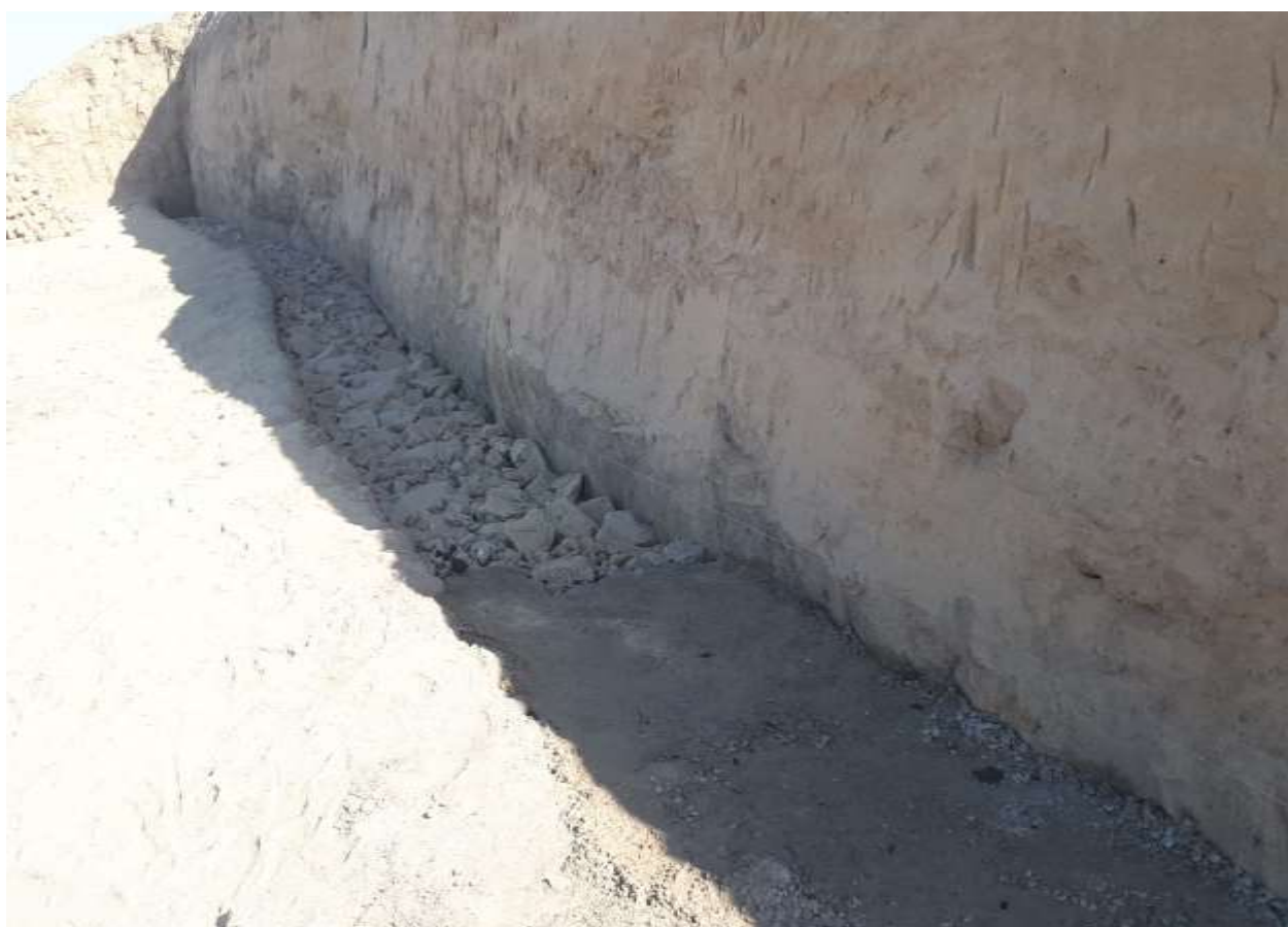
Армирование стены деревянными стержнями. Установка
