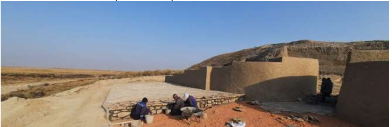
Устройство покрытие из камня плитняка
