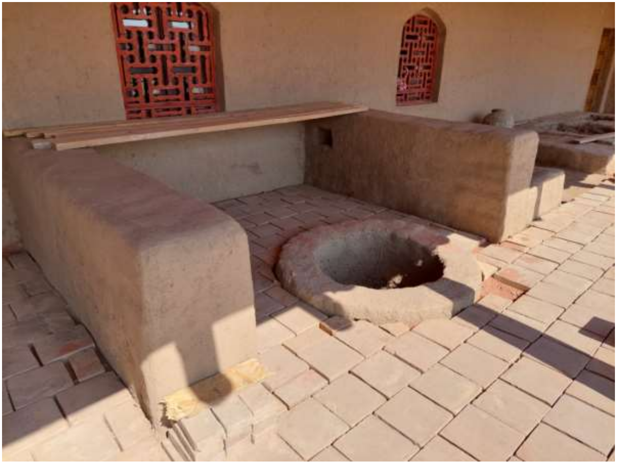
Консервационно-реставрационные работы Пятно 5 и 6 Консервационная кладка из сырцового кирпича Устройство фундамента под обкладку из камня песчаника
