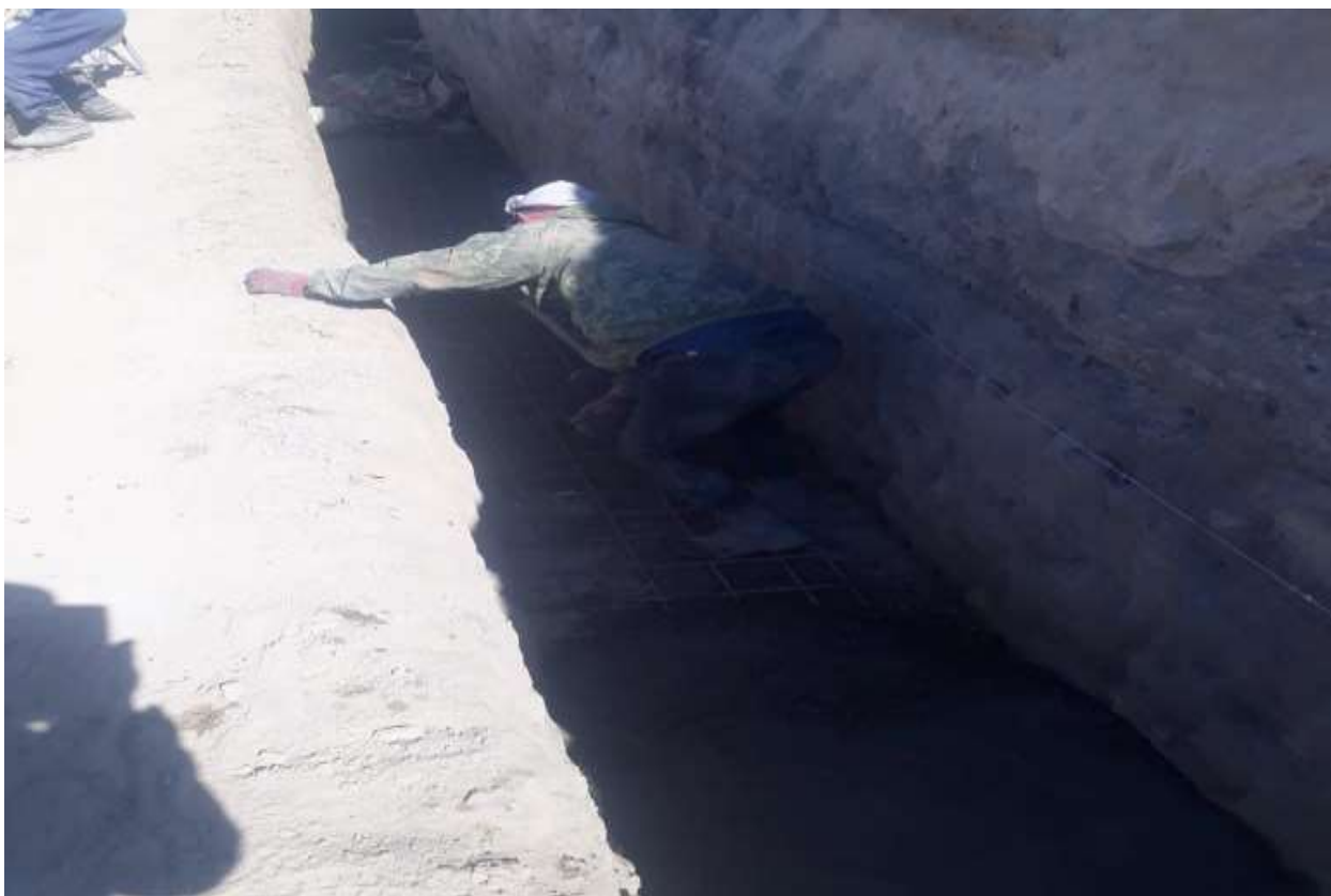
Устройство подготовки бетонной под фундамент
