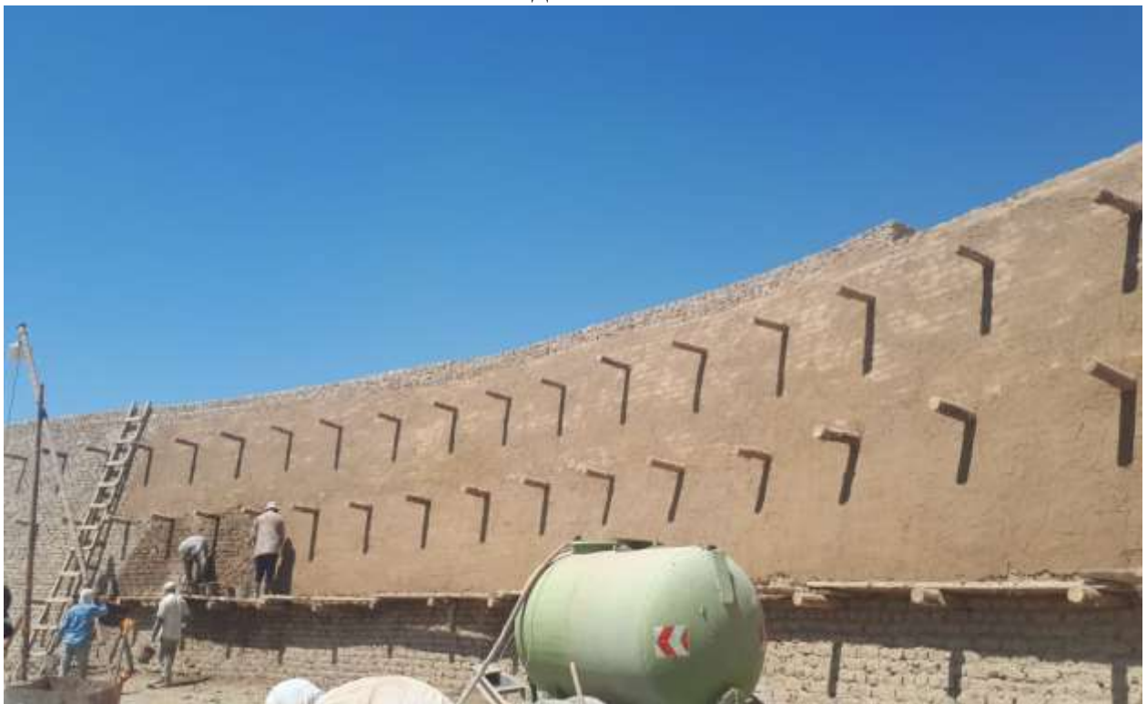
Воссоздание штукатурки из двух слоев по кирпичной поверхности стены длиной 45 м
