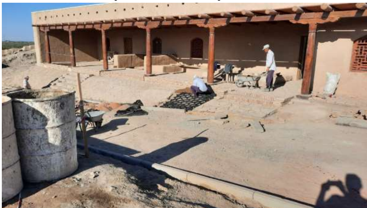
Заполнение ячеек глиняным раствором
