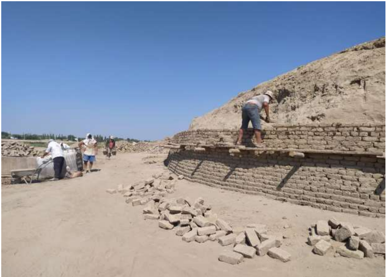
Реставрация и воссоздание кирпичной кладки стен средней сложности
