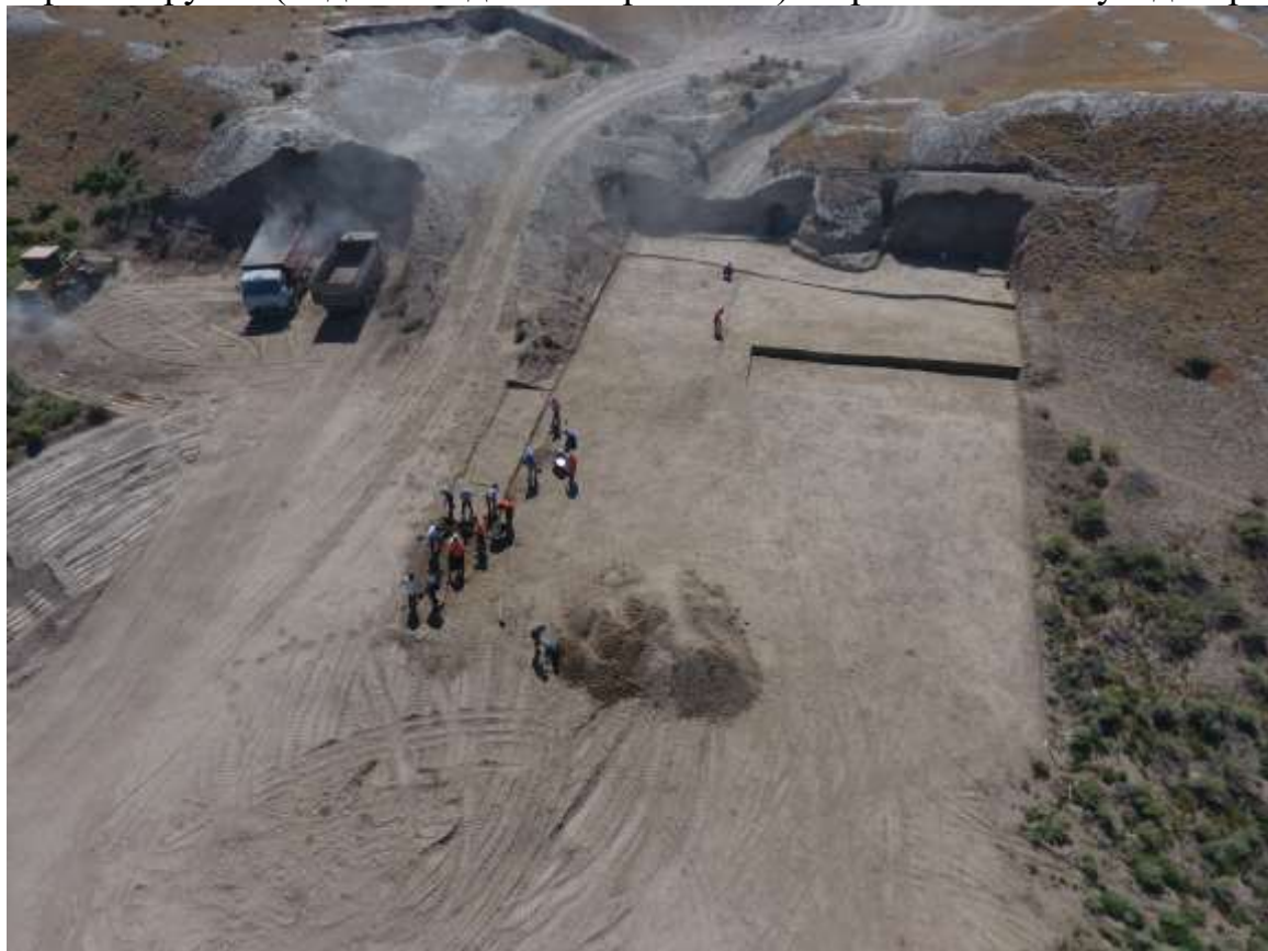
Срезка грунта (под наблюдением археолога) с применением бульдозера
