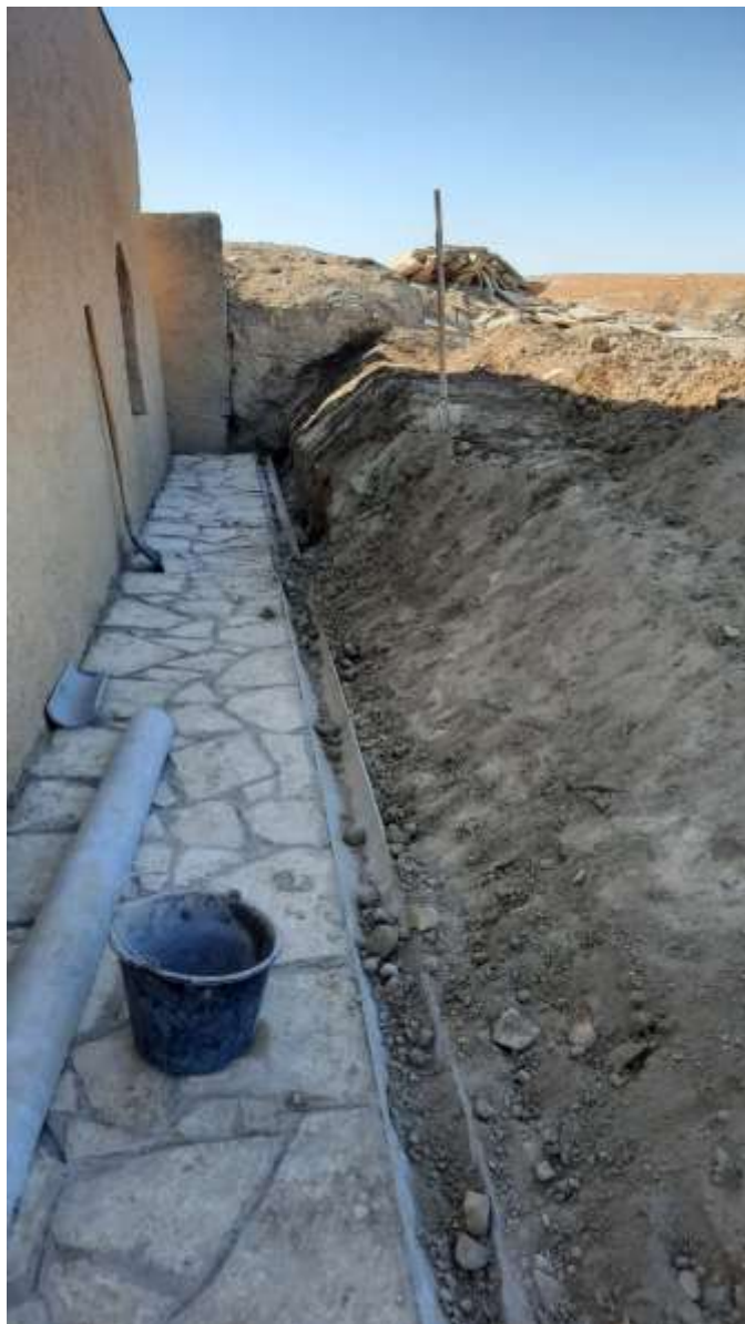
Устройство отмостки, водоотводного лотка
