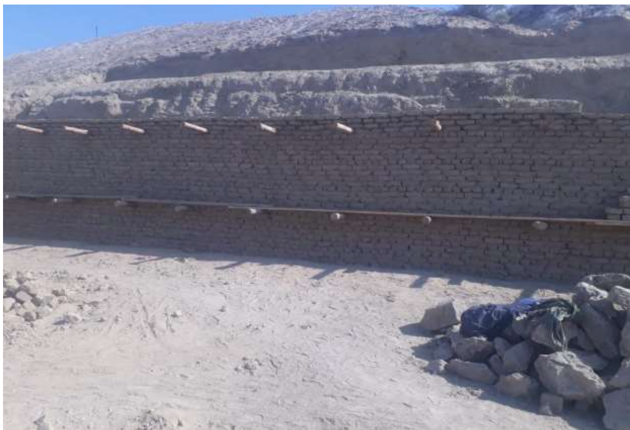
Армирование стен деревянными стержнями
