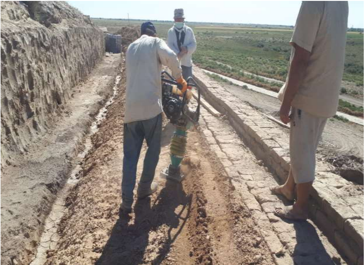
Реставрация и воссоздание кирпичной кладки оставшейся части стены длиной 45 м
