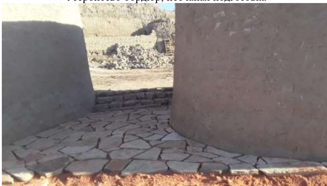
Дорожка и площадь Устройство бордюра, песчаная подготовка
