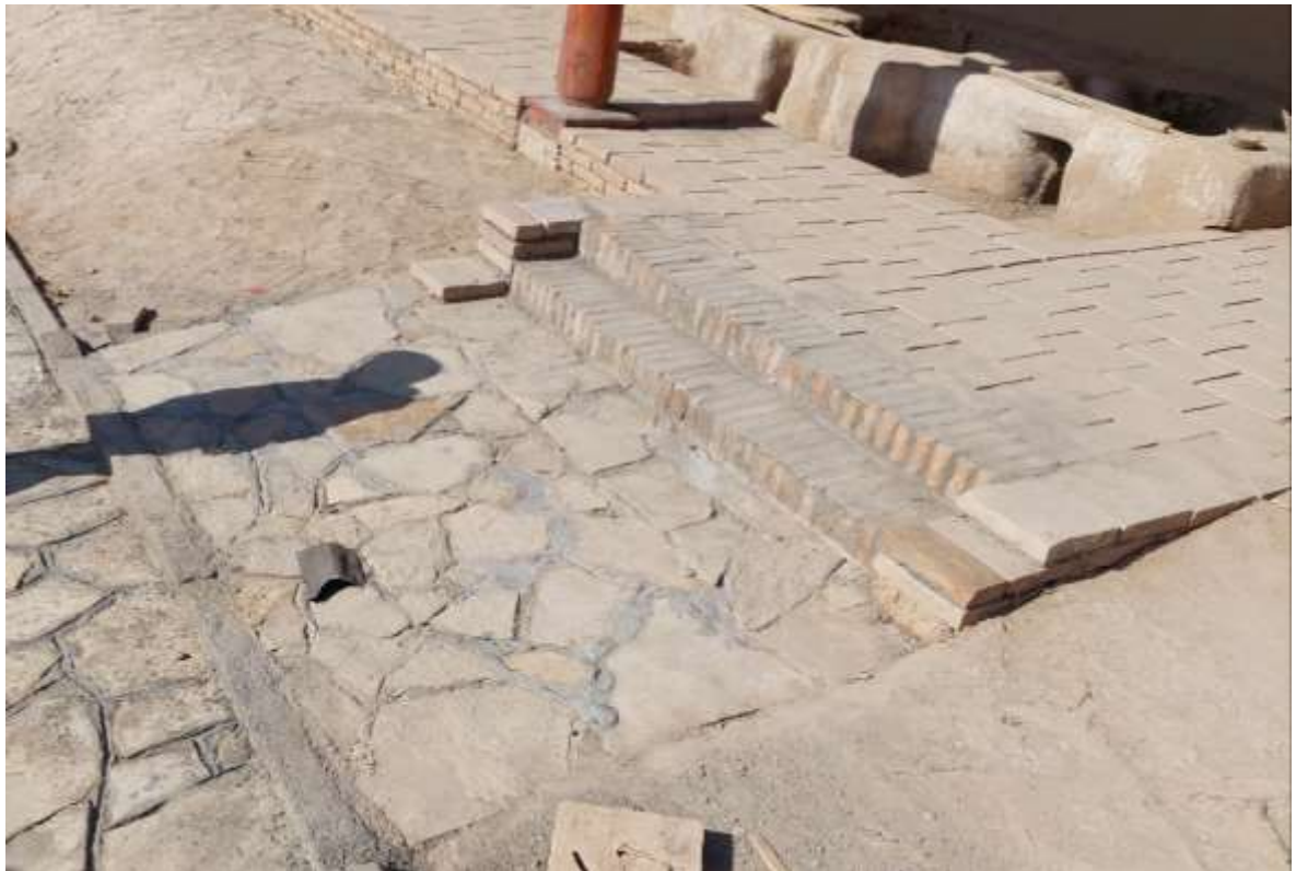
Пятно 7. Жилые дома XVI-XVII века. Устройство фундамента под обкладку из камня песчаника
