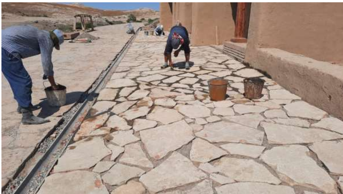
Устройство покрытий площадки из камня песчаника и устройство водоотводного лотка
