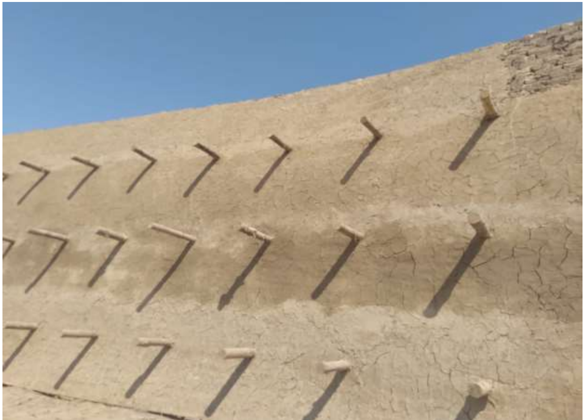
Штукатурка крепостной стены. Штукатурка крепостной стены 1-ый слой
