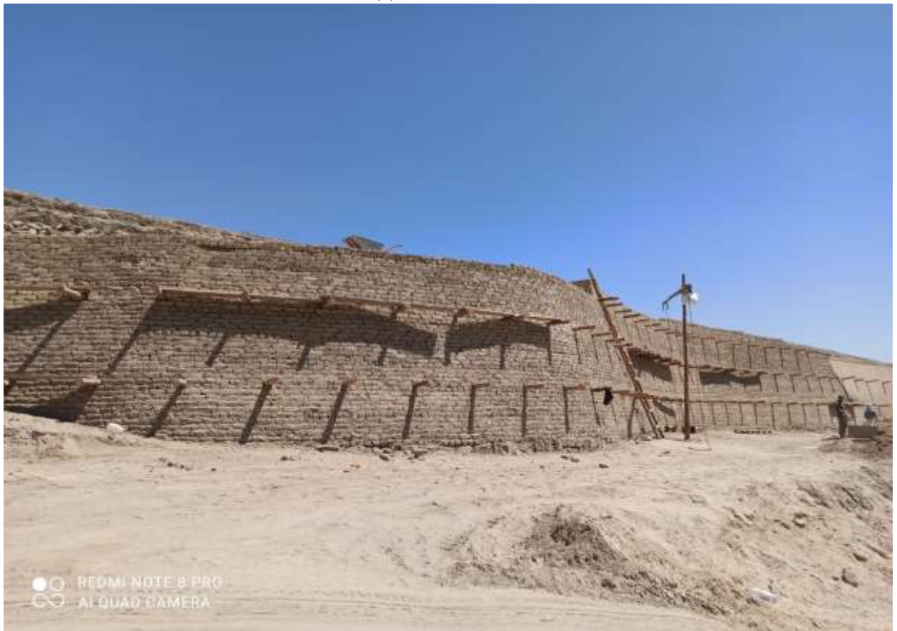
Реставрация и воссоздание кирпичной кладки оставшейся части стены длиной 45 м
