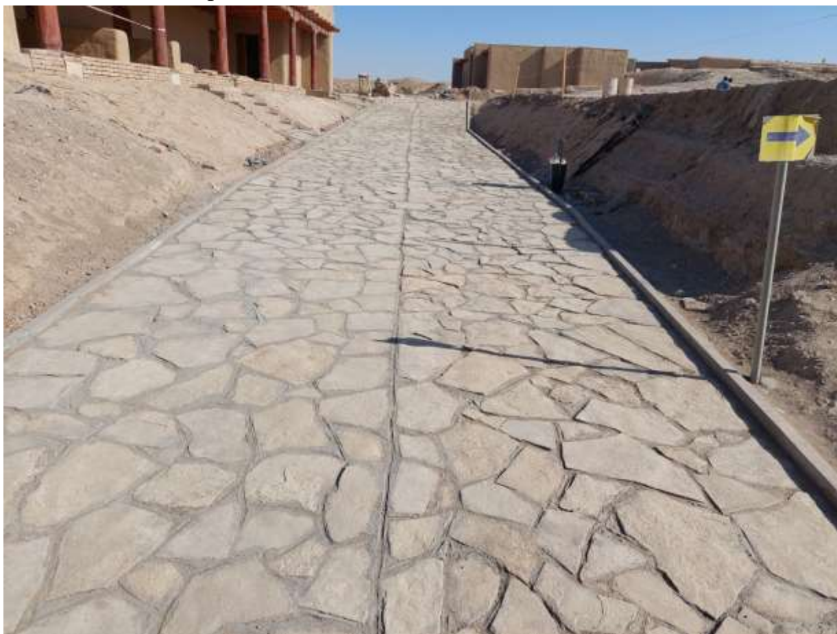
Устройство камня плитняка, заполнение швов
