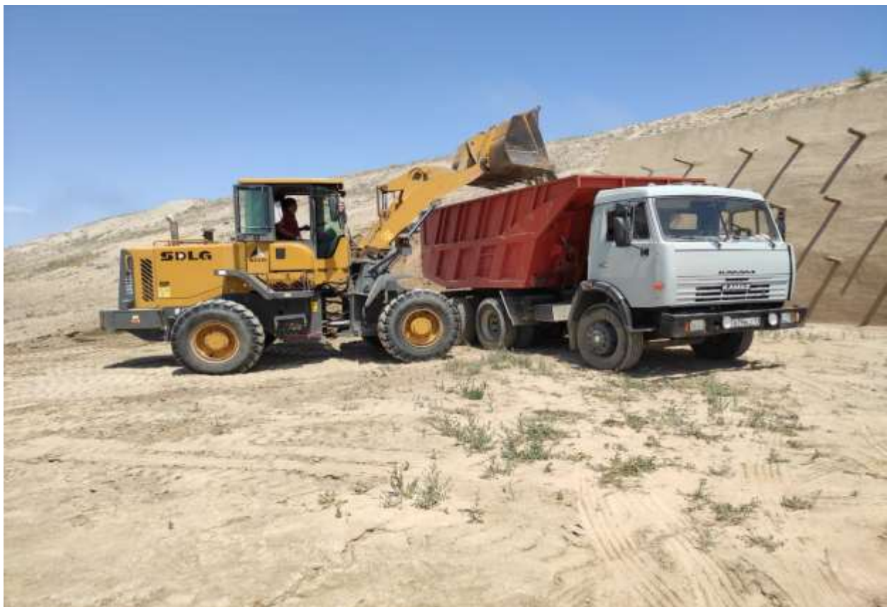
Погрузка и перевозка вывозимого грунта
