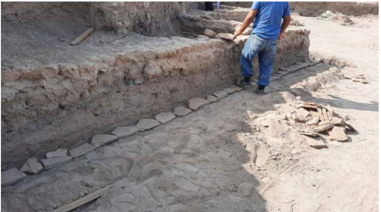
Консервационно-реставрационные работы Пятно 5 и 6 Консервационная кладка из сырцового кирпича Устройство фундамента под обкладку из камня песчаника
